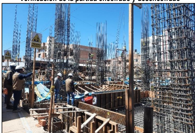
Imagen n.º 2 Verificación de la partida encofrado y desencofrado
