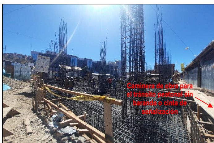
Imagen n.º 7 Caminera para el tránsito peatonal sin baranda o cinta de señalización
