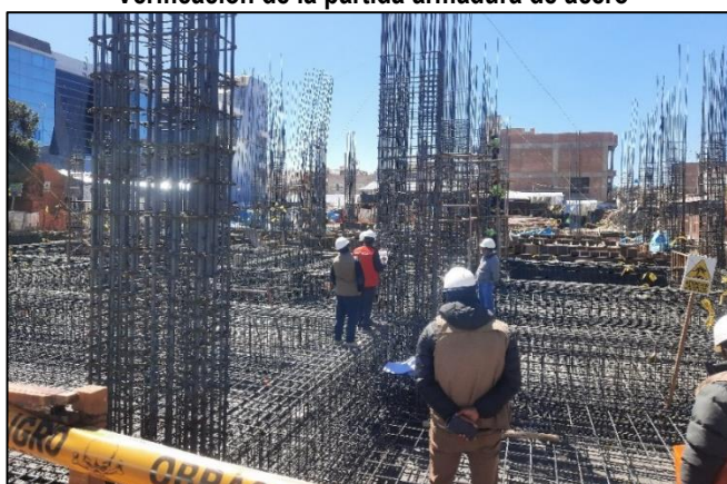
Imagen n.º 1 Verificación de la partida armadura de acero
