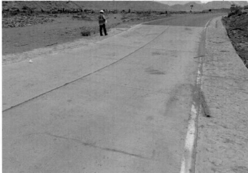
Imagen n.º7 Badén ubicado entre las progresivas del (km 6+676 al km 6+695)
