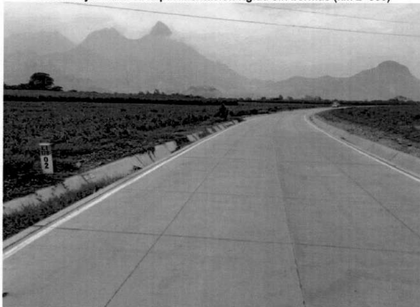
Imagen n.º11 Sección ejecutada en la pavimentación rígida sin bermas (km 2+000)
