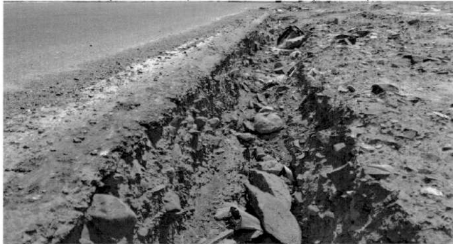
Imagen n.º6 Sección ejecutada en la pavimentación flexible (km 6+000)
