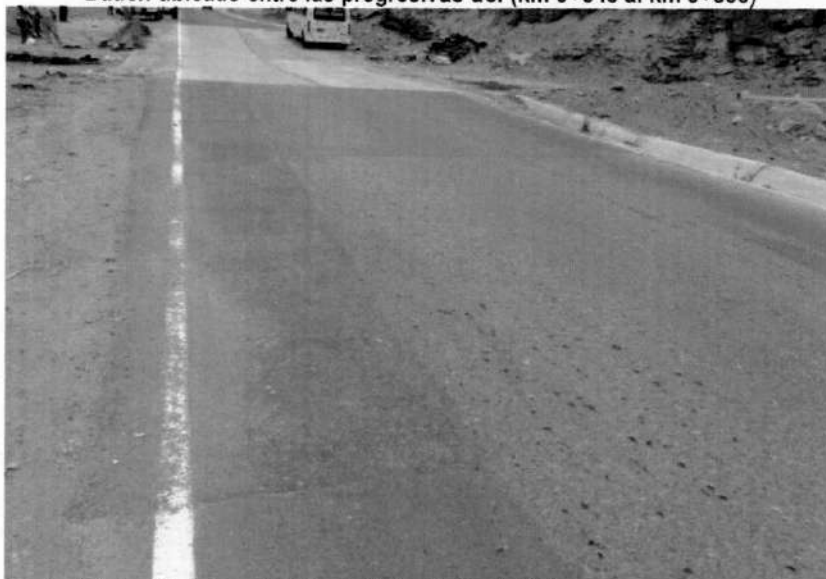
Imagen n.º 8 Baden ubicado entre las progresivas del (km 9+843 al km 9+868)
