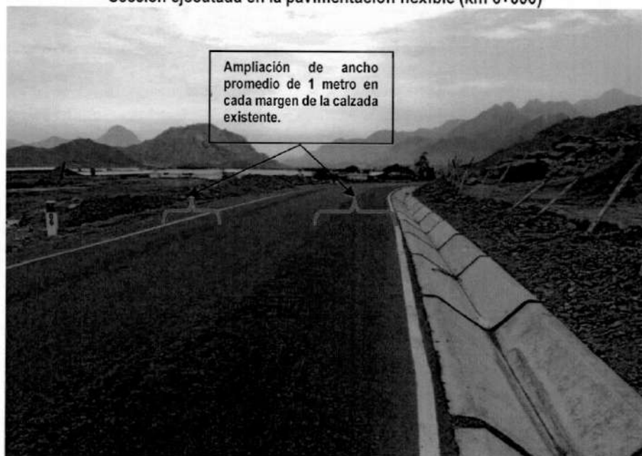
Imagen n.º 5 Sección ejecutada en la pavimentación flexible (km 6+000)
