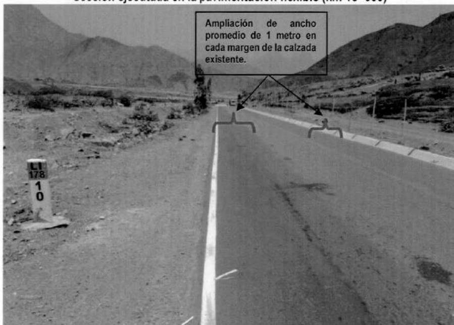
Imagen n.º3 Sección ejecutada en la pavimentación flexible (km 10+000)
