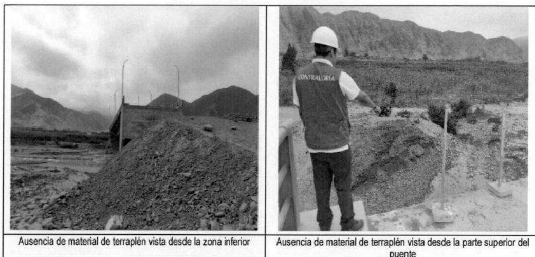
Imágenes n.ºs 22 y 23 Acceso lado izquierdo del puente
