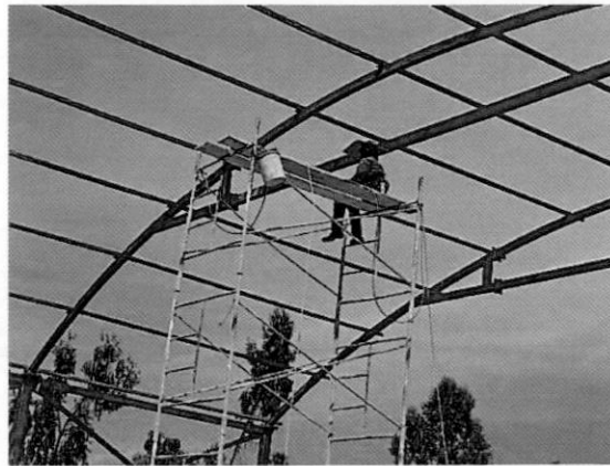
Estructura metálica, losa deportiva de la IE de 01/06/2022"
