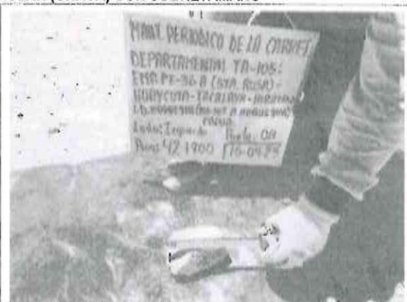
Imagen n.º 5.2: Verificación del tipo o composición del material proveniente de la excavación (calcata) de la progresiva 42+900, verificando el tamaño de la piedra mayor a 3 pulgadas.
