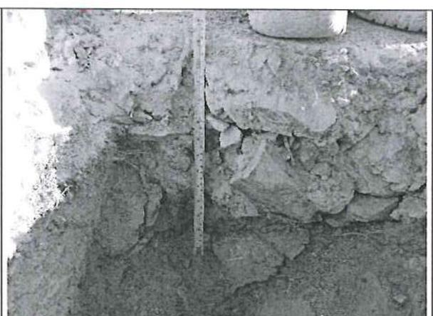
El dado de anclaje de salida del acueducto 01 del tramo II de la línea de conducción mide 1,45x1,50x0,35 metros y no se advierte el encofrado y tarrajeo de sus caras laterales. Se observa una cantidad de piedra que supera el 30% en el concreto ciclópeo.
