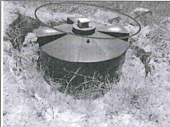
El quinto tanque biodigestor se encuentra instalado parcialmente y expuesto a la intemperie y rayos solares, además, la zanja se encuentra ubicada a 1,00 metro de distancia de un talud pronunciado, lo cual no permitiría la construcción de los pozos percoladores o zanjas de infiltración.
