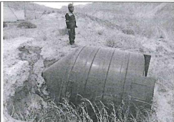
El cuarto tanque biodigestor no se encuentra instalado, solamente se encuentra apoyado en una zanja de forma circular, colocado de manera lateral y completamente expuesto a la intemperie y los rayos solares.
