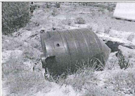
Se aprecia que el tanque biodigestor se encuentra expuesto a la intemperie y sin ningún tipo de protección, siendo susceptible a robos o daños por parte de terceros.
