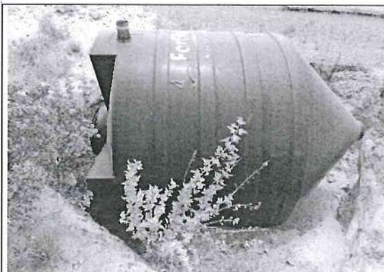
El tercer tanque biodigestor no se encuentra instalado, solamente se encuentra apoyado en una zanja de forma circular, colocado de manera lateral y completamente expuesto a la intemperie y los rayos solares.
