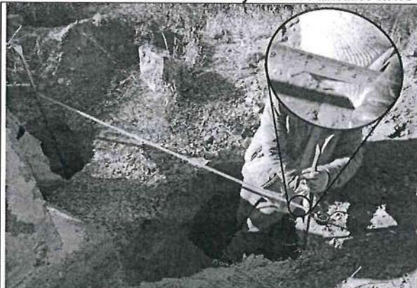
La zapata de ingreso del acueducto 03 del tramo II de la línea de conducción mide 1,95x2,10x0,45 metros, además se advierte que no se realizó encofrado ni tarrajeo de las caras laterales de la zapata.
