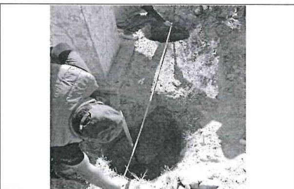
La zapata de salida del acueducto 04 del tramo II de la línea de conducción mide 2,10x2,10x0,45 metros, además se advierte que no se realizó encofrado ni tarrajeo de las caras laterales de la zapata (presenta superficies irregulares).
