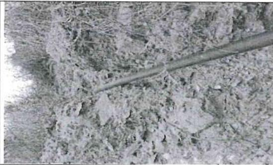
Tramo de tubería HDPE de 63mm del tramo 2 de la línea de conducción que se instalada sin cama de apoyo, sin relleno protector con material seleccionado y sin un relleno compactado con material seleccionado.
