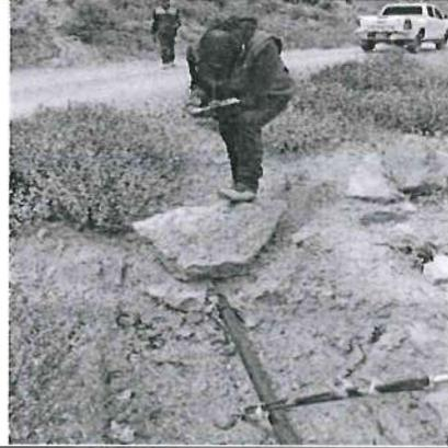
La tubería HDPE de 63mm se encuentra se encuentra instalada sin cama de apoyo, sin relleno protector con material seleccionado y sin un relleno compactado con material seleccionado.
