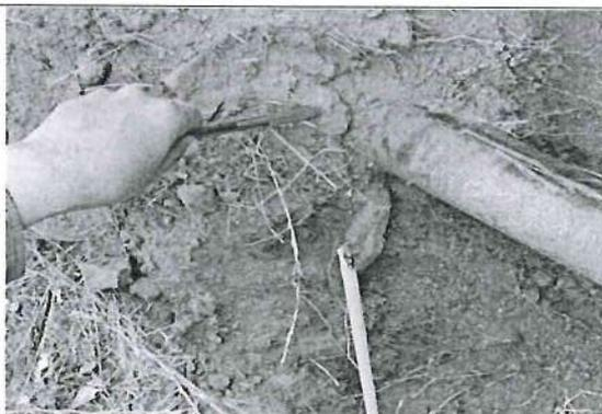
Se aprecia bloques de piedra muy cerca de la tubería HDPE de 63mm, lo cual evidencia que no existe cama de apoyo ni relleno protector con material seleccionado.
