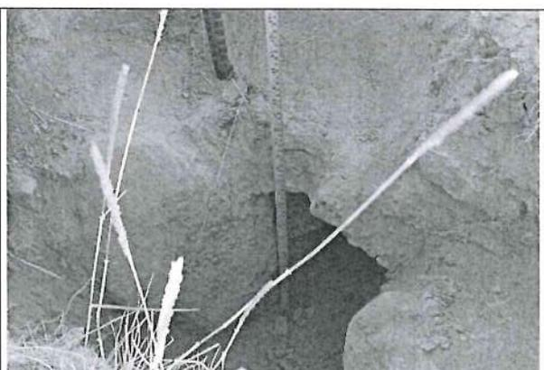
La zapata de salida del acueducto 04 del tramo II de la línea de conducción tiene una altura o espesor de 0,45 metros, además se advierte la presencia de bloques de piedra en el concreto.
