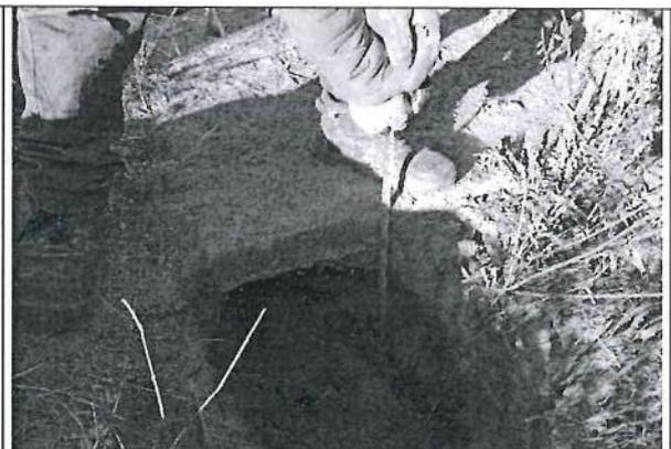
Dado de anclaje del ingreso del acueducto 02 del tramo II de la línea de conducción mide 1,80x1,60x0,40 metros, advirtiéndose no se realizó encofrado y tampoco tarrajeo de las caras laterales.
