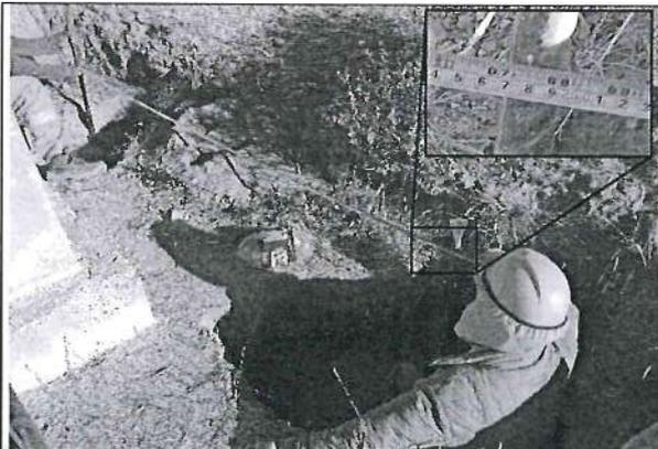
La zapata de salida del acueducto 03 del tramo II de la línea de conducción mide 2,50x2,30x0,60 metros, además se advierte que no se realizó encofrado ni tarrajeo de las caras laterales de la zapata.
