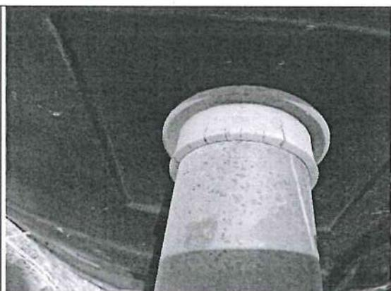
El anillo de goma (jebe) ubicado entre el niple de PVC SAL de 4" y el cuerpo del tanque biodigestor se encuentra deteriorado (presenta grietas) producto de su exposición a la intemperie y los rayos solares.
