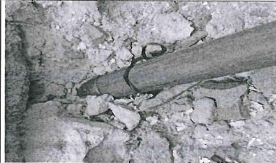
La tubería HDPE de 63mm se encuentra se encuentra instalada sin cama de apoyo, sin relleno protector con material seleccionado y sin un relleno compactado con material seleccionado.
