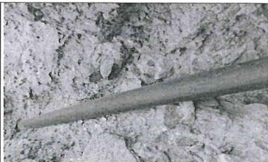
Se aprecia la tubería HDPE de 63mm se encuentra en contacto directo con bloques de piedra.
