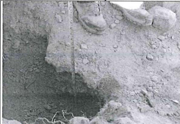
La profundidad de la zapata de salida del acueducto 05 del tramo II de la línea de conducción es de 0,30 metros y sus sección en planta es de 1,30x1,20 metros, además se advierte que no se realizó encofrado ni tarrajeo de las caras laterales de la zapata (presenta superficies irregulares).
