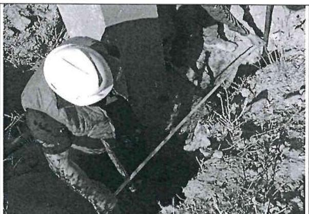
Medición de la zapata de ingreso del acueducto 05 del tramo II de la línea de conducción (1,43x0,40x0,30 metros) y no se advierte el encofrado ni tarrajeo de caras laterales.
