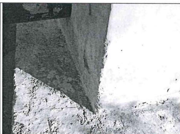
Irregularidades en las esquinas o aristas de las caras laterales de la columna de salida del acueducto 02 del tramo II, así como alambres doblados que se utilizaron para el encofrado, lo cual evidencia que esta columna no fue tarrajada.
