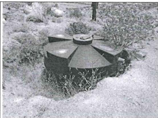
El sexto tanque biodigestor se encuentra instalado parcialmente y expuesto a la intemperie y rayos solares, faltando rellenar una altura de 1,00 metro en promedio.
