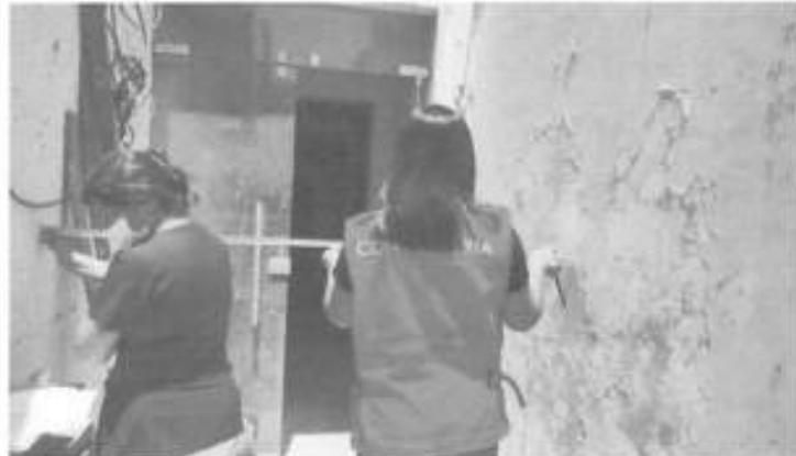
Fotografía n.º 3: Se observa la medición del ingreso a la construcción, siendo el resultado 162 cm.
