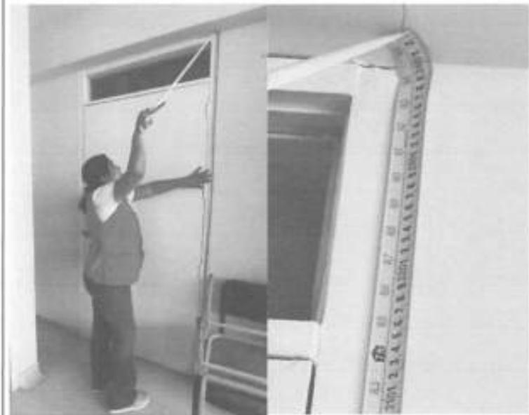
Fotografía n.º 12: Se observa la medición de la puerta de los servicios higiénicos de mujeres. La altura es 2.40m.
