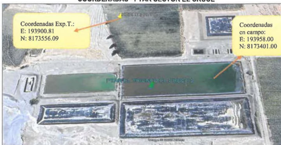
IMAGEN N° 18 COORDENADAS - PTAR SECTOR EL CRUCE
