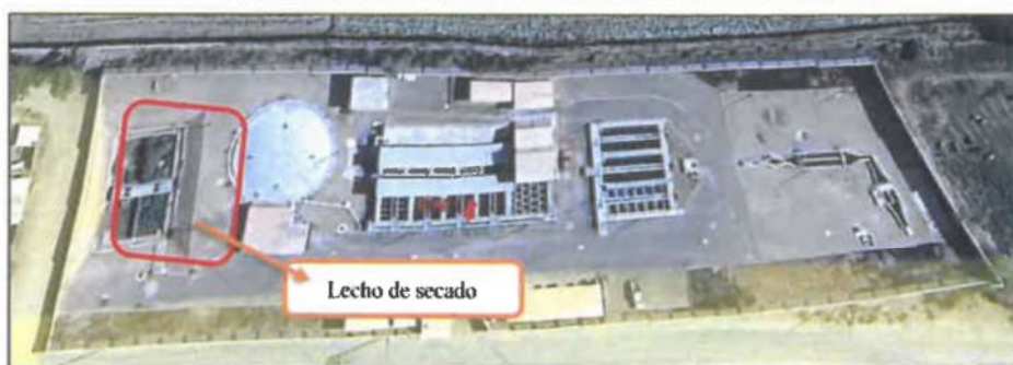
IMÁGEN N° 4 PLANTA DE TRATAMIENTO DE AGUA DE POTABLE- LECHO DE SECADO
