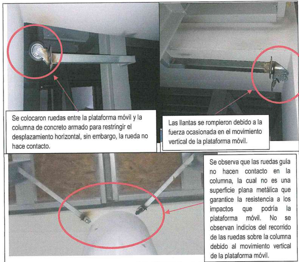
IMAGEN N° 12 VISTA DE COLOCACIÓN DE RUEDAS-GUÍA
