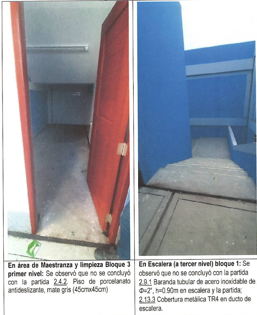
Fotografía n.ºs 31 y 32
