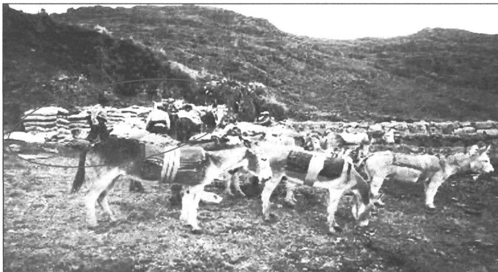
FOTOGRAFIA N° 05: SE REALIZO EL TRASLADO DE LOS MATERIALES EN MULAS HACIA LA REPRESA QUEULLANCA
