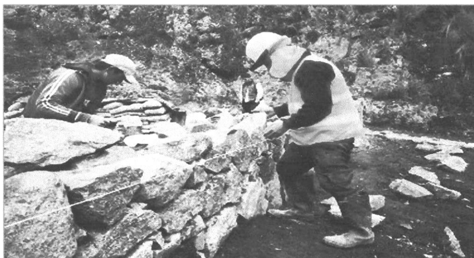
FOTOGRAFIA N° 13: SE VIENE CONTINUANDO CONFORMANDO LAS PAREDES DE MURO DE PIEDRA DEL RESERVORIO
