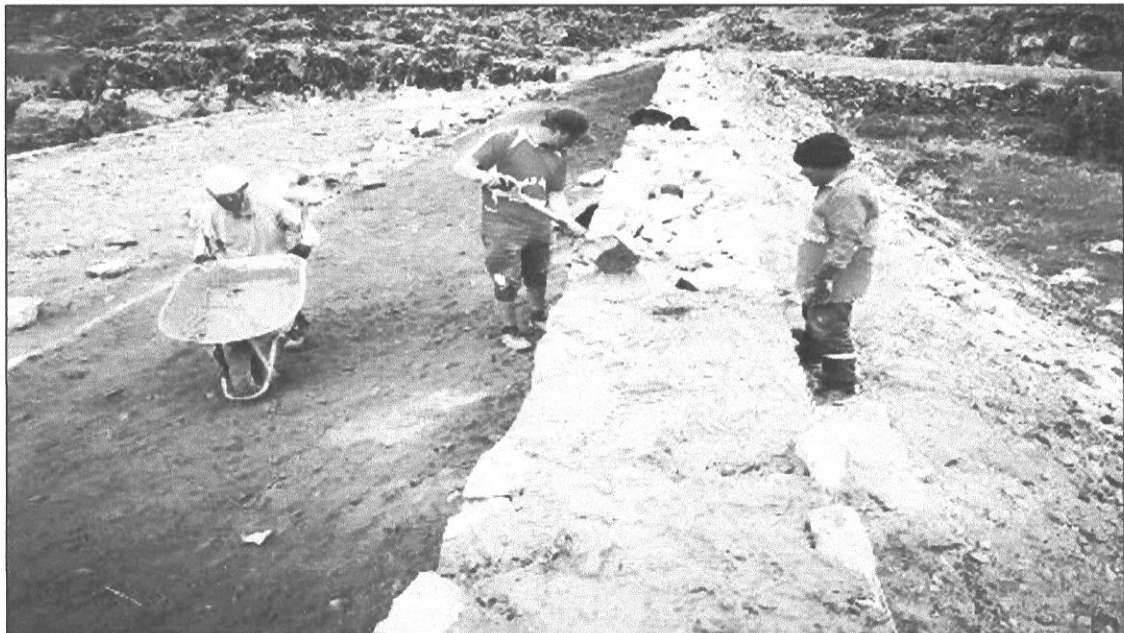
FOTOGRAFIA N° 13: SE VIENE CONTINUA CONFORMANDO LAS PAREDES DE MURO DE PIEDRA DEL RESERVORIO
