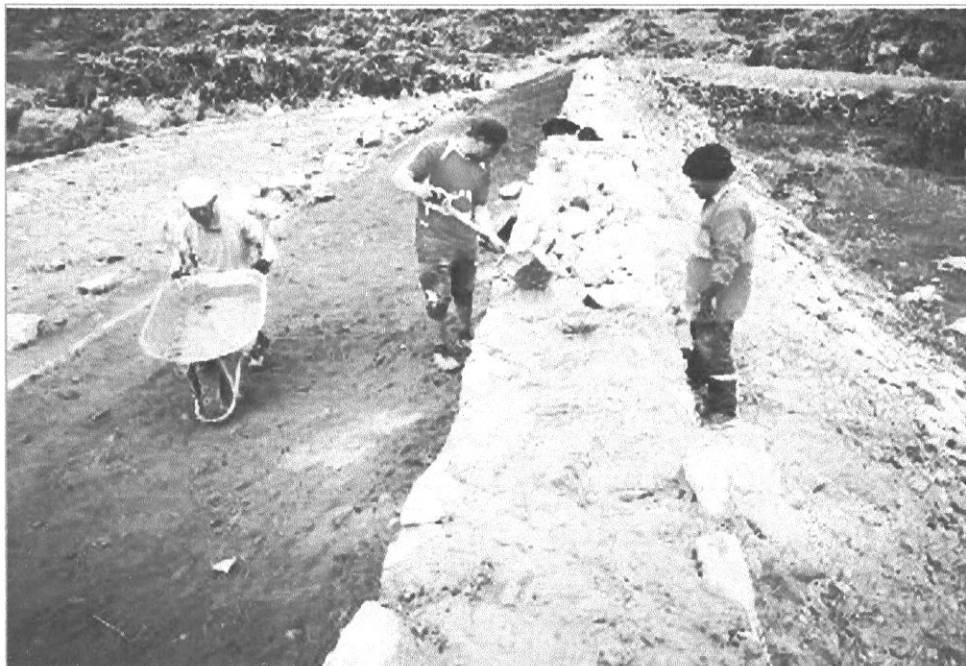
FOTOGRAFIA N° 13: SE VIENE CONTINUANDO CONFORMANDO LAS PAREDES DE MURO DE PIEDRA DEL RESERVORIO
