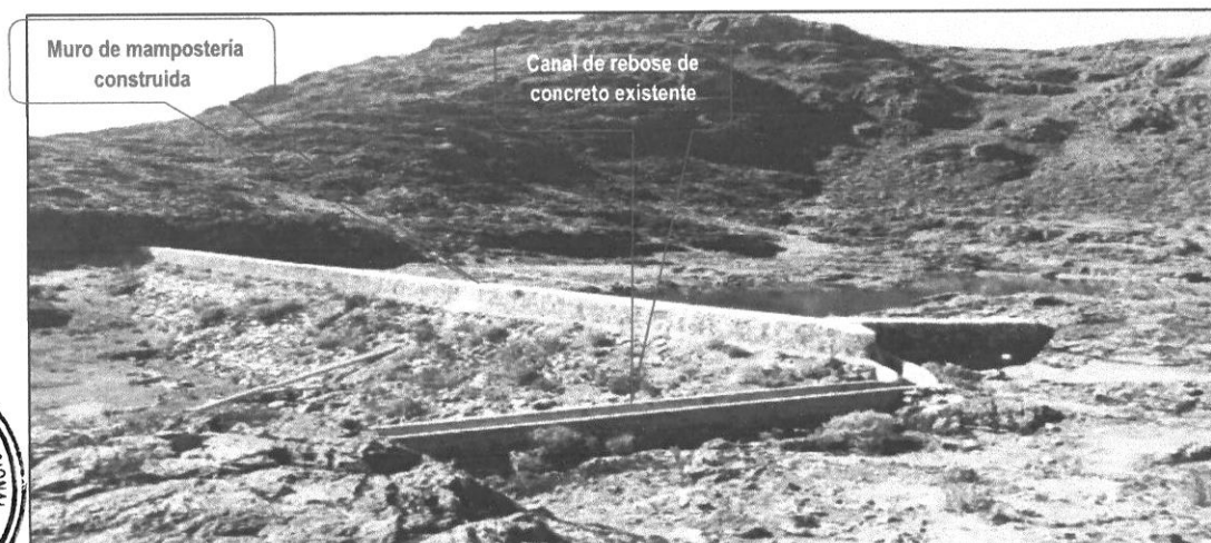
IMAGEN N° 2 MURO DE PIEDRA EMBOQUILLADA Y CANAL DE REBOSE EXISTENTE
