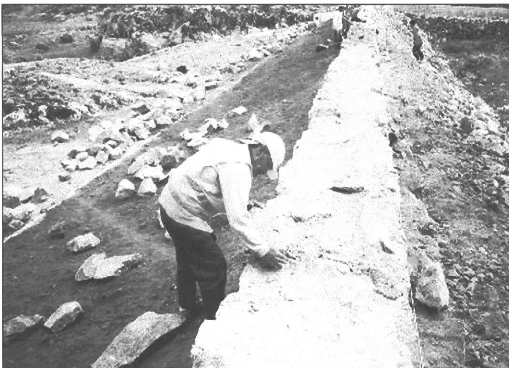
FOTOGRAFIA N° 04: SE CONTINÚA CONFORMANDO LOS EXCOFRADOS PARA EL ENROCAJO DEL MURO DE PIEDRA DE LA REPRESA
