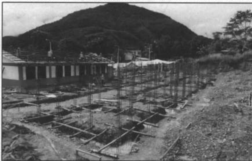
IMAGEN N° 9 CIMENTACIÓN E IZAJE DE ACERO DE LAS COLUMNAS DE LOS BLOQUES A Y B
