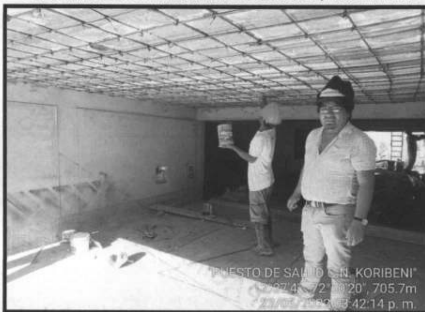
IMAGEN N° 36 REFORZAMIENTO DE LOSA ALIGERADA EN EL BLOQUE B, PARTE INTERIOR
