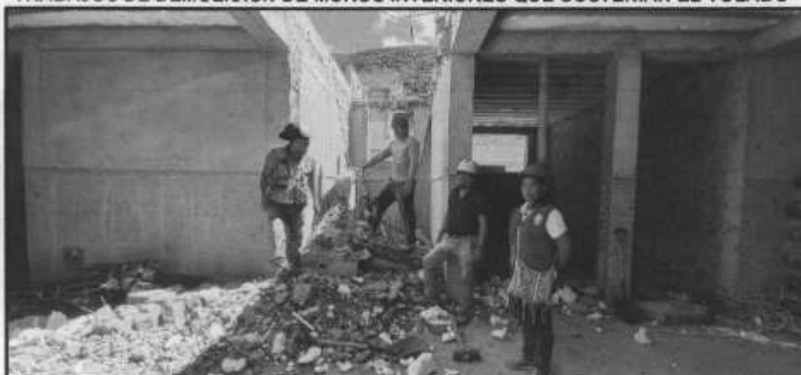
IMAGEN N° 33 TRABAJOS DE DEMOLICIÓN DE MUROS INTERIORES QUE SOSTENÍAN EL VOLADO
