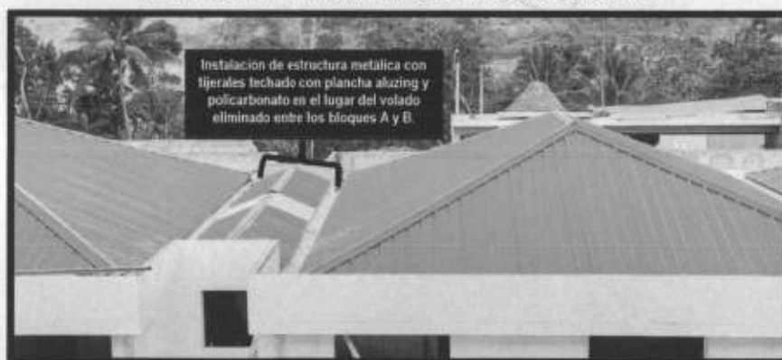
IMAGEN N° 34 INSTALACIÓN DE ESTRUCTURA METÁLICA CON TIJERALES TECHADO CON PLANCHA ALUZINC Y POLICARBONATO
