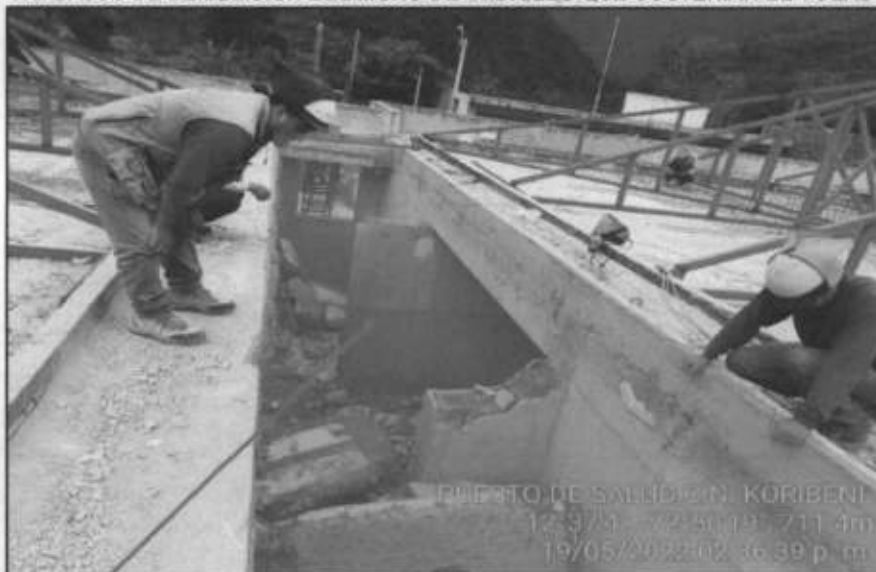
IMAGEN N° 32 TRABAJOS DE DEMOLICIÓN DEL MURO DE LADRILLO QUE SOSTENÍAN EL VOLADO
