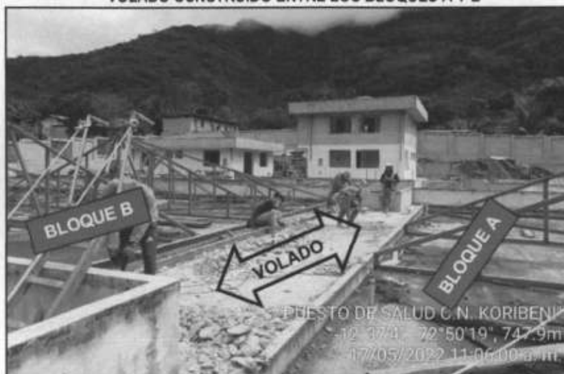
IMAGEN N° 16 VOLADO CONSTRUIDO ENTRE LOS BLOQUES A Y B
