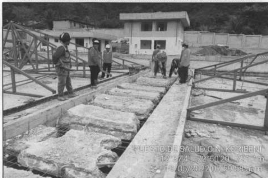
IMAGEN N° 31 TRABAJOS DE DEMOLICIÓN DEL VOLADO UBICADO ENTRE EL BLOQUE A Y B
