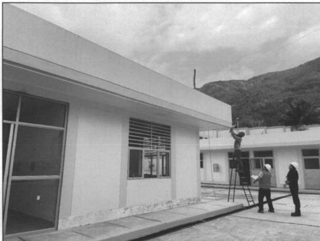
IMAGEN N° 26 VOLADO CONSTRUIDO EN EL BLOQUE B
