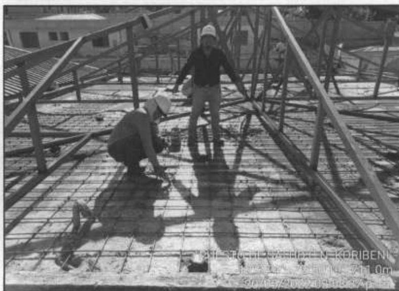
IMAGEN N° 35 REFORZAMIENTO DE LOSA ALIGERADA EN EL BLOQUE B, PARTE SUPERIOR
