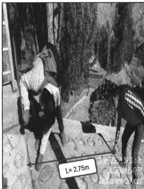
Tramo Pac - Pac: En la progresiva 00+005.95 se realizó la medición de las dimensiones de la gradería obteniendo como resultado 2,75m de longitud (paso).
