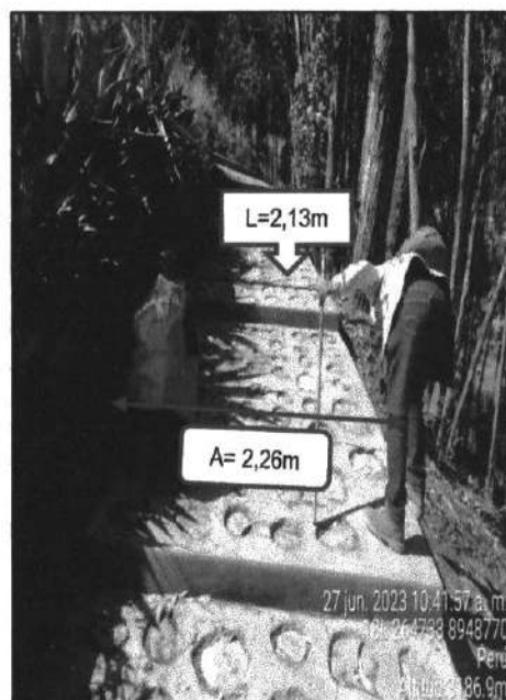
Tramo Shushumia: Se realizó la medición de las dimensiones de la gradería obteniendo como resultado 2,26m de ancho y 2,13m de longitud (paso).
