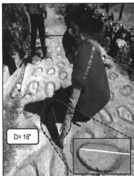
Tramo Pac - Pac: Se realizó la medición del diámetro de las piedras asentadas en las graderías de concreto, obteniendo como resultado 0,40m (16").
