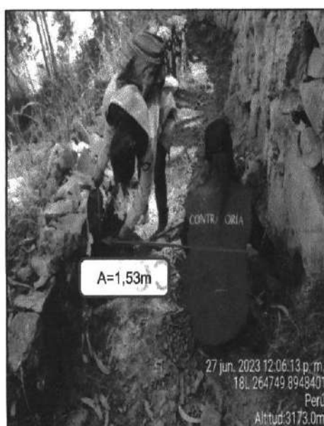
Tramo camino al cementerio: Se realizó la medición del ancho de vía obteniendo como resultado 1,53m.
