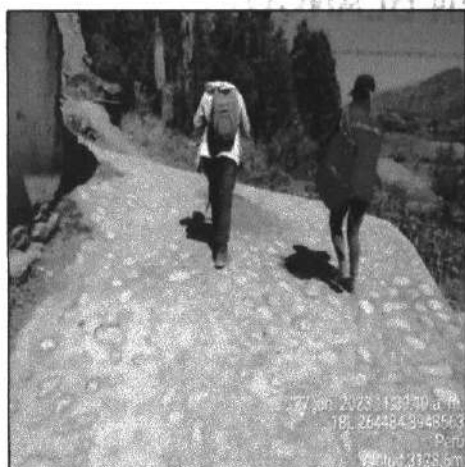
Tramo Camino al cementerio: Entre las progresivas 00+240.00 y 00+306.00, durante el presente año se ejecutó el emboquillado de concreto mediante actividad de mantenimiento.
