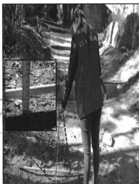
Tramo Pac - Pac: Se realizó la medición del desnivel del terreno obteniendo como resultado 0,06m de altura a nivel del suelo del camino de herradura.
