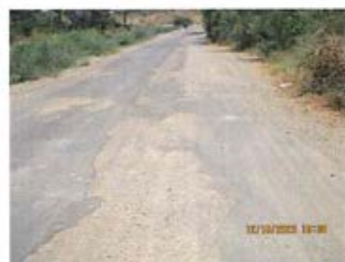
Desprendimiento de Slurry Seal en ambos carriles en la progresiva 28+070.
