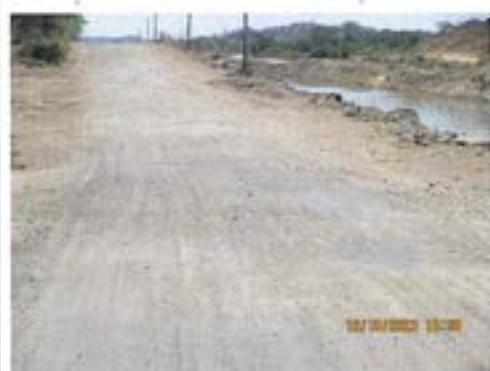
Desprendimiento total de Slurry Seal en ambos carriles en la progresiva 29+830.
