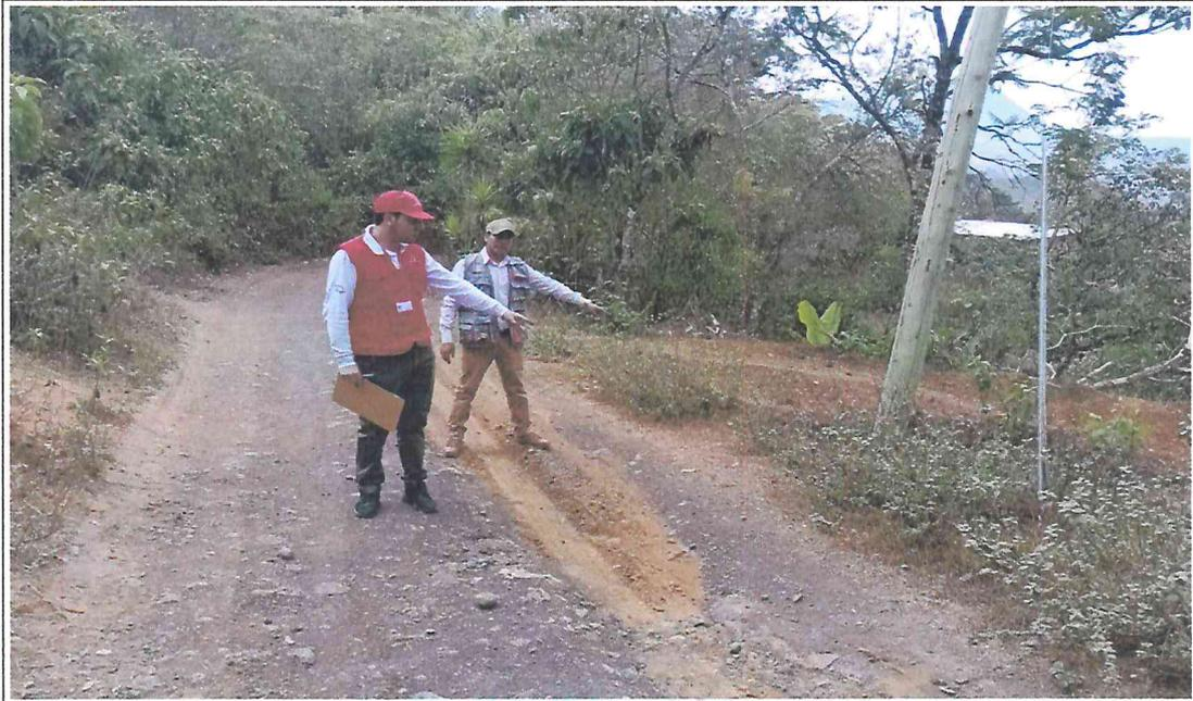
Se observa la no excavación de cunetas al lado izquierdo del camino vecinal- Tramo Pilares
