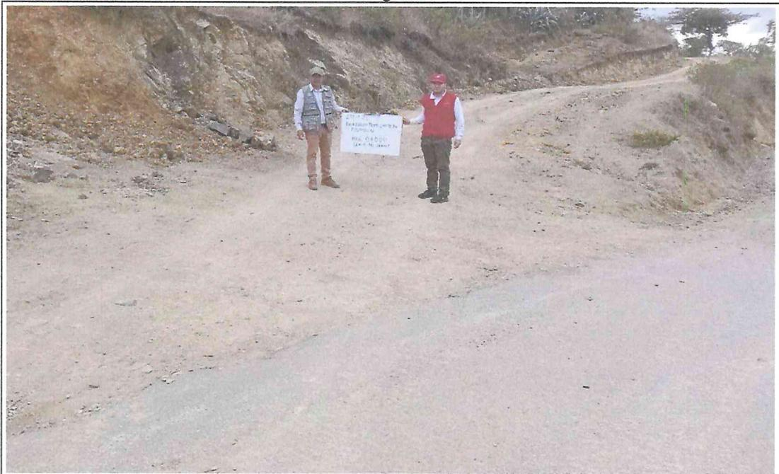
Se observa que desde el inicio del tramo del camino vecinal –progresiva 0+000 la plataforma de la vía es terreno natural, además, no se advierte la existencia de excavaciones de cunetas; asimismo, se observa que el terreno de la vía ha sido recientemente removido.
