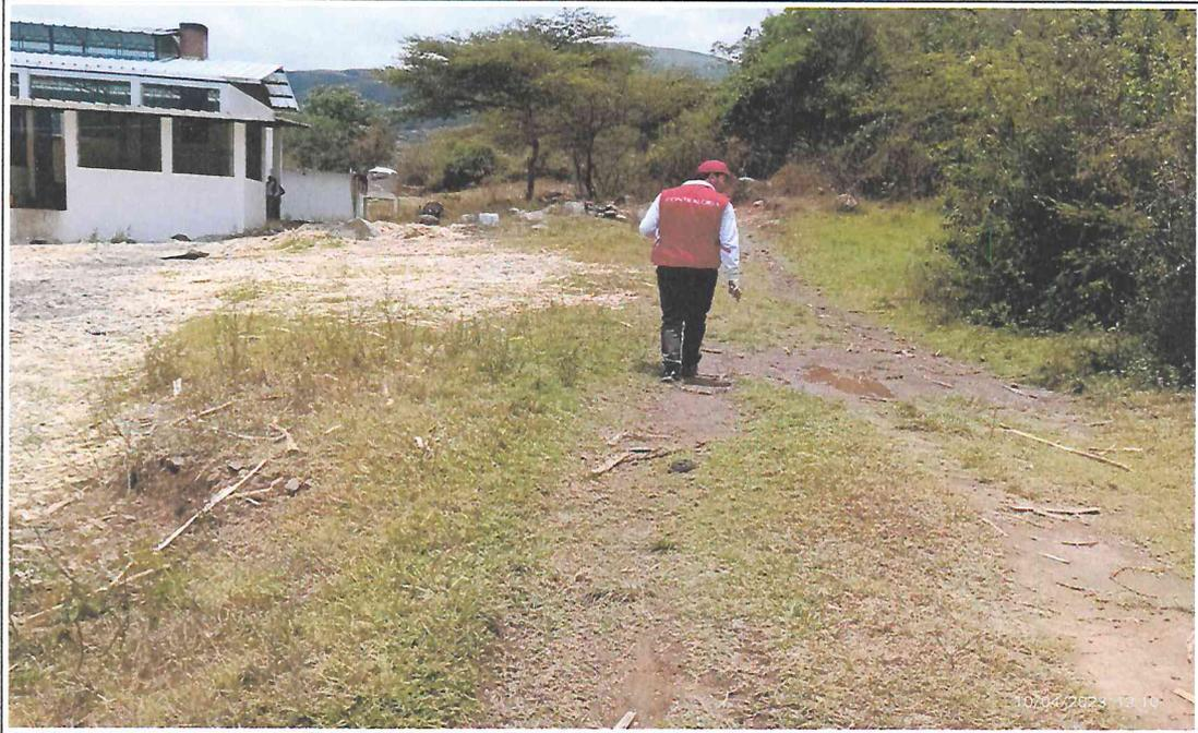
Se observa que la plataforma del camino vecinal tramo Lucumo es terreno natural no advirtiéndose que después de su apertura se haya colocado material de préstamo tales como afirmado y tampoco se advierte la existencia de excavaciones de cunetas, punto de referencia fin del tramo –progresiva 1+030 (Molino de Panela)
