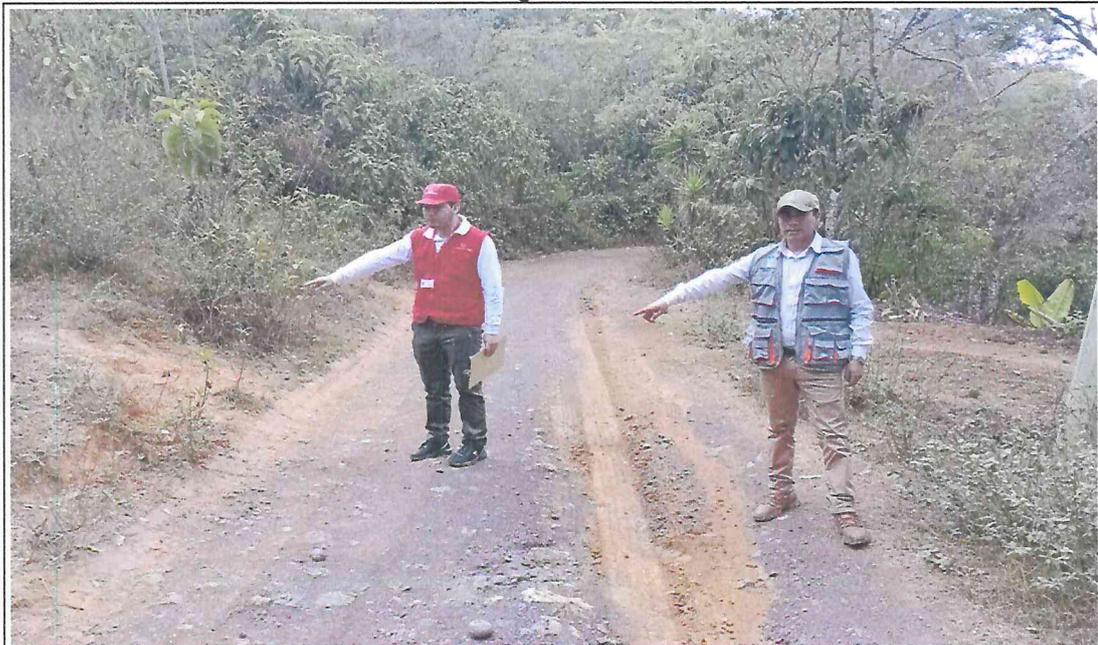
Se observa la no excavación de cunetas al lado derecho del camino vecinal -Tramo Pilares
