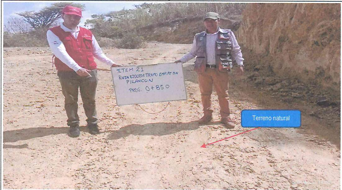
Se observa que la plataforma del camino vecinal es terreno natural no advirtiéndose la existencia de vestigios de material granular que se hayan colocado en la vía, tampoco se advierte que se hayan realizado excavaciones de cunetas, Además, se observa que el terreno de la vía ha sido recientemente removido, punto de referencia progresiva 0+850 antes de llegar a una quebrada seca.
