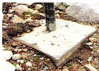
En la progresiva 7+090Km., se muestra que la señalización preventiva, no cuenta con el refuerzo lateral y con las dimensiones mínimas de la cimentación.
