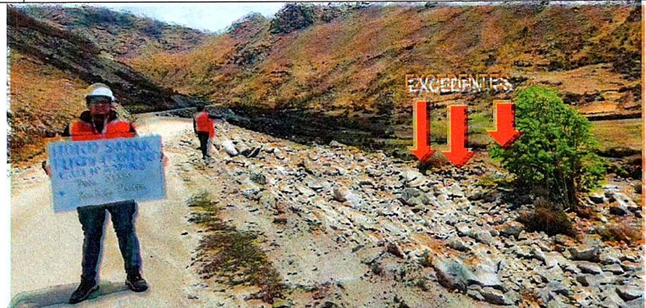
Imagen n.º 28.- En la toma fotográfica desde la **progresiva 5+350 km**, se evidencia que en el tramo posterior hay disposición de excedentes en la ladera de la vía.
