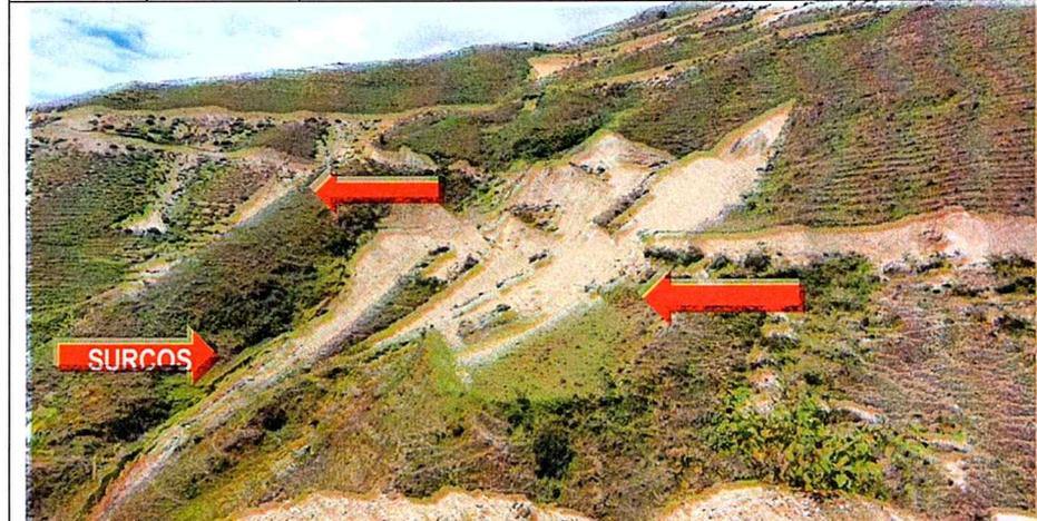
Imagen n.º 34.- En la toma fotográfica desde **la progresiva 10+000 km**, se evidencia que en el tramo anterior se formó surcos y ahuellamientos producto de la disposición de los excedentes en la ladera de la vía.
