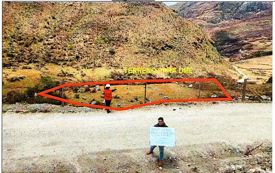
En la imagen se observa que en el terreno proyectado como DME n.º 1 según el Expediente Técnico de Obra, no hay indicios de alteración alguna, tampoco evidenciándose algún acceso hacia la misma.
