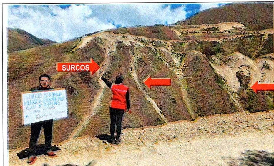
Imagen n.º 38.- En la toma fotográfica desde la **progresiva 10+980 km**, se evidencia que en el tramo anterior se formó surcos y ahuellamientos producto de la disposición de los excedentes en la ladera de la vía.
