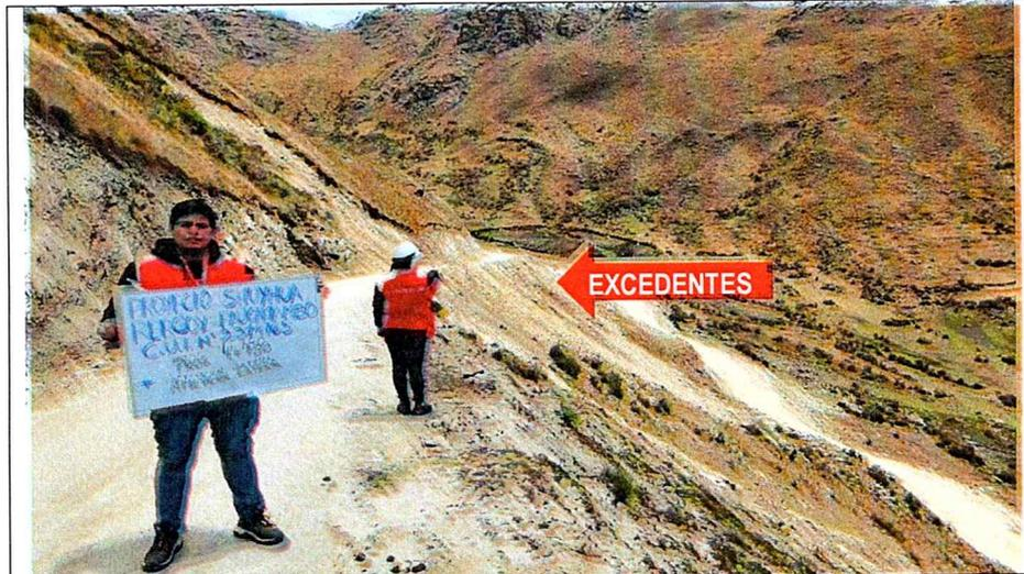
Imagen n.º 27.- En la toma fotográfica desde la **progresiva 4+780 km**, se evidencia que en el tramo posterior hay disposición de excedentes en la ladera de la vía.
