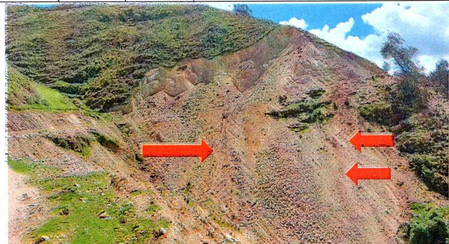
Imagen n.º 39.- En la toma fotográfica desde la **progresiva 12+850 km**, se evidencia que en el tramo anterior se formó surcos y ahuellamientos producto de la disposición de los excedentes en la ladera de la vía.
