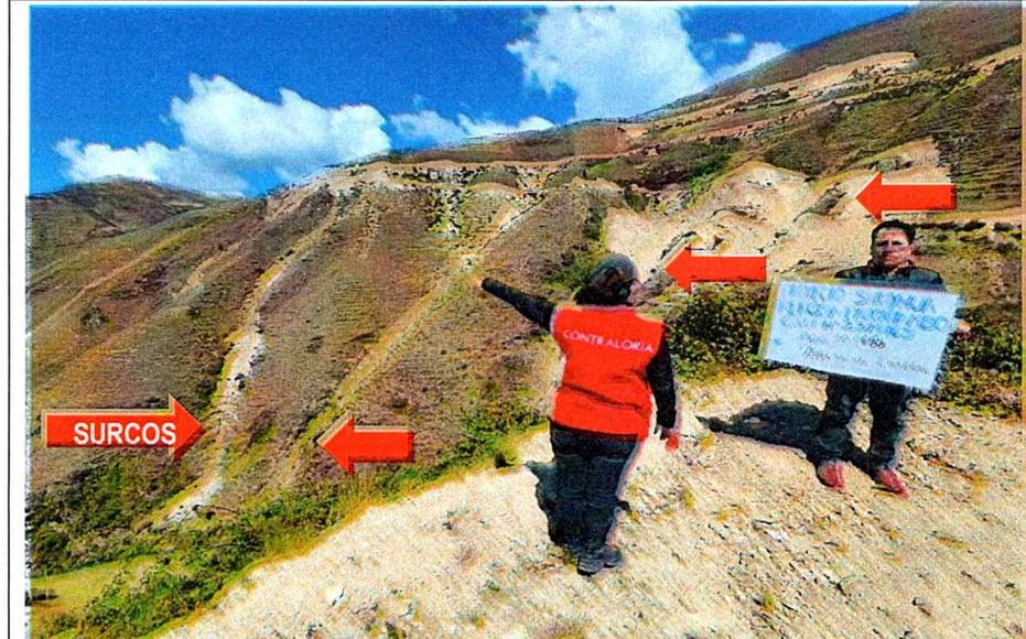
Imagen n.º 35.- En la toma fotográfica desde la **progresiva 10+680 km**, se evidencia que en el tramo anterior se formó surcos y ahuellamientos producto de la disposición de los excedentes en la ladera de la vía.
