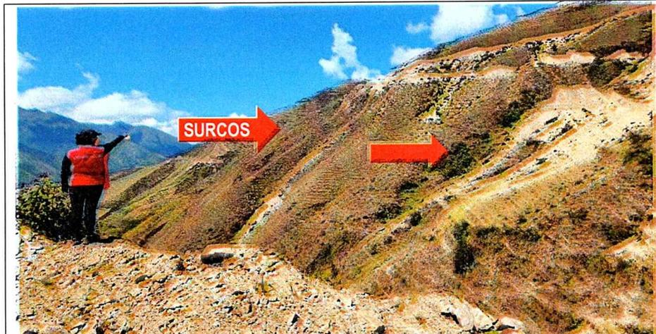
Imagen n.º 33.- En la toma fotográfica desde la **progresiva 10+000 km**, se evidencia que en el tramo anterior se formó surcos y ahuellamientos producto de la disposición de los excedentes en la ladera de la vía.
