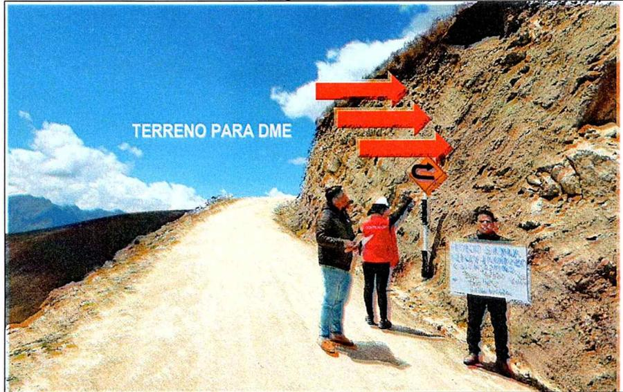
En la imagen se observa que en el terreno usado como DME n.º 2 según el contratista (Planos de Replanteo que obran en la Liquidación Técnica-Financiera), no hay indicios de alteración alguna, más aún que resulta incoherente la disposición de excedentes por hallarse en un talud pronunciado.
