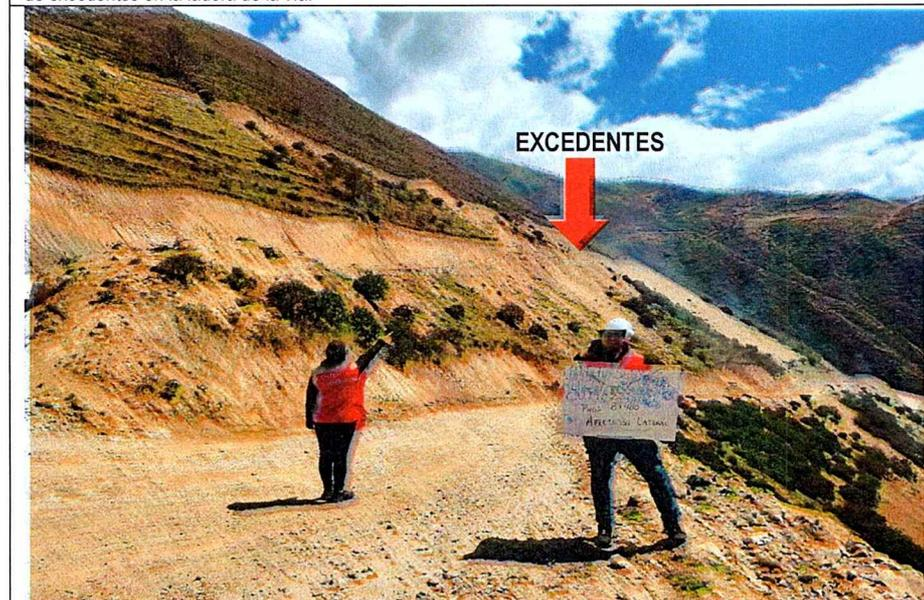
Imagen n.º 32.- En la toma fotográfica desde la progresiva 8+400 km, se evidencia que en el tramo hay disposición de excedentes en la ladera de la vía.
