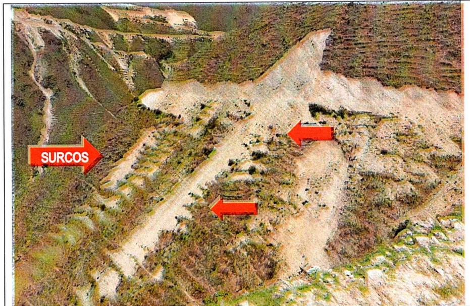
Imagen n.º 36.- En la toma fotográfica desde la **progresiva 10+250 km**, se evidencia que en el tramo anterior se formó surcos y ahuellamientos producto de la disposición de los excedentes en la ladera de la vía.
