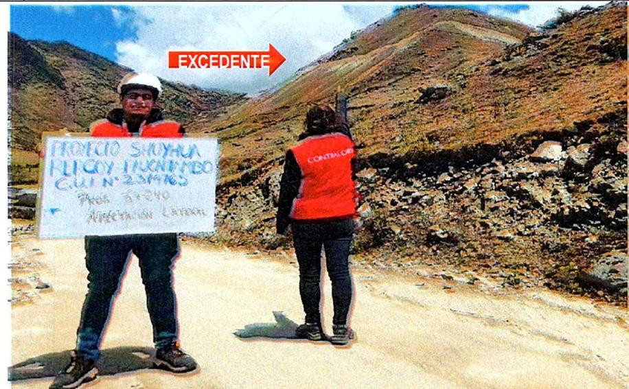
Imagen n.º 29.- En la toma fotográfica desde la **progresiva 6+240 km**, se evidencia que en el tramo anterior hay disposición de excedentes en la ladera de la vía.
