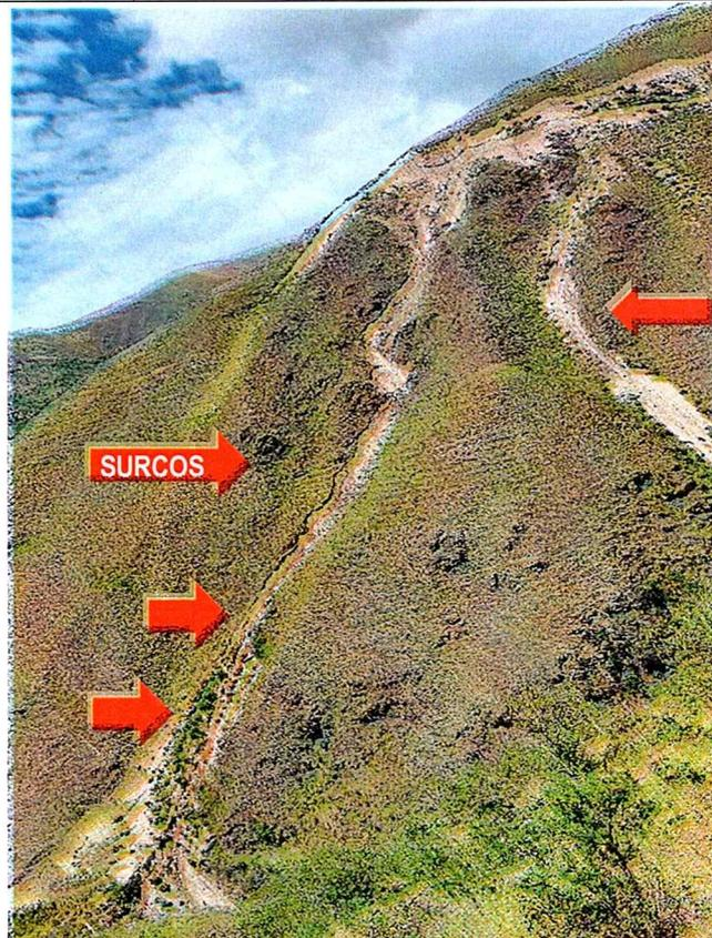
Imagen n.º 37.- Vista donde se aprecia la disposición de material excedente a través de la Progresivas 9+000-10+000 aproximadamente, en el que se evidencia la formación de surcos y ahuellamientos producto de la disposición de los excedentes en la ladera de la vía, afectando el paisaje de la zona.
