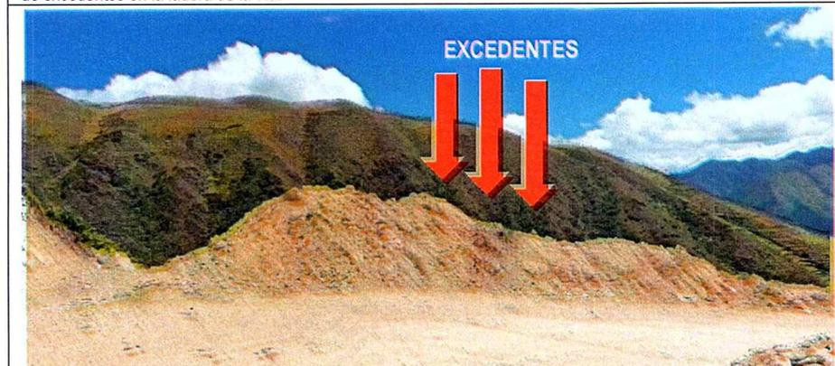
Imagen n.º 31.- En la toma fotográfica desde la progresiva 8+200 km, se evidencia que en el tramo hay disposición de excedentes en la ladera de la vía.
