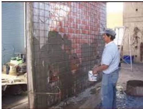
Imagen N° 06: Unión de malla electrosoldada en columnas.
