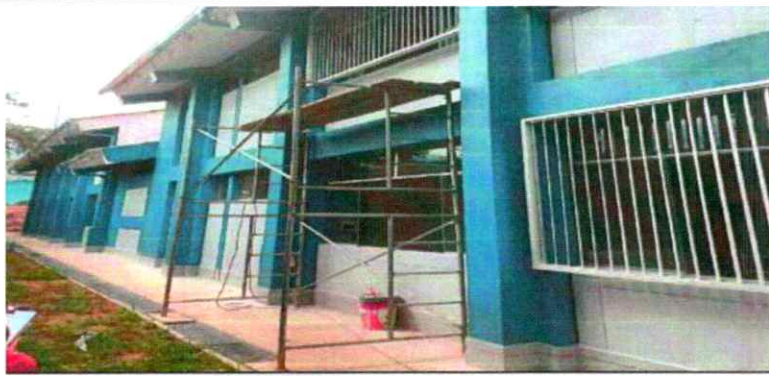
FOTO N° 07: FALTA INSTALACION DE PROTECTORES Y VIDRIOS EN VENTANA. 06/01/2023
