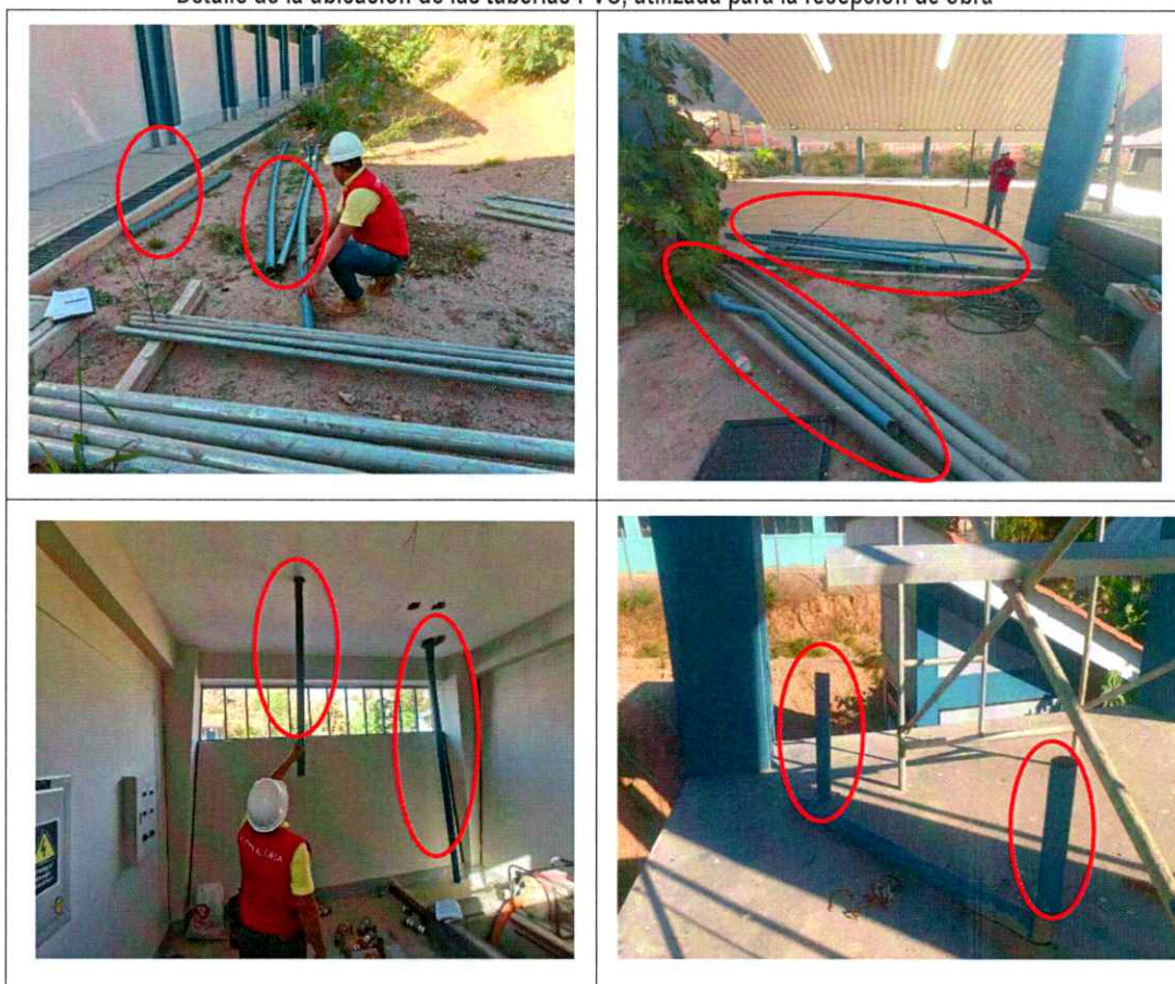
Cuadro n.º 15 Detalle de la ubicación de las tuberías PVC, utilizada para la recepción de obra
