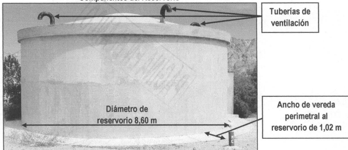
Imagen n.º 13 Componentes del Reservorio
