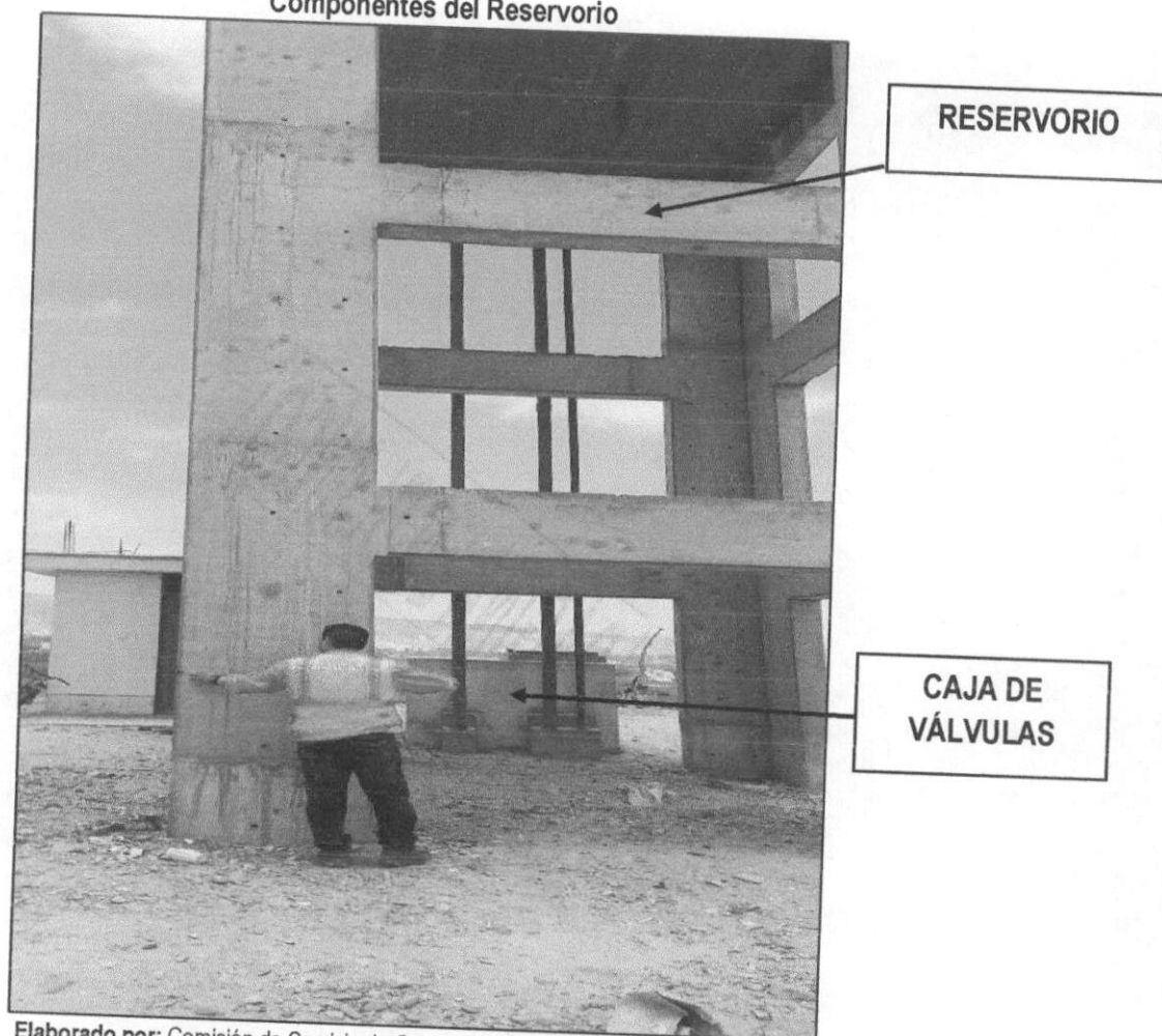
Imagen n.º 17 Componentes del Reservorio
