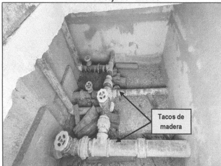
Imagen n.º 7 Interior de caja de válvulas
