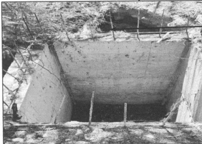
Imagen n. 21 Interior de la estructura inconclusa y sin válvula
