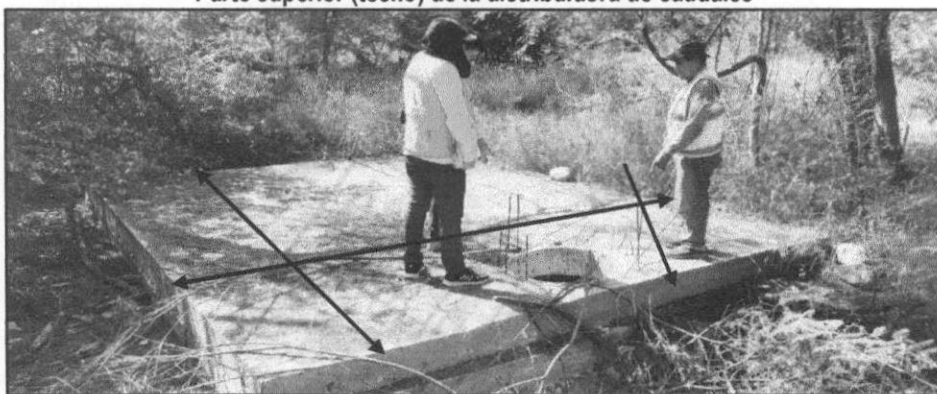
Imagen n.° 18 Parte superior (techo) de la distribuidora de caudales
