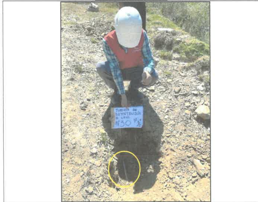
Red de distribución de tubería PVC – SAP Ø 1/2" instalada desde la matriz hasta las UBS del señor Jesús Díaz Figueredo.
