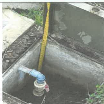
Cámara Rompe Presión, altura 0.60cm
