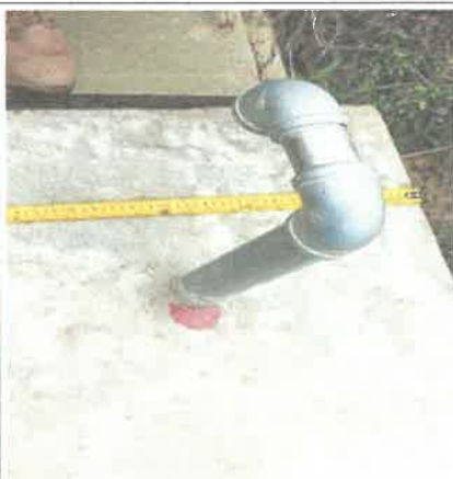
Cámara Rompe Presión, tubería F°G° de ventilación Ø 1"
