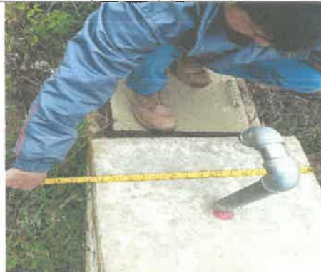
Cámara Rompe Presión, ancho de tapa de concreto 0.60cm
