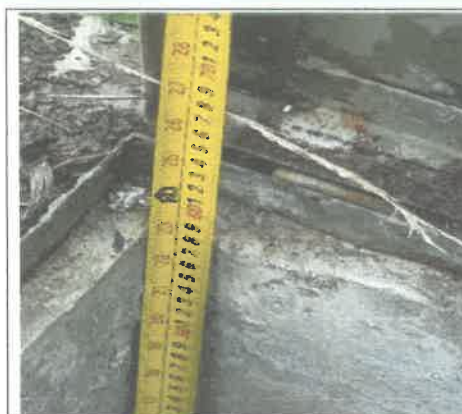
Cámara Rompe Presión, altura 0.60cm
