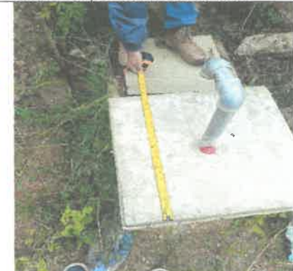
Cámara Rompe Presión, largo de tapa de concreto 0.60cm
