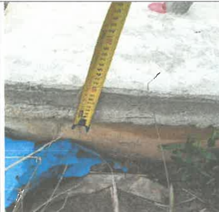
Cámara Rompe Presión, espesor de tapa de concreto 0.10cm
