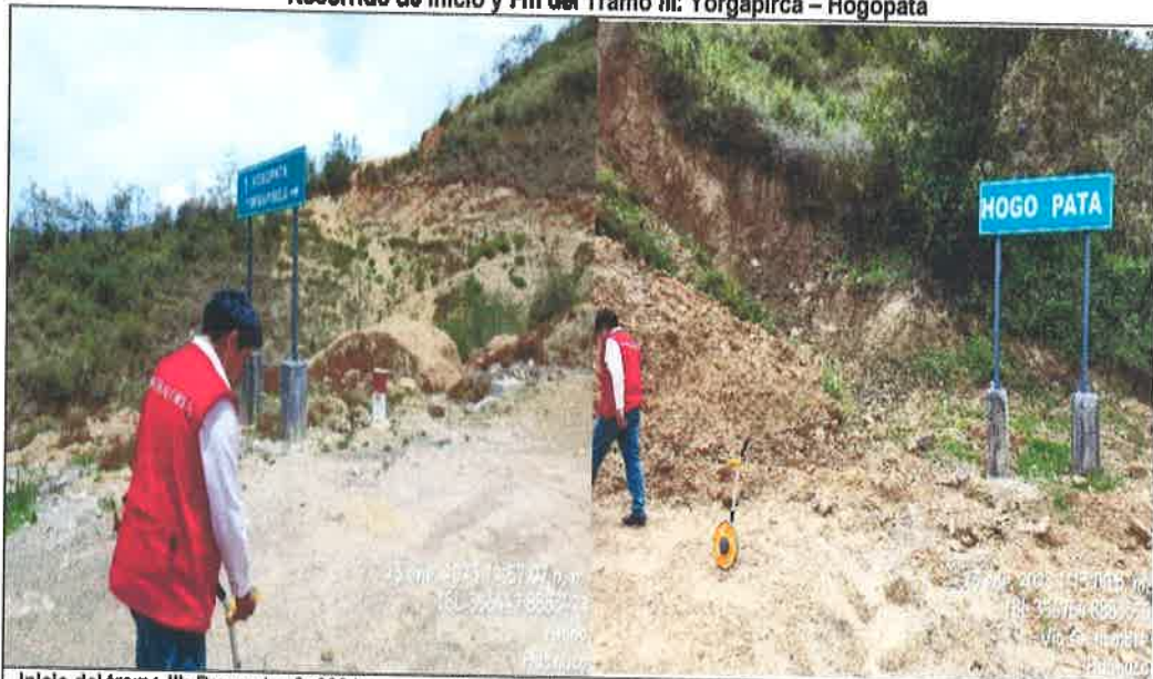
Inicio del tramo III: Progresiva 0+000 km, cruces "Yorgapirca". Fin del tramo III: Progresiva 0+821,49, señal informativa "Hogopata". Fuente: Acta de Inspección de 23 de enero de 2023. (Apéndice n.º 11) Elaborado por: Comisión de Control.
