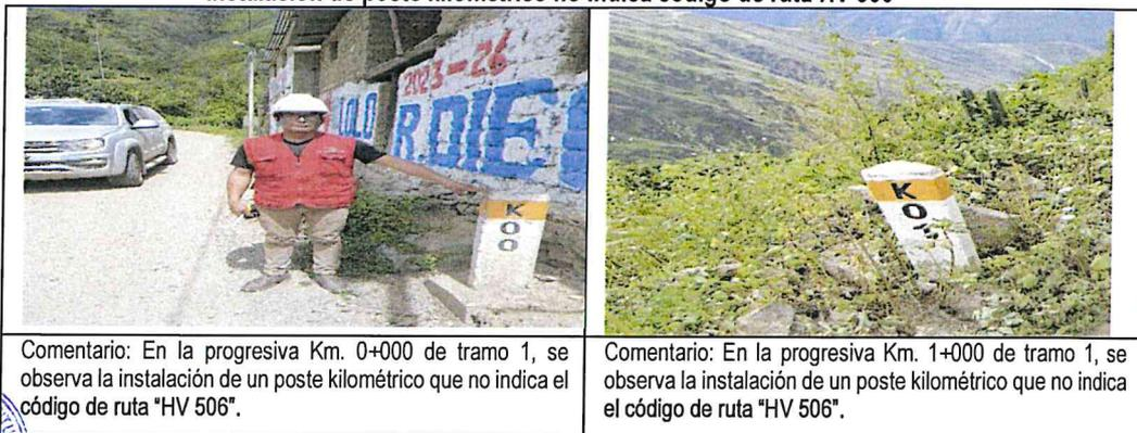
Comentario: En la progresiva Km. 0+000 de tramo 1, se observa la instalación de un poste kilométrico que no indica el código de ruta "HV 506".
