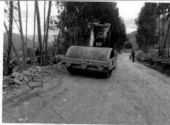
FOTO N° 07: Ing. INSPECTOR y RESIDENTE verificando el compactado de plataforma con maquinaria km 11 + 790.
