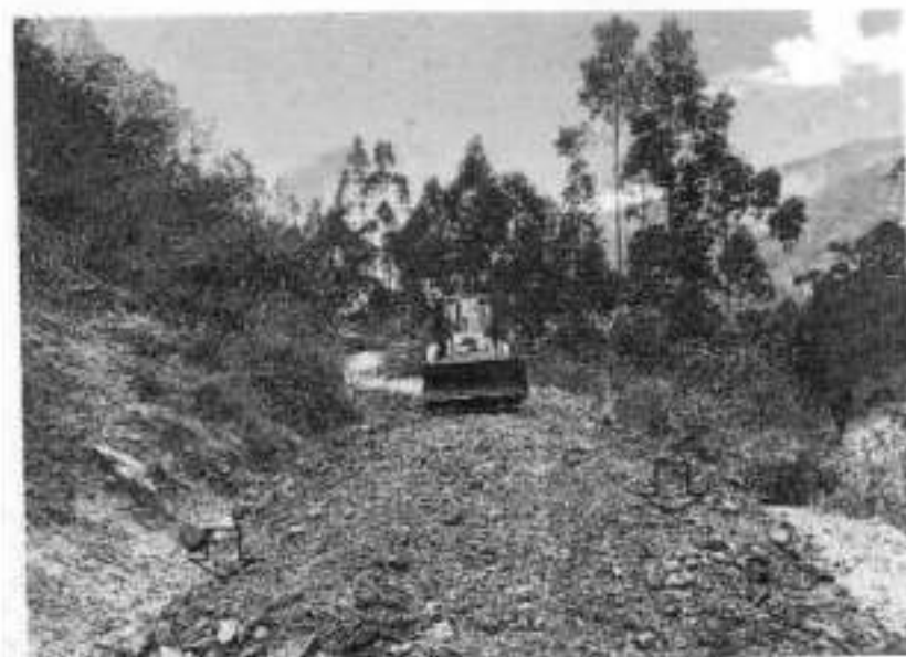
Foto Nro. 03: Extendido del Material Afirmado, Km 9+500.
