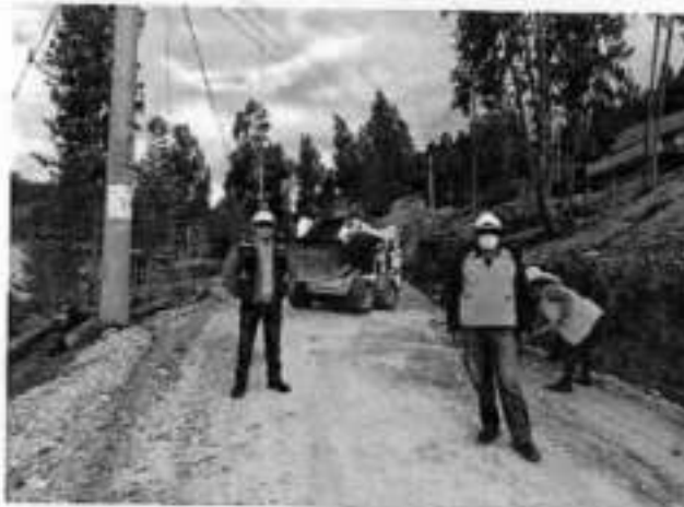
FOTO N° 10: ING. INSPECTOR Y RESIDENTE verificando eliminación de material granular excedente km 10 + 00.
