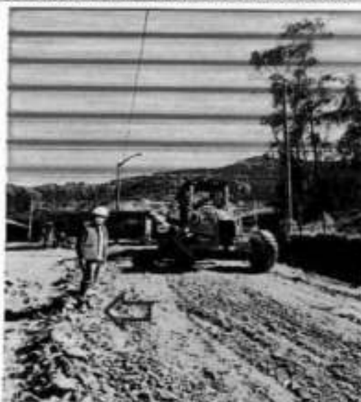
Trabajos con maquinaria pesada (motoniveladora)
