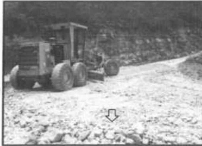
FOTO N° 23: Conformación de material de afirmado, progresiva 7+790 - 7+555 (peralte de curva).
