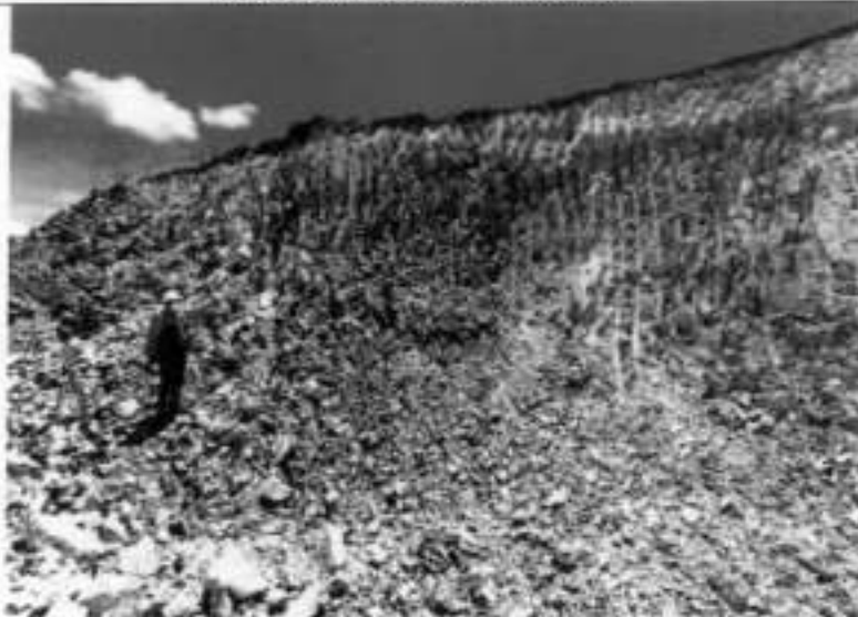
FOTO N° 07: Ing. INSPECTOR, verificando el estado actual de la Cantera Shilluscocha, de donde se extraerá el material de afirmado propuesto por el Contratista en su PLAN DE TRABAJO.
