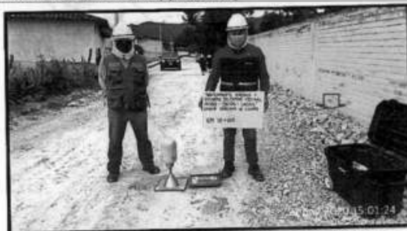
FOTO N° 42: Ensayos de densidad de suelos en el camino vecinal Matara-Jocos-Lacas
