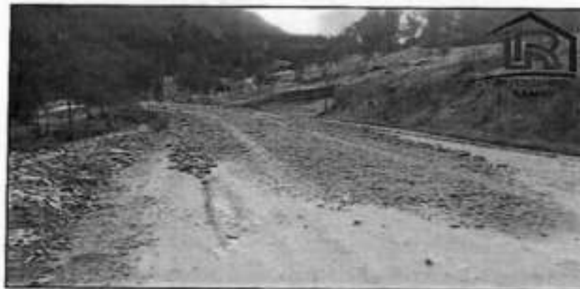
Foto 20: Se realiza el avance de colocación de Material de Afirmado de la Cantera Shilluscocha con motorizadora en la progresiva km+0+000 hasta km + 0+550.
