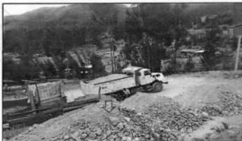
Foto 23: Se avanza con los trabajos de descarga para tendido de material granular de espesor 0.15 m en la progresiva progresiva km=0+550 hasta km= 0+900, con material de CANTERA EL TAMBO.
