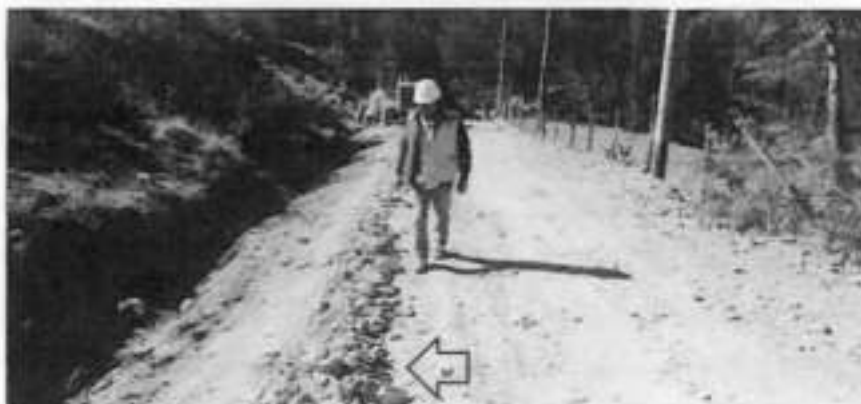
Trabajos con maquinaria pesada (motoniveladora)
