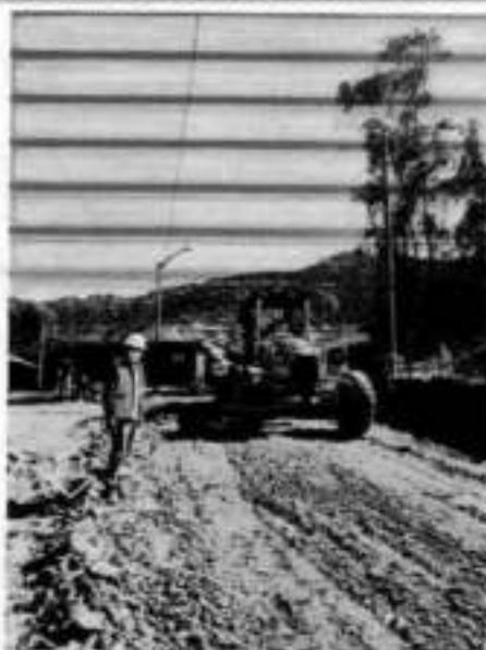
Trabajos con maquinaria pesada (motoniveladora)
