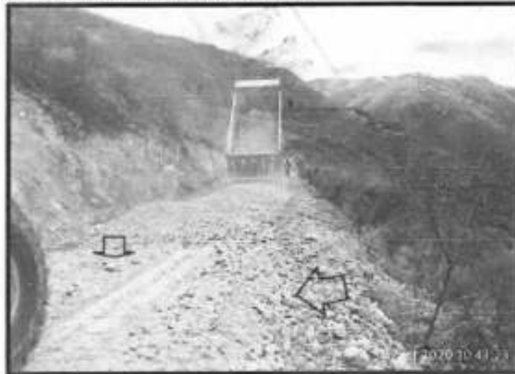
FOTO N° 26: Tendido de afirmado para posterior conformación de capa de 15cm, progresiva 7+130 - 6+955.
