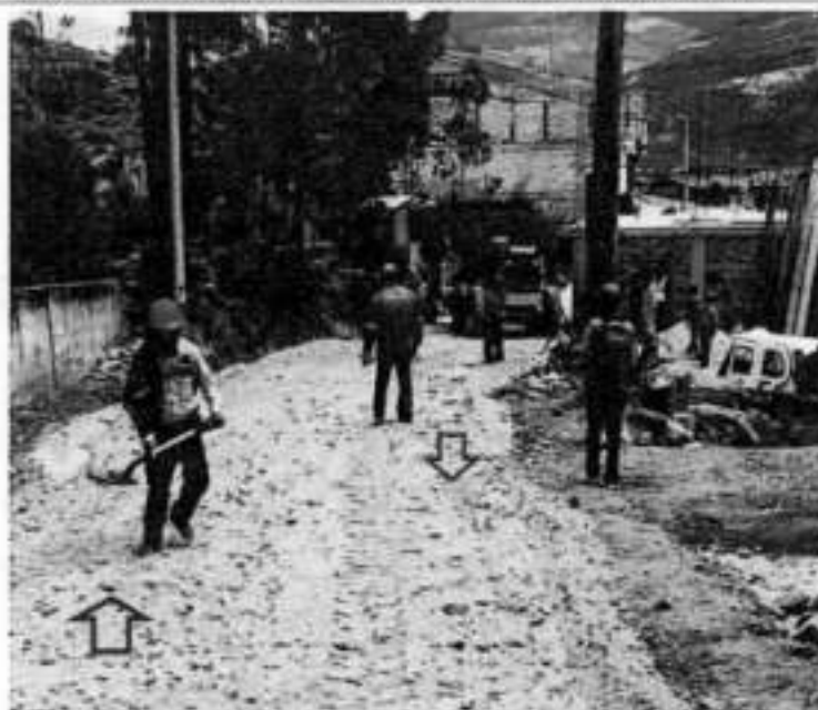
IMAGEN N° 51 Y 52 PANEL FOTOGRÁFICO CONTENIDO EN LA VALORIZACIÓN N° 1
