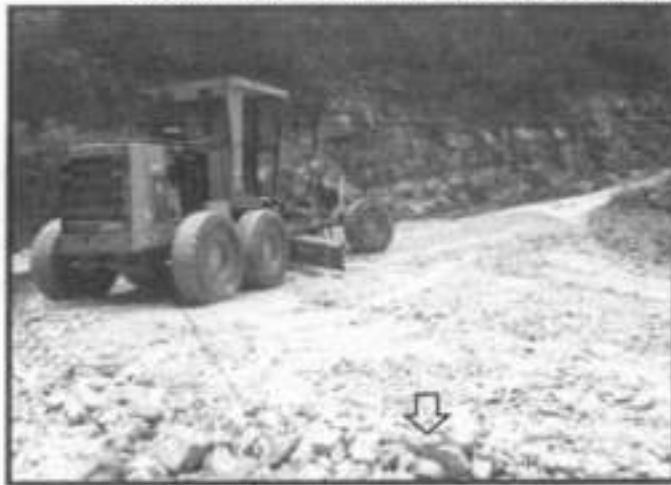
FOTO N° 23: Conformación de material de afirmado, progresiva 7+790 - 7+855 (peralte de curva).
