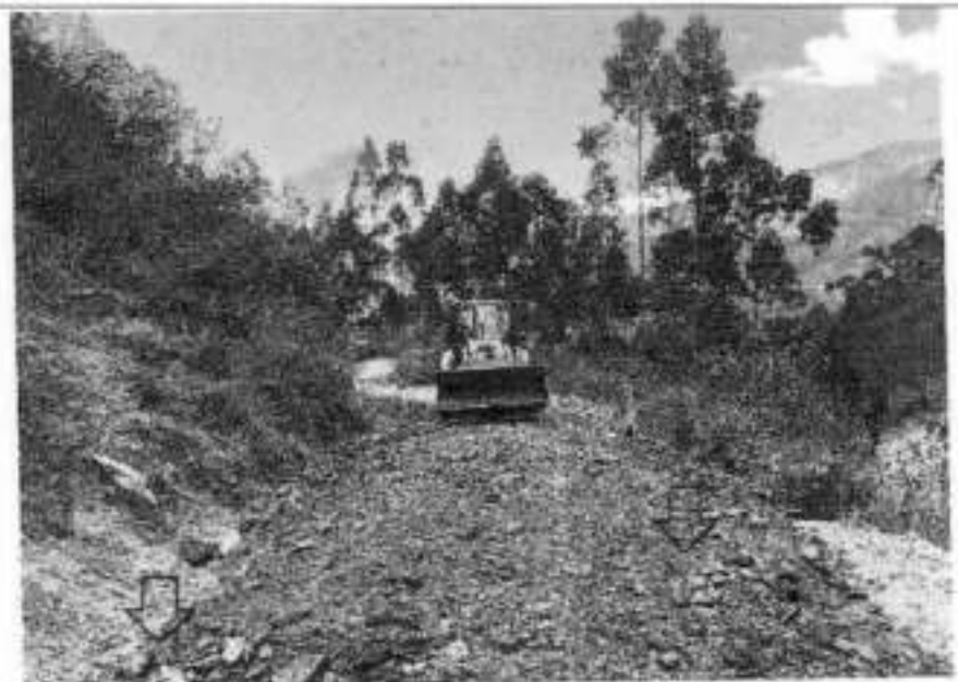
Foto Nro. 03: Extendido del Material Afirmado, Km 9+500.
