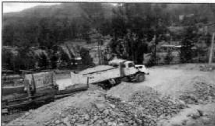
Foto 17: Se avanza inspección a los trabajos de descarga del tendido de MATERIAL GRANULAR de espesor 0.15 m en la progresiva progresiva km=0+550 hasta km= 0+900, de la CANTERA EL TAMBO.
