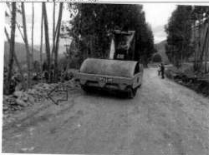
FOTO N° 07: Ing. INSPECTOR y RESIDENTE, verificando el compactado de plataforma con maquinaria km 11 + 750.
