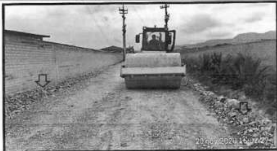
FOTO N° 33: Compactación de la capa de afirmado por el rodillo.
