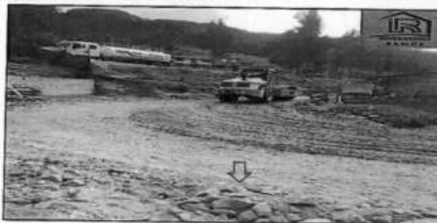
Foto 25: se visualiza los trabajos de compactado con rodillo de la capa de afirmado e=0.15m en la progresiva km=0+550 hasta km = 0+900
