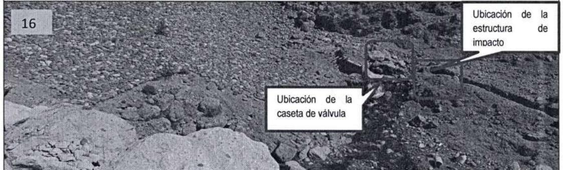
**Comentario:** Se observa que no se realizó la construcción de la caseta de válvula de acuerdo al Plano: Lámina "(DHOT-02) Caseta y Válvula de Control de Toma", solo encontrándose la cámara de válvula la cual se encuentra cubierta de tierra; asimismo, se encontró la estructura de impacto de concreto armado con una dimensión aproximada de 1.50 x 1.30 m y altura de 0.90 m
