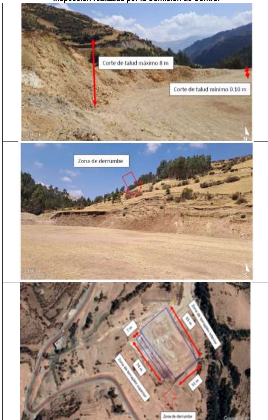
Imagen n.º 4 Inspección realizada por la Comisión de Control
