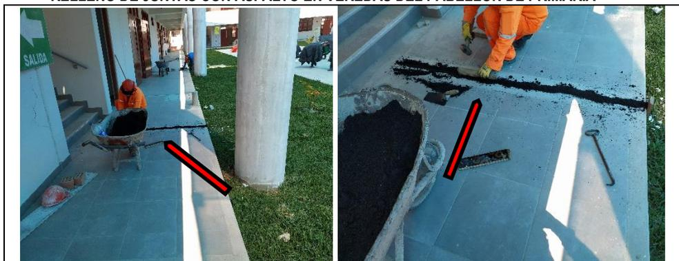
Se observan trabajos de relleno de juntas con asfalto en veredas interiores del pabellón de primaria.
