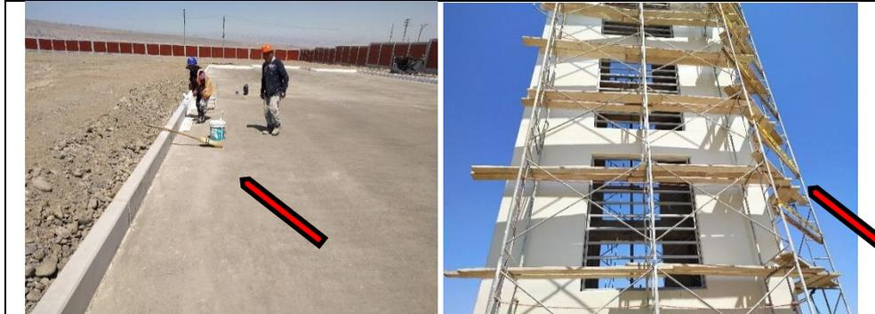
Se observan trabajos pendientes de culminar de pintura en muros interiores y exteriores de tanque elevado; además de pintura en sardineles de estacionamiento de secundaria.
