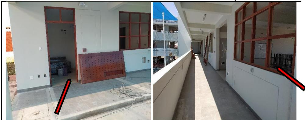
Se observan trabajos pendientes de culminar de instalación de vidrios laminados e=6mm. en ventanas de puertas y vidrio templado e=6mm. y e=4mm. en ventanas de madera en módulos A, B y C – Secundaria.
