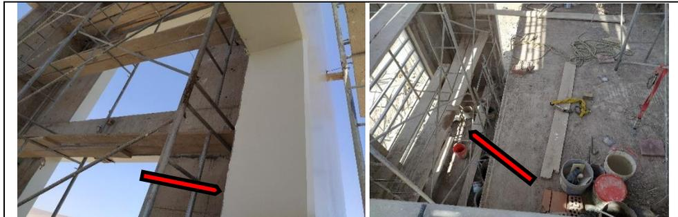
Se observan trabajos pendientes de culminar de pintura en muros interiores de tanque elevado.
