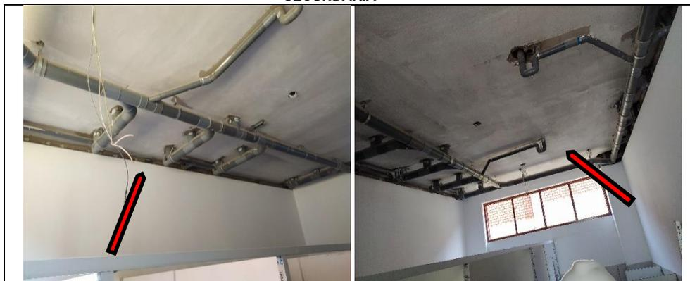
Se observan trabajos pendientes de culminar de falso cielo raso c/plancha fibrocemento 4mm. y de instalaciones eléctricas en módulos A, B y C – Secundaria.
