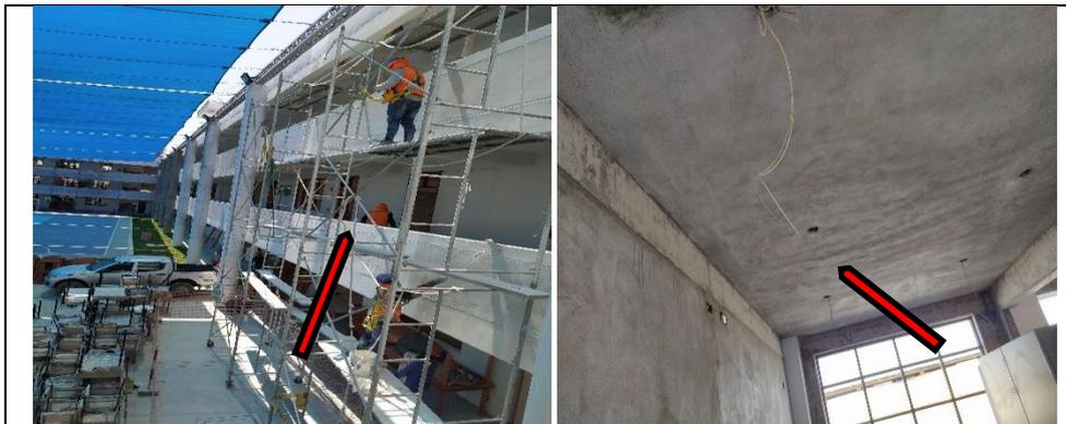
Se observan trabajos pendientes de culminar de pintura latex 02 manos en muros interiores, exteriores y en cielo raso; además de instalaciones eléctricas en módulo B – Secundaria.
