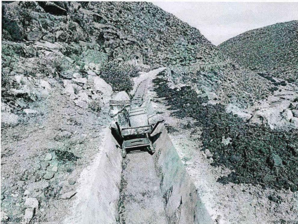
F5. Trabajos de limpieza y rehabilitación del canal trapezoidal de mampostería de piedra en una longitud de 1,257 m.
