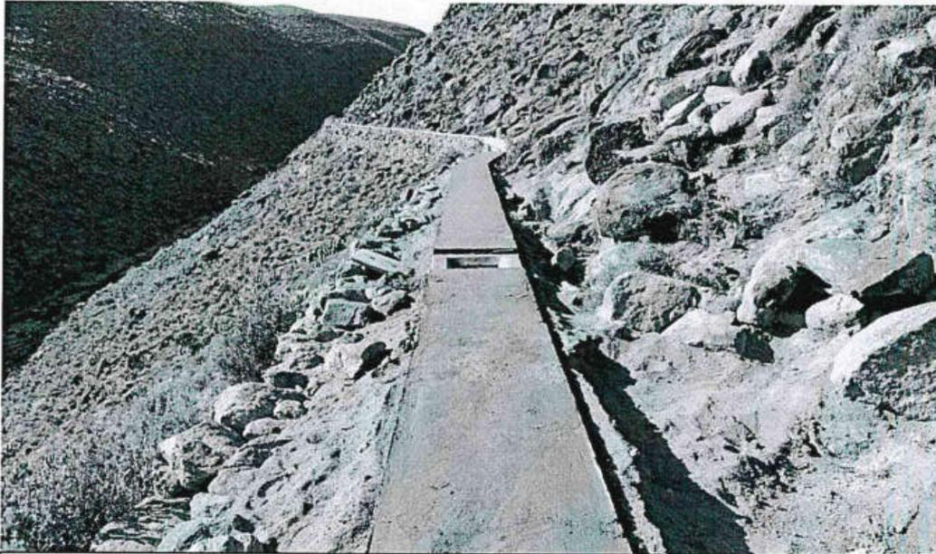
F14. Tramo de tubería que quedó sin protección (relleno compactado), en etapa de obra por oposición de usuarios. Ahora cuenta con una capa de protección de suelo cemento, que garantiza la durabilidad de los tubos instalados en el antiguo canal. Nótese también la caja de inspección construida.
