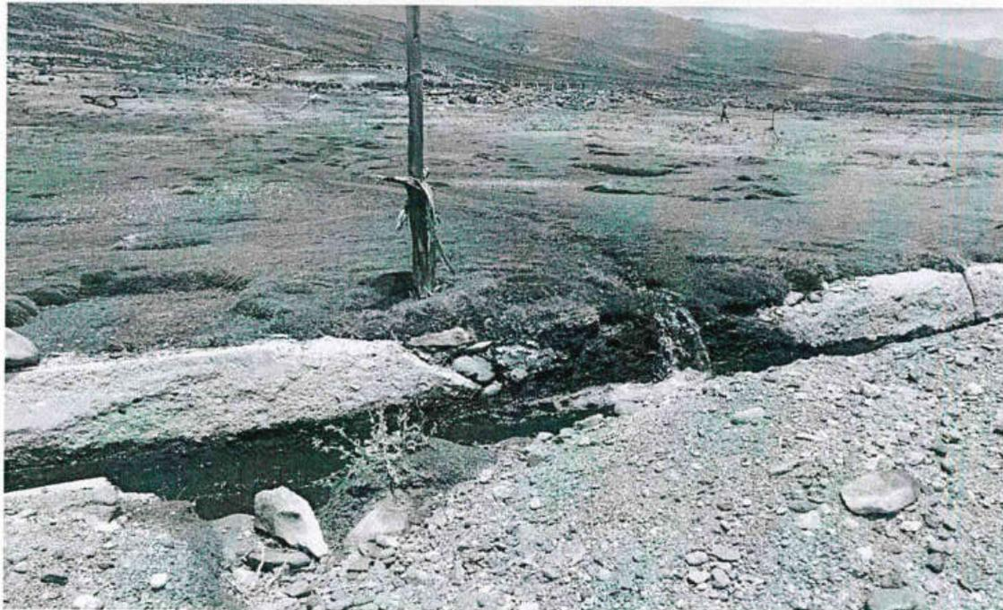
**Fotografía N° 4:** Zona con terrenos privados de tipo bofedal y afluente, adyacente al canal de conducción. Entre progresivas 0+300 al 0+500. Proponer lloraderos.
