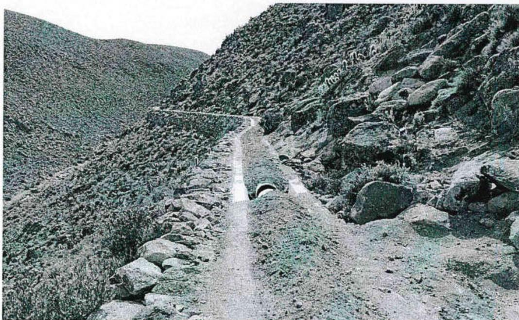
F11. Estado en el que se encontraba los trabajos de colocación de tuberías en el canal, en el momento de la paralización de actividades ocasionado por los usuarios.
