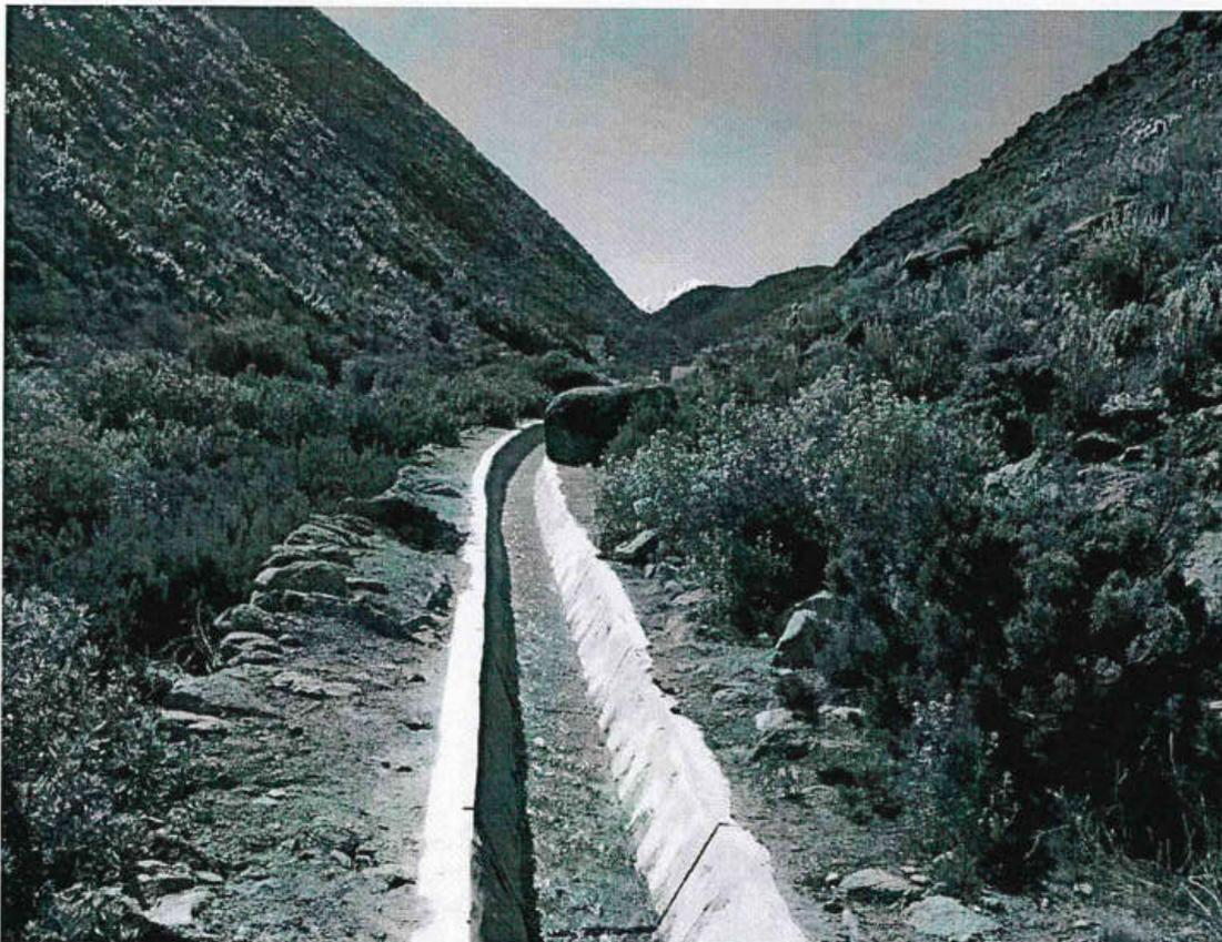
F20. Luego del acondicionamiento del canal de mampostería de piedra, se efectuó pruebas de permeabilidad y se trasladó el agua desde la captación, para efectuar las pruebas de carga estática y funcionamiento de las válvulas de descarga del Canal Sivincani II.
