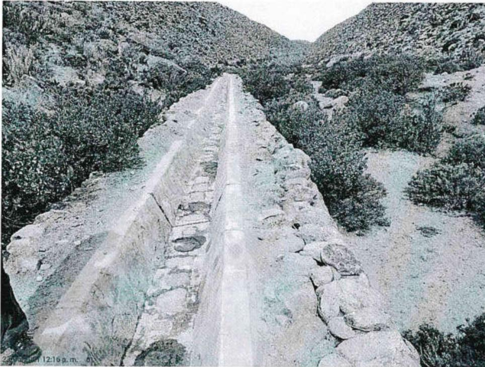
F4. Tramo de canal, luego del proceso de rehabilitación con mortero de cemento - cal y arena.
