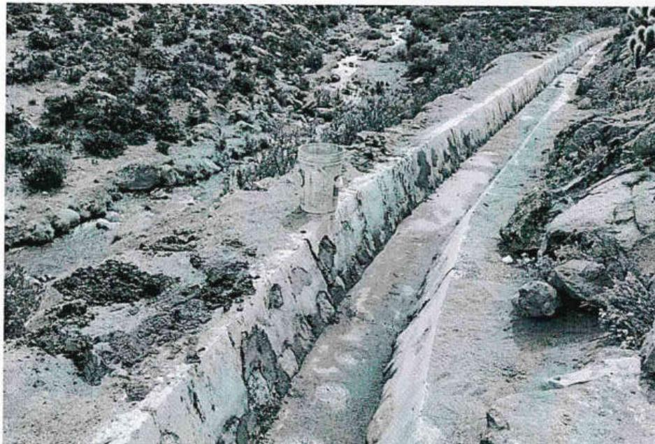
F10. Los trabajos de reacondicionamiento del canal se ejecutaron bajo una meticulosa revisión, para evitar posteriores fugas de agua que comprometan la seguridad y el buen funcionamiento del canal.
