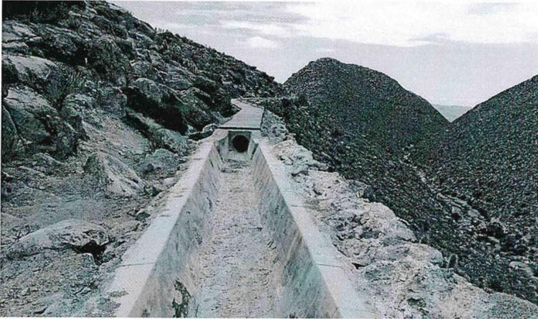
F8. Zona de empalme de canal trapezoidal con tubería perfilada Rip-Loc. (Km. 1+257).
