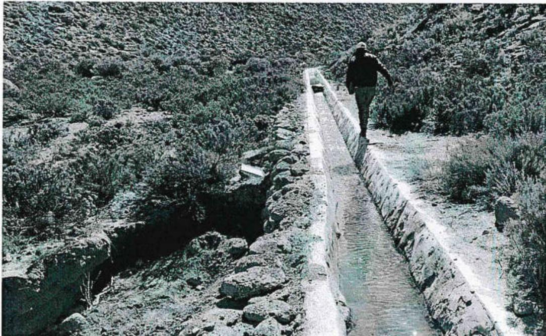
F7. Verificación de impermeabilidad del canal, luego de los trabajos de rehabilitación y tratamiento con lechada de cal hidráulica.
