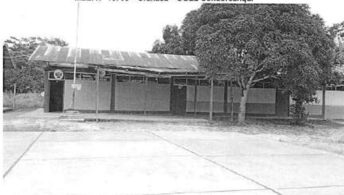
La losa deportiva de la II.EE. no cuenta con protección para radiación solar
