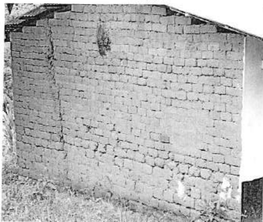
Pared lateral de la parte externa de las aulas.
