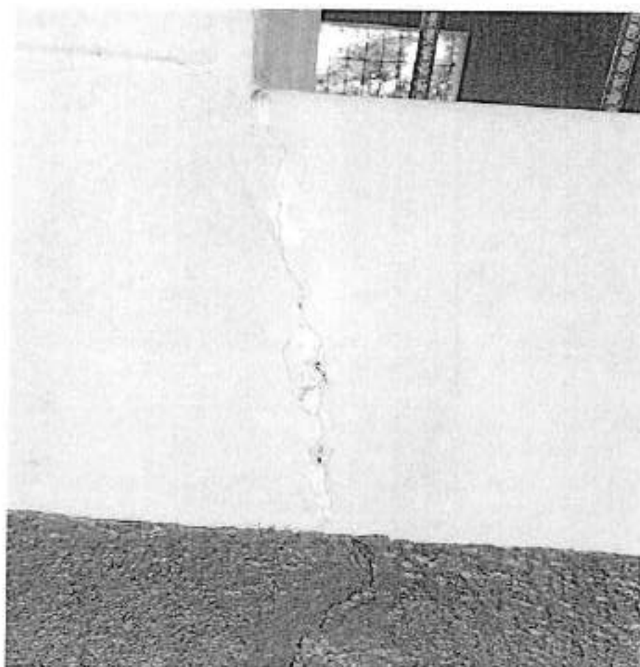
Fisura en la pared del aula.
