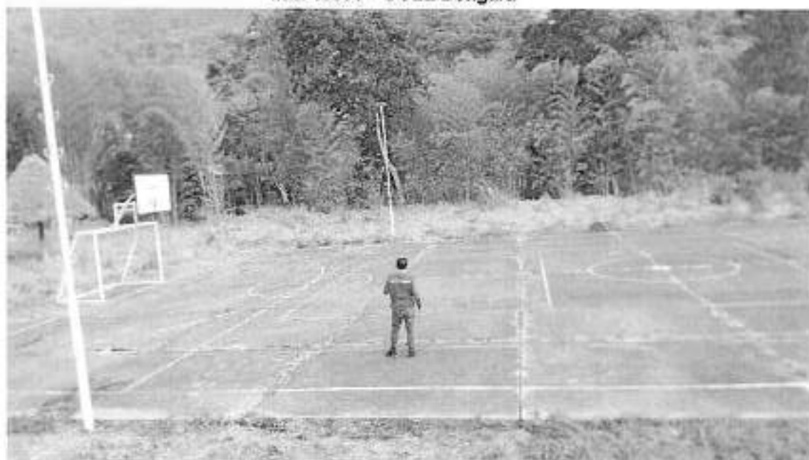
Losa deportiva sin protección solar
