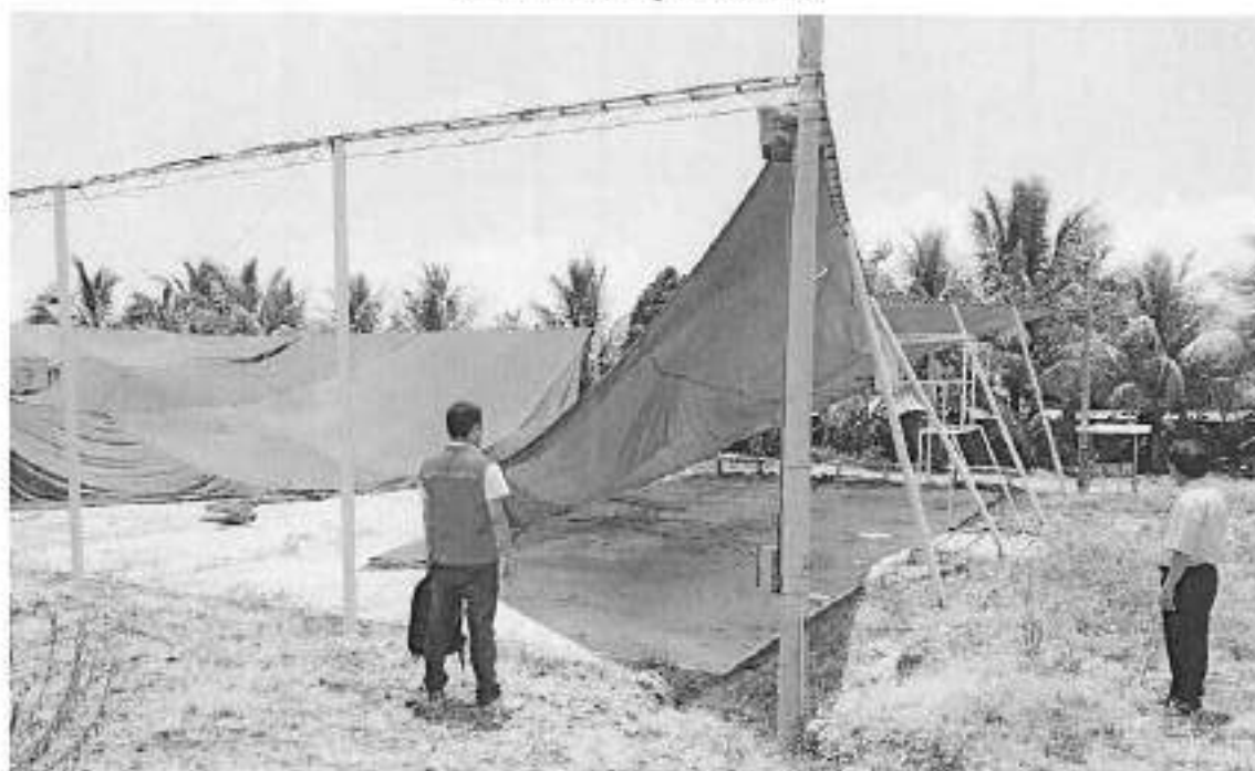
Losa deportiva en mal estado
