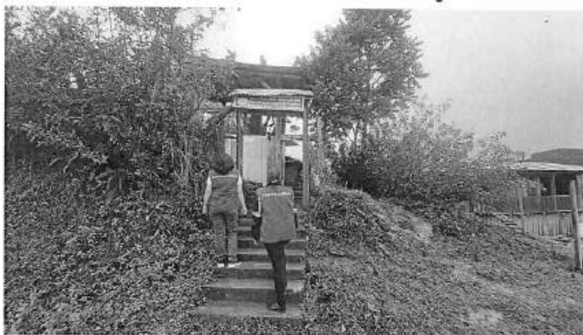
La II.EE. no cuenta con barandas en las escaleras ni rampa de acceso en la entrada principal
