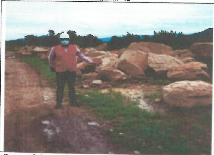
Rocas apiladas en obra para ser usadas en la conformación de los espigones.
