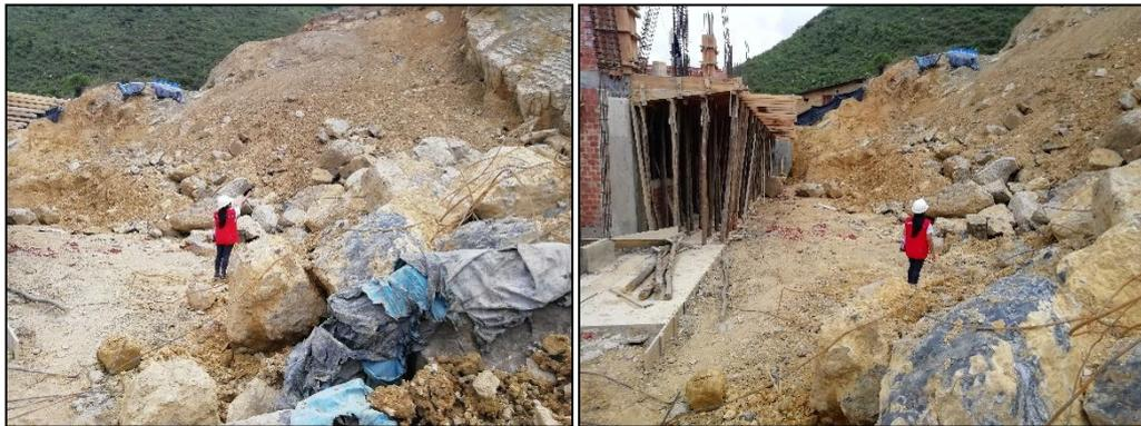
Se pudo constatar la existencia de roca y tierra en el área donde se tiene proyectado ejecutar el Módulo "A", el cual se ha deslizado del cerro. Esto puede generar el riesgo de ocasionar daños a la infraestructura de la Institución Educativa, si los deslizamientos no son controlados.
