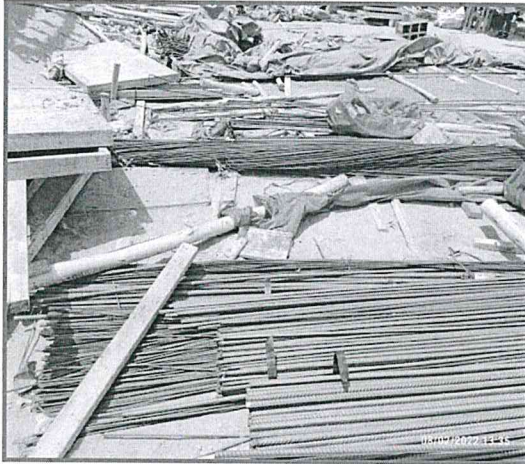
FOTOGRAFÍA N° 9 ACERO CORRUGADO EN CONTACTO DIRECTO CON EL SUELO Y OXIDADO
