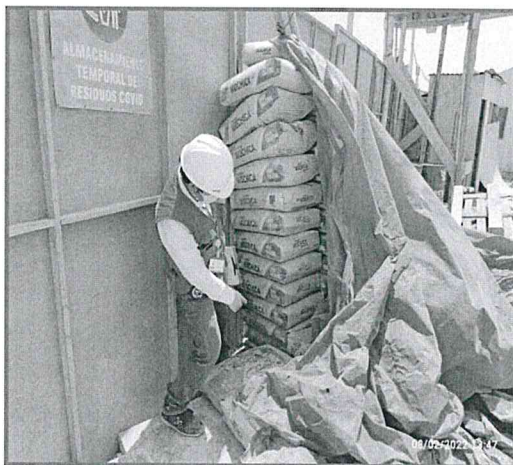
FOTOGRAFÍA N° 7 CEMENTO ALMACENADO EN PILAS DE 13 UNIDADES
