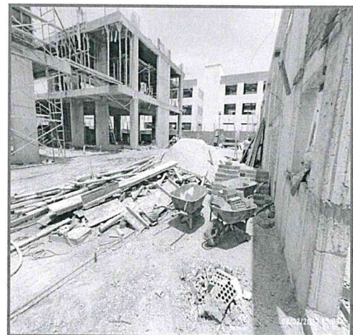
FOTOGRAFÍA N° 13 FALTA DE SEÑALIZACIÓN EN ZONA DE ACOPIO MATERIALES
