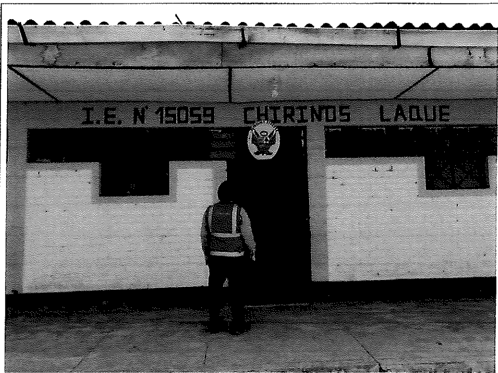
Imagen n.º 1: la Institución educativa N° 15059 se encontró cerrada con candado, cuenta con dos (02) aulas.
