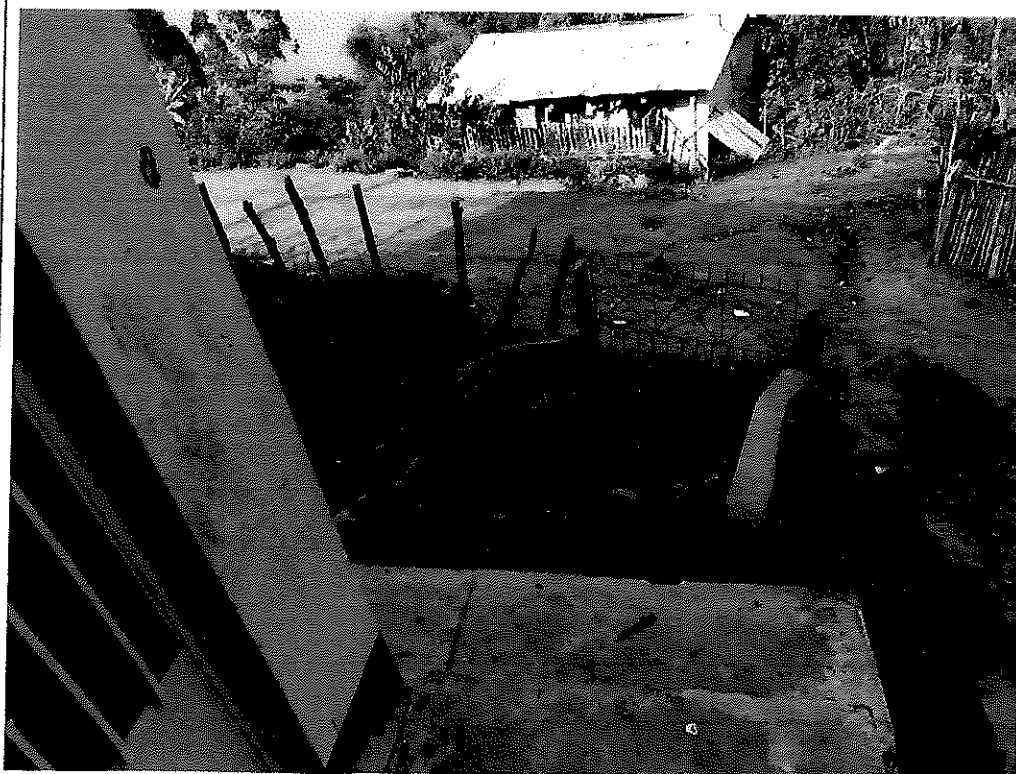
Imagen n.º 3 y 4: Se apreció que la I. Educativa no cuenta con rampas en los desniveles y las graderías no cuenta con barandas
