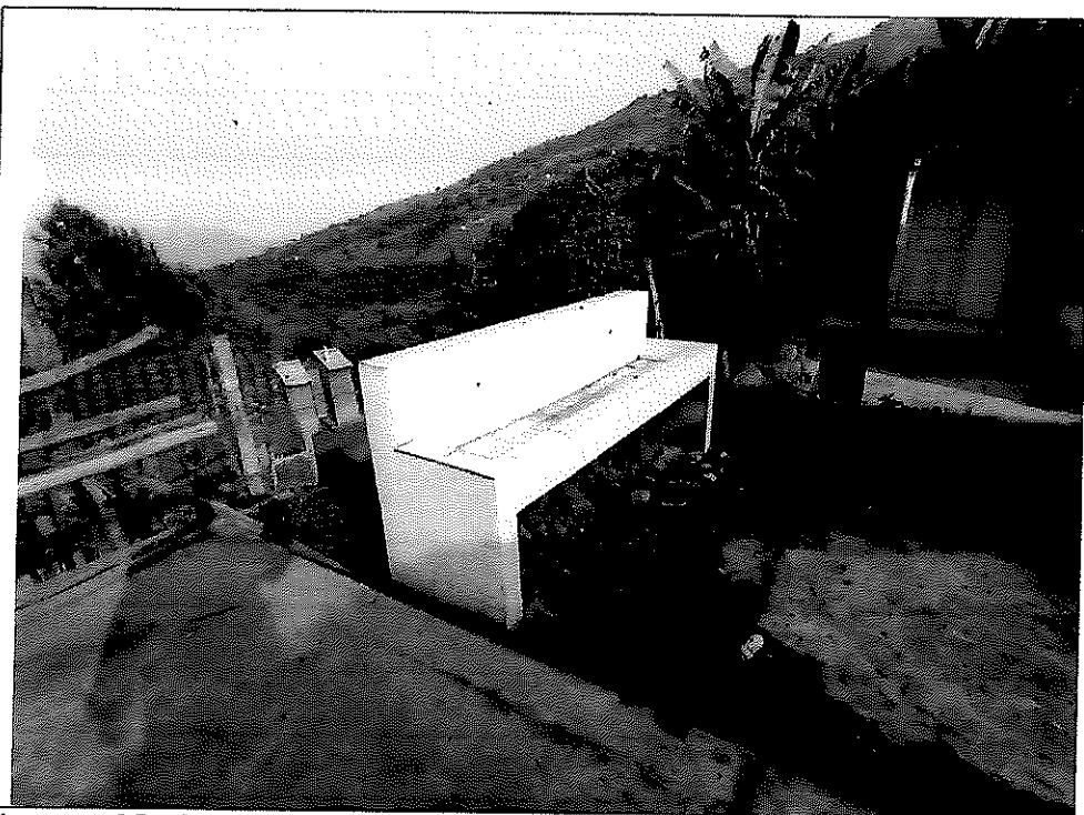
Imagen n.º 5: - Se aprecia el lavado de manos el cual no cuenta con la grifería del lavamanos ubicado al costado del patio de formación
