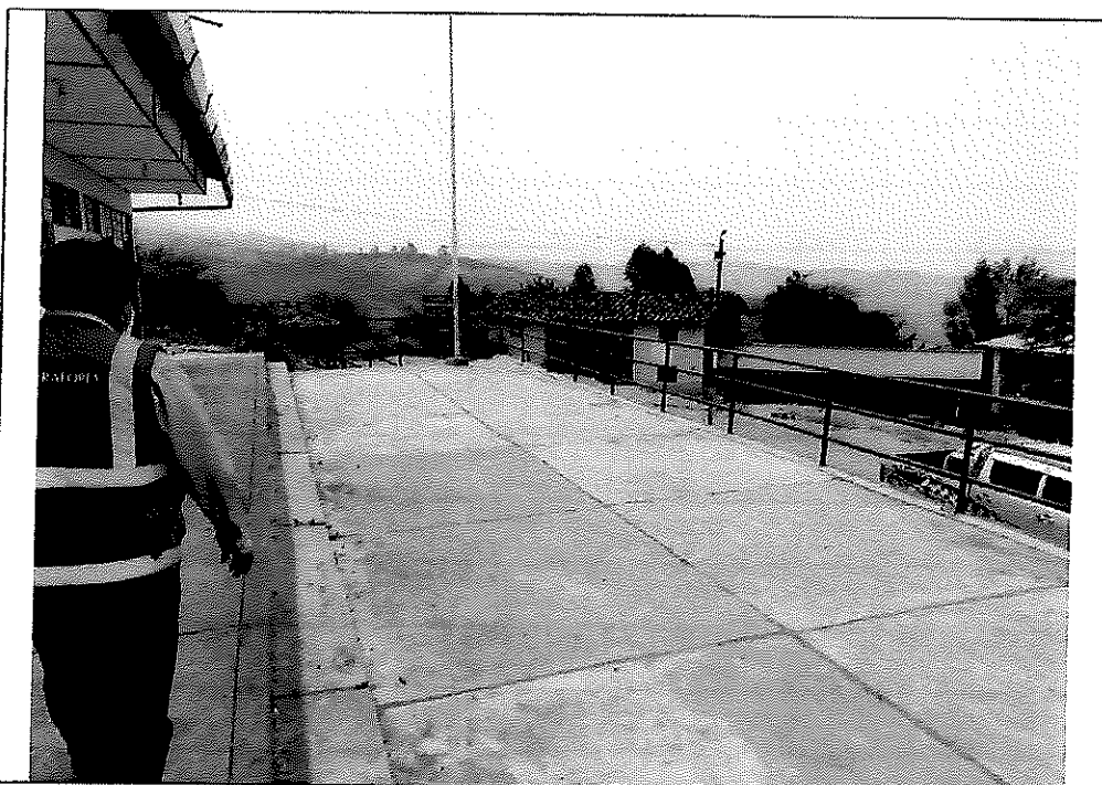
Imagen n.º 6: De la visita a la Institución educativa, se indica que no cuenta con cerco perimétrico, no se apreció los servicios higiénicos.
