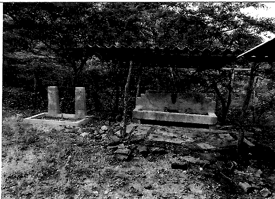
Imagen n.º 5: Lavadero de manos inseguro ubicado en la parte posterior de la Institución educativa.
