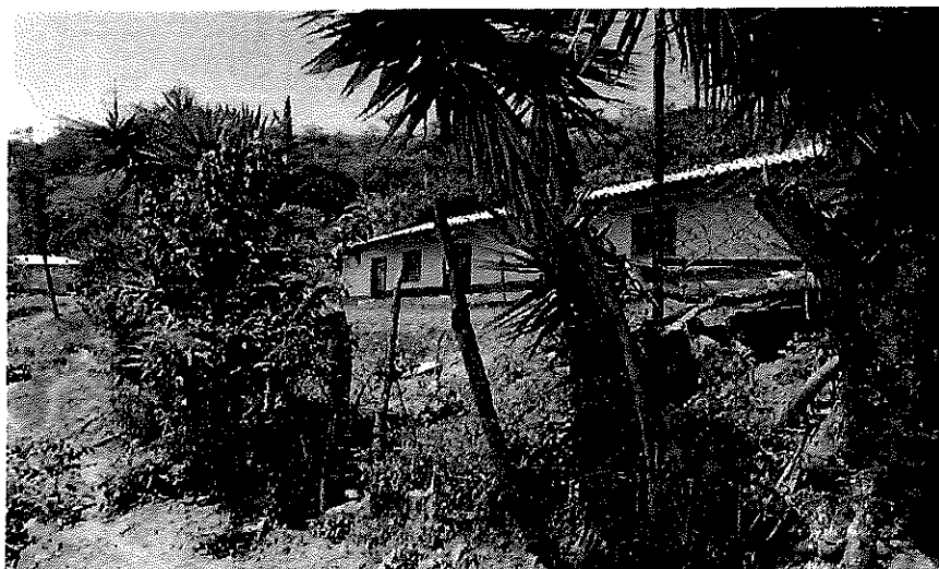
Imagen n.º 2: En al menos un sector del ambiente externo no se cuenta con baranda o elementos de seguridad en zonas con desnivel pronunciado, así como también, las instalaciones se encuentran protegidas en su mayor parte por cerco de alambre de púas
