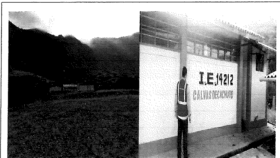
Imágenes n.ºs 1 y 2: la Institución educativa N° 14212 no se encuentra segura con cerco de perimétrico al que se puede acceder desde la carretera, atravesando el campo contiguo.
