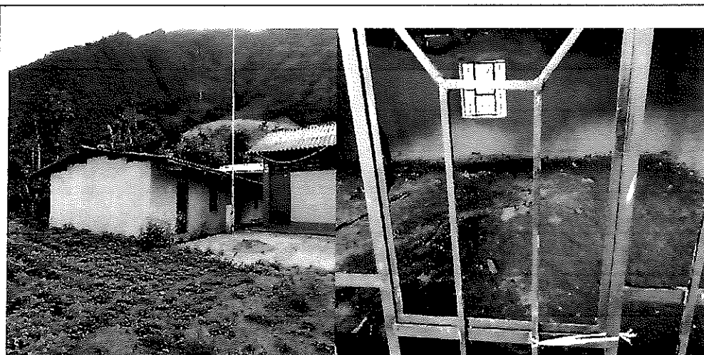
Imágenes n.ºs 3 y 4: Se apreció un pabellón con dos aulas en construcción.
