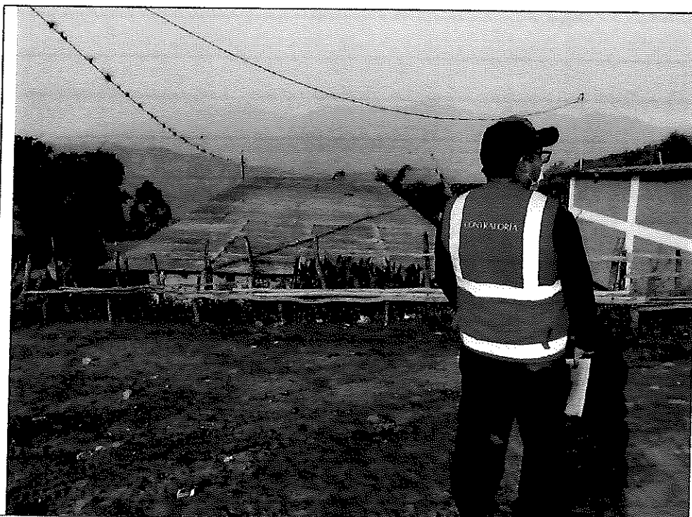
Imagen n.º 6: No cuenta la Institución educativa con cerco perimétrico adecuado, el cual consta de puntales de madera y alambre de púas con altura menor a los reglamentado.
