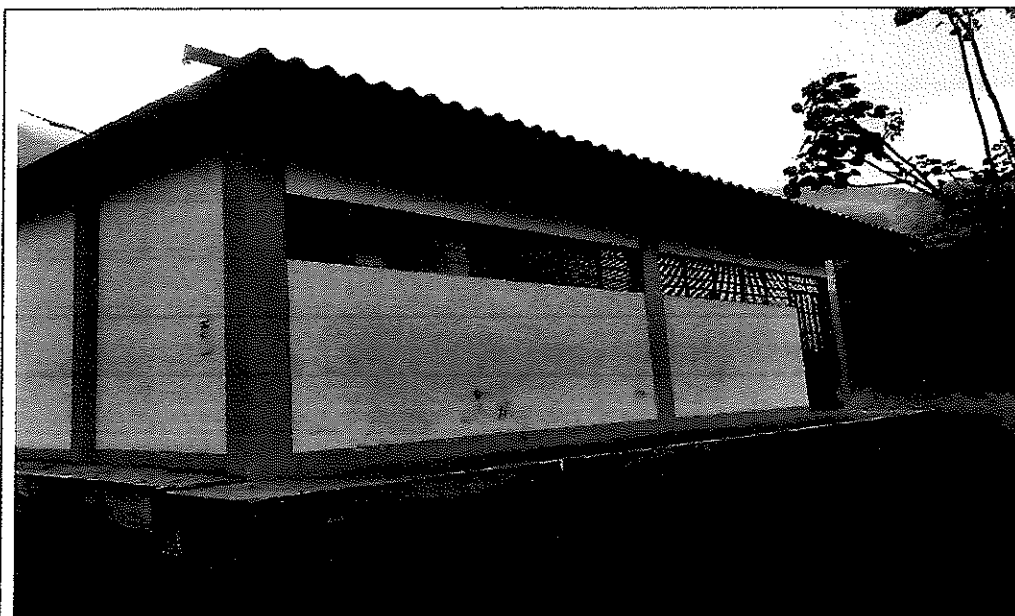
Imagen n.º 7: No existe rampa de acceso para discapacitados.
