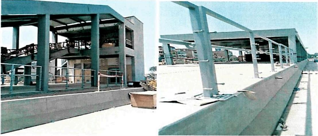
Registros fotográficos n.ºs 37 y 38: Falta cerramiento con vidrio templado, así como la colocación de vidrios en las barandas metálicas en los corredores de la Estación.
