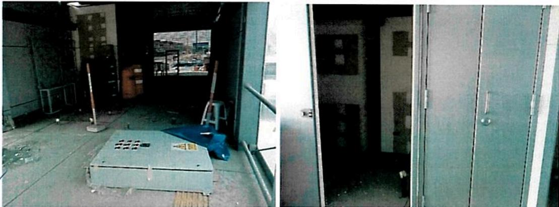
Registros fotográficos n.ºs 32 y 33: Tablero de Control General de Energía Eléctrica (izquierda) colocado en el piso y gabinete de comunicaciones sin su respectivo equipamiento como UPS, transformador de aislamiento, tablero de distribución, entre otros (derecha).
