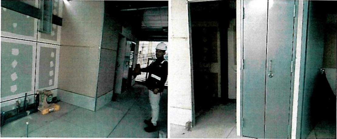
Registros fotográficos n.ºs 32 y 33: Inexistencia de Tablero de Control General de Energía Eléctrica (izquierda) y gabinete de comunicaciones sin su respectivo equipamiento como UPS, transformador de aislamiento, tablero de distribución, entre otros (derecha).
