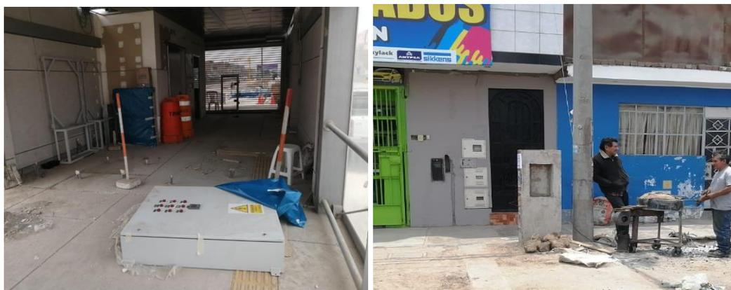
**Registros fotográficos n.ºs 9 y 10:** Inexistencia de Tablero General de control eléctrico de la Estación Los Incas (izquierda) y murete construido sin su respectivo circuito de alimentación hacia el tablero (derecha).
