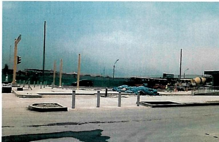
Registro fotográfico n.º 33: Postes Pedestal instalados, sin sus respectivos equipos de semaforización.
