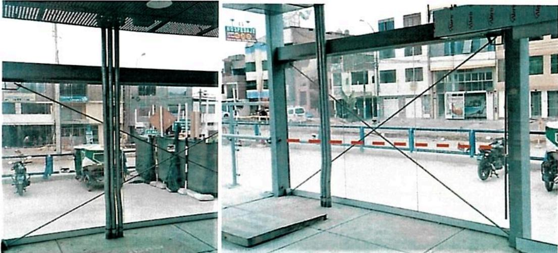
Registros fotográficos n.ºs 24 y 25: Tubería de fierro galvanizado para sistema de comunicaciones que impide la colocación de la baranda de protección de mampara de vidrio.
