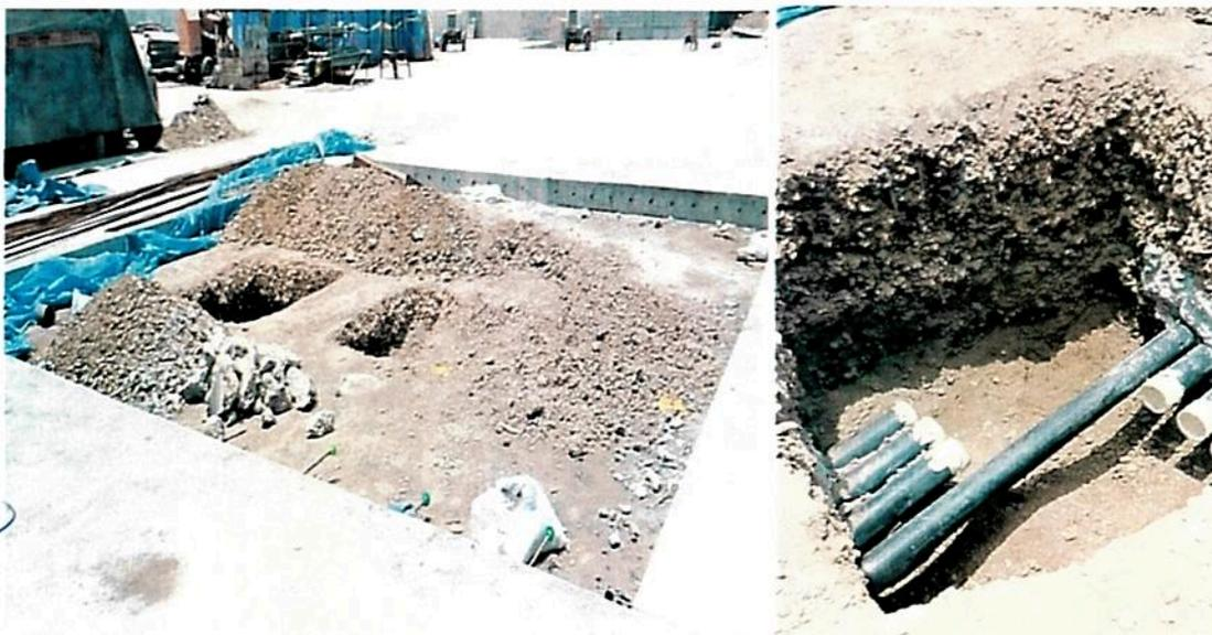
Registros fotográficos n.ºs 41 y 42: Áreas excavadas para la construcción de buzones de concreto para pasar cables de energía eléctrica.
