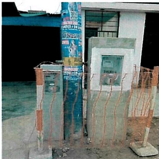
Registro fotográfico n.º 25: Ubicación de muretes construidos para albergar los respectivos medidores de energía eléctrica para la Estación Los Platinos (murete alto) y para la semaforización (murete bajo); ambos sin el respectivo suministro de energía eléctrica por parte de ENEL.
