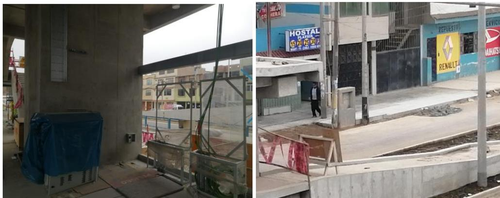
**Registros fotográficos n.ºs 3 y 4:** Tablero General de control eléctrico de la Estación Universidad sin instalar (izquierda) y murete construido sin su respectivo circuito de alimentación hacia el tablero (derecha).
