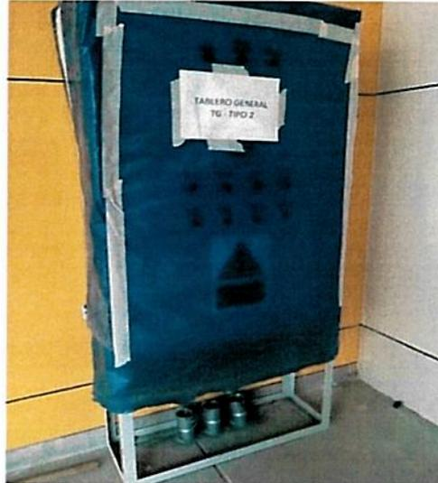
Registro fotográfico n.º 21: Tablero de Control General de energía eléctrica sin conexión.
