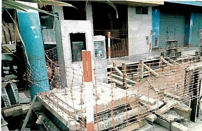
Registro fotográfico n.º 23: Ubicación de muretes construidos para albergar los respectivos medidores de energía eléctrica para la Estación Santa Ligua (murete alto) y para la semaforización (murete bajo); ambos sin el respectivo suministro de energía eléctrica por parte de ENEL.
