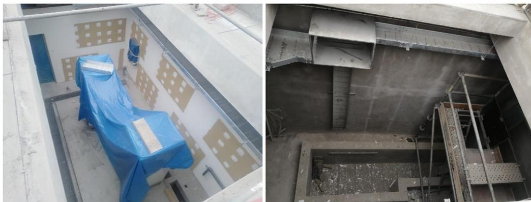
**Registros fotográficos n.ºs 12 y 13:** Ambientes de la Sub Estación Eléctrica destinado a albergar el Grupo Electrónico (izquierda) y Celda de Transformador (derecha) sin su respectivo equipamiento electromecánico.
