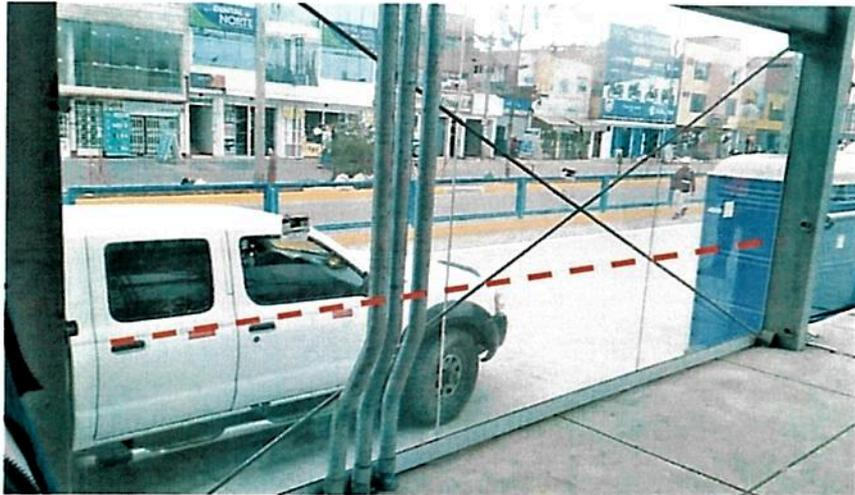
**Registro fotográfico n.º 31:** Tubería de fierro galvanizado para sistema de comunicaciones que impide la colocación de la baranda de protección de mampara de vidrio.
