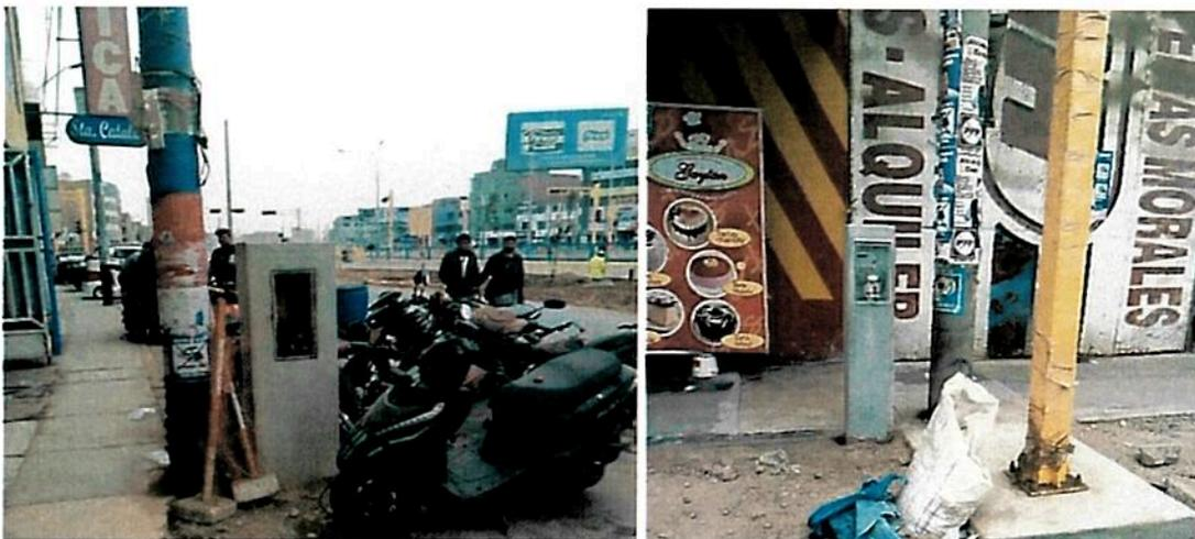
Registros fotográficos n.ºs 23 y 24: Ubicación de muretes construidos para albergar los respectivos medidores de energía eléctrica para la Estación 22 de Agosto (izquierda) y para la semaforización (derecha); ambos sin el respectivo suministro de energía eléctrica por parte de ENEL.
