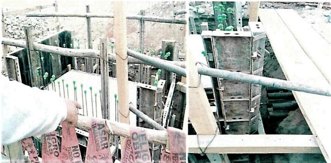
Registros fotográficos n.ºs 6 y 7: Encofrado de caja de paso de fibra óptica.
