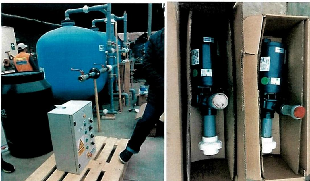
Registros fotográficos n.ºs 52 y 53: Sistema de Tratamiento Terciario conformado por un tablero de control, dos filtros multimedia, dos electrobombas centrífugas y un tanque de almacenamiento.
