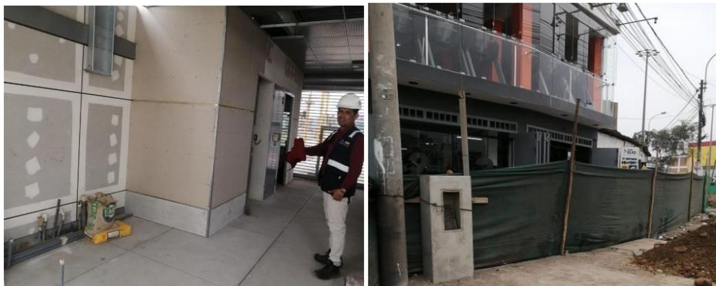
**Registros fotográficos n.ºs 7 y 8:** Inexistencia de Tablero General de control eléctrico de la Estación Andrés Belaunde (izquierda) y murete construido sin su respectivo circuito de alimentación hacia el tablero (derecha).
