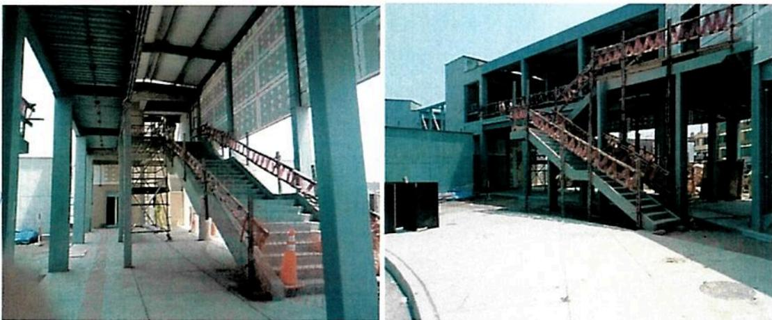
Registros fotográficos n.ºs 35 y 36: Barandas aún no instaladas en las escaleras de acceso al segundo nivel, así como en la escalera de salida de emergencia.
