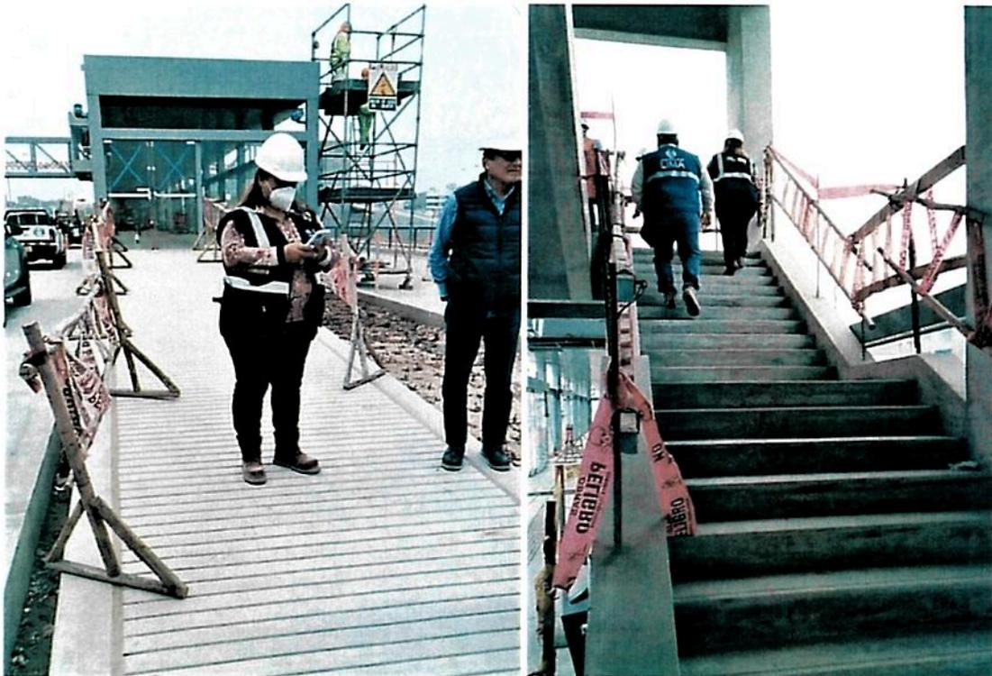
Registros fotográficos n.ºs 27 y 28: Barandas aún no instaladas en la rampa de emergencia y en el acceso al segundo nivel de la estación Universidad.
