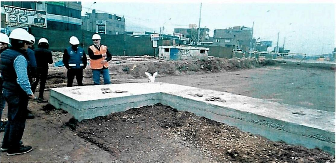
Registro fotográfico n.º 2: Cámara de concreto construida para válvula de agua existente, interferencia liberada que permitió la ejecución de trabajos de estructura de pavimento en la intersección de las avenidas Túpac Amaru con Naranjal.
