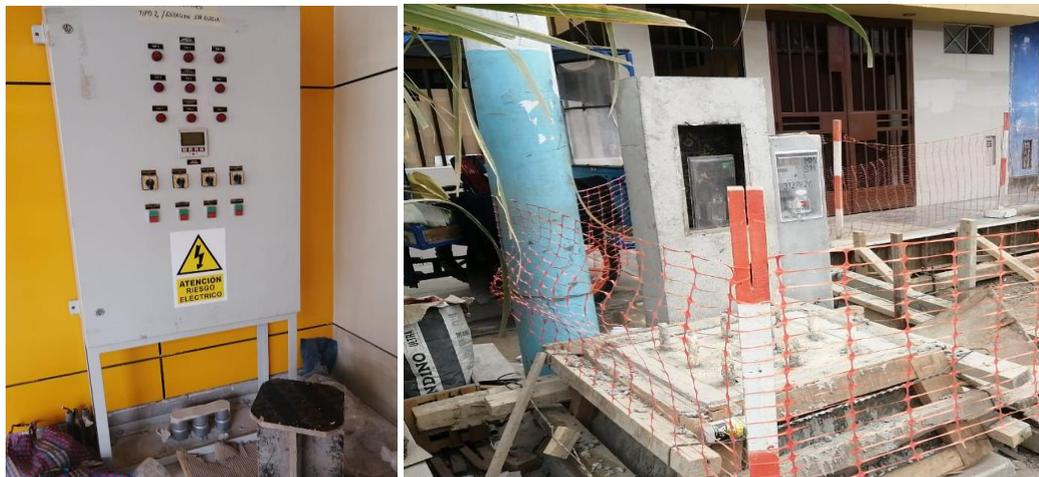
**Registros fotográficos n.ºs 1 y 2:** Tablero General de control eléctrico de la Estación Santa Ligua sin instalar (izquierda) y murete alto construido sin su respectivo circuito de alimentación hacia el tablero (derecha).
