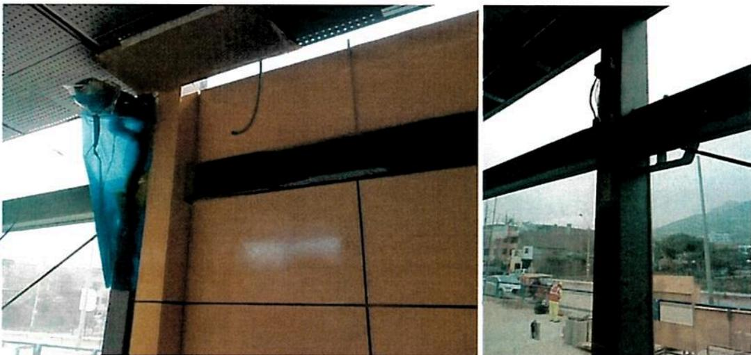
Registros fotográficos n.ºs 21 y 22: Cámaras de videovigilancia sin conexión (izquierdo) y cables eléctricos expuestos (derecha).
