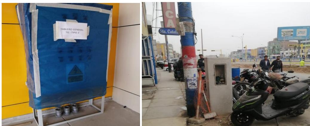
**Registros fotográficos n.ºs 5 y 6:** Tablero General de control eléctrico de la Estación 22 de Agosto sin instalar (izquierda) y murete construido sin su respectivo circuito de alimentación hacia el tablero (derecha).
