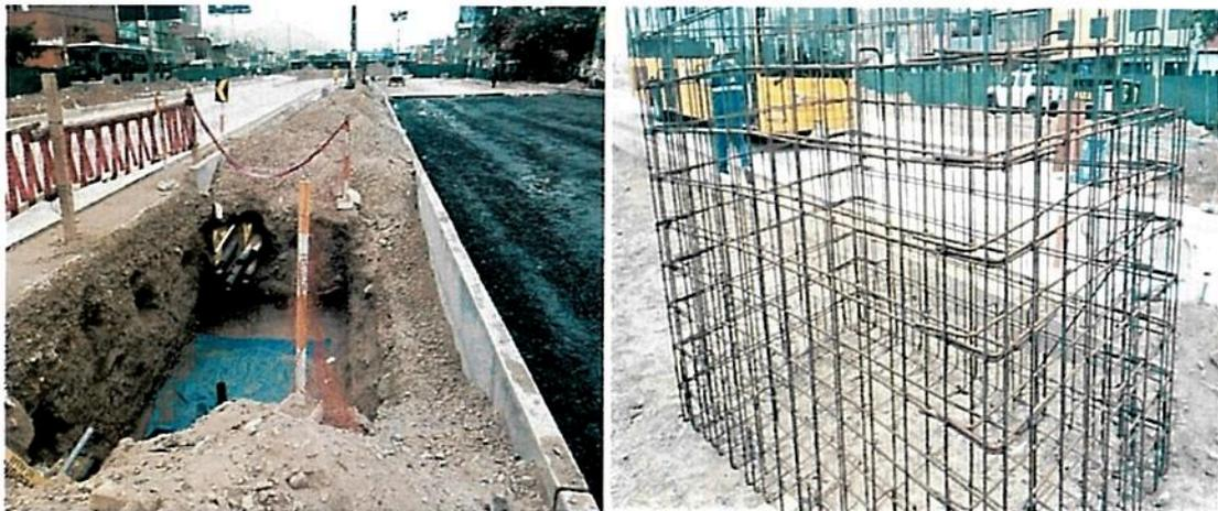
Registros fotográficos n.ºs 4 y 5: Área excavada para la construcción de caja de paso para fibra óptica, tramo 1.1, próximo a la Estación Naranjal.
