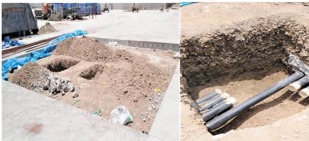
**Registros fotográficos n.ºs 14 y 15:** Áreas excavadas para la construcción de buzones de concreto para pasar cables de energía eléctrica.
