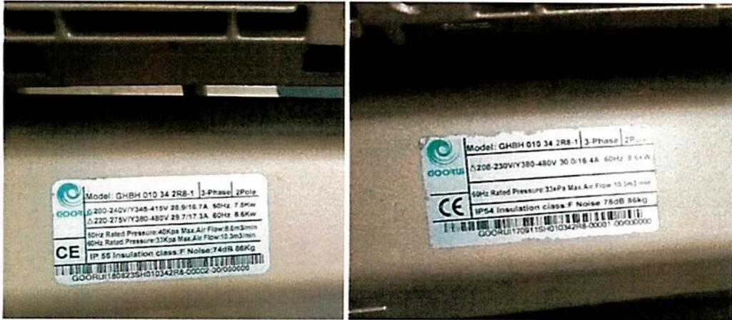
Registros fotográficos n.ºs 47, 48 y 49: Cuatro Blowers (Sopladores de Aire) que formaran parte de la cámara de aeración y de decantación; mostrándose las respectivas placas de identificación.
