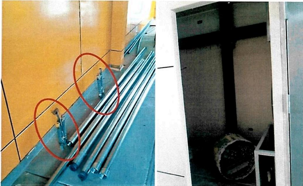
**Registro fotográfico n.º 32:** Tuberías de plástico en piso para posterior conexión con las máquinas de recargas de tarjetas del Metropolitano (izquierda) y gabinete de comunicaciones sin su respectivo equipamiento como UPS, transformador de aislamiento, tablero de distribución, entre otros (derecha).
