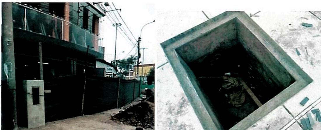
Registros fotográficos n.ºs 29 y 30: Murete construido para albergar el respectivo medidor de energía eléctrica para la estación Andrés Belaunde (izquierda); e imagen de una caja de pase para la fibra óptica a instalarse para el sistema de semaforización (derecha).
