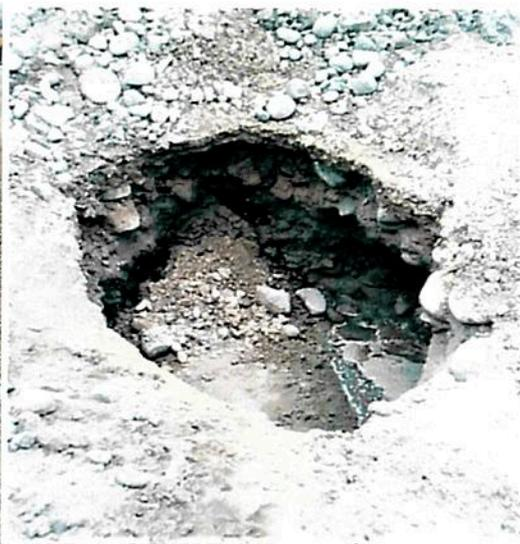
Registros fotográficos n.ºs 13, 14 y 15: Trabajos de movimiento de tierras paralizado en la intersección de las avenidas Universitaria con Andrés Belaunde (lado izquierdo), debido a la existencia de una tubería de desagüe de asbesto cemento en mal estado (interferencia detectada).
