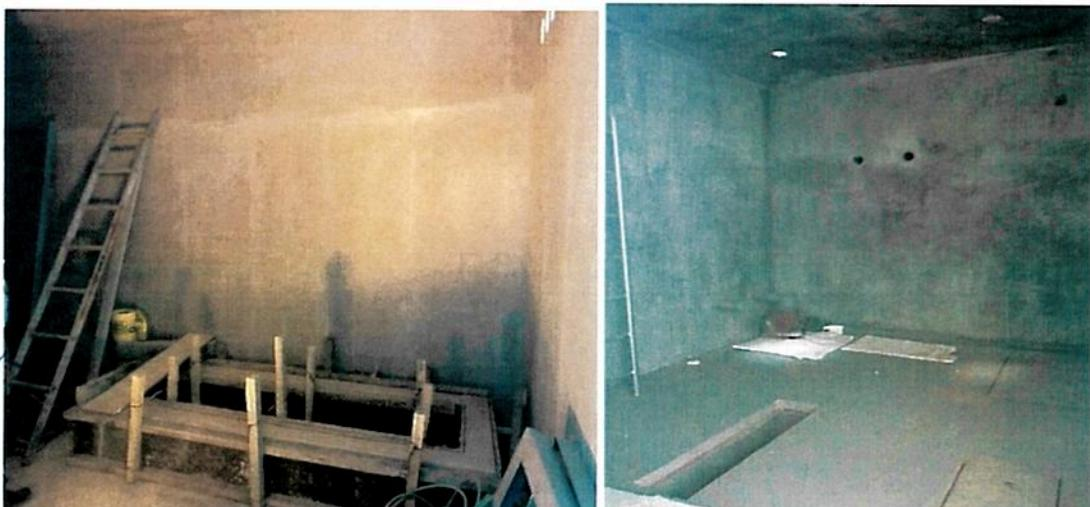
Registros fotográficos n.ºs 37 y 38: Ambiente proyectado para tableros generales de control eléctrico (izquierdo) y Cuarto de Bombas de la Cisterna para Agua de consumo doméstico (derecha) sin equipos de iluminación, ni el respectivo equipamiento electromecánico.
