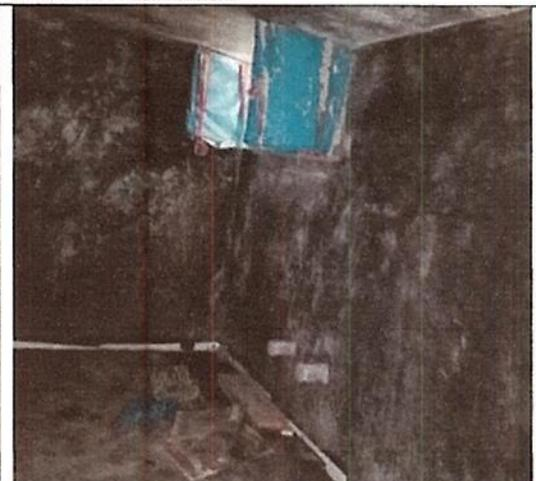
**Registro Fotografico n.º 63:** Cuarto de bombas sin equipos de bombeo, ni sus respectivas instalaciones hidráulicas (manifold), tableros de control, sistema eléctrico, ni sistema de iluminación.
