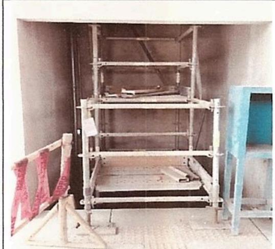
Registro Fotografico n.º 18: Ducto de concreto para posterior instalación de un ascensor.
