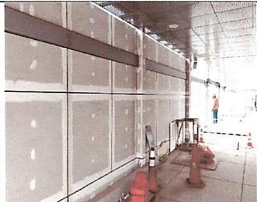
Registro Fotográfico n.º 6: Falta acabado final en los muros de drywall construidos.
