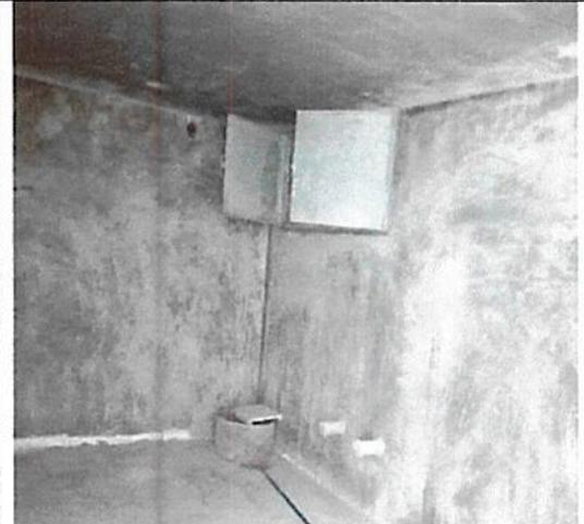
**Registro Fotografico n.º 61:** Cuarto de bombas sin equipos de bombeo, ni sus respectivas instalaciones hidráulicas (manifold), tableros de control, sistema eléctrico, ni sistema de iluminación.
