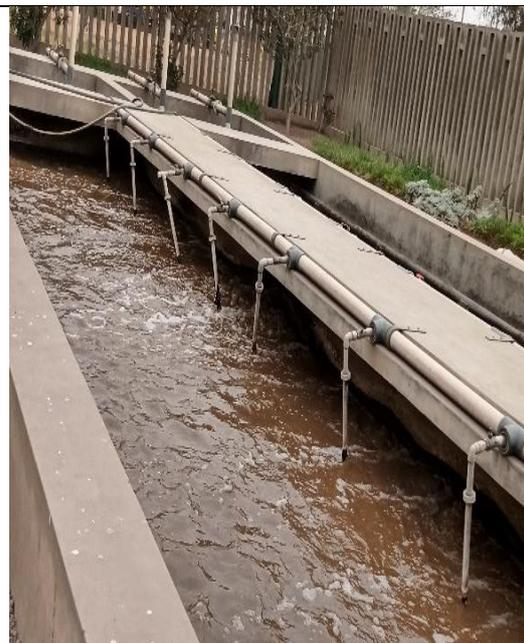
**Registro Fotográfico n.º 8:** Proceso de tratamiento de las aguas residuales mediante aireación.
