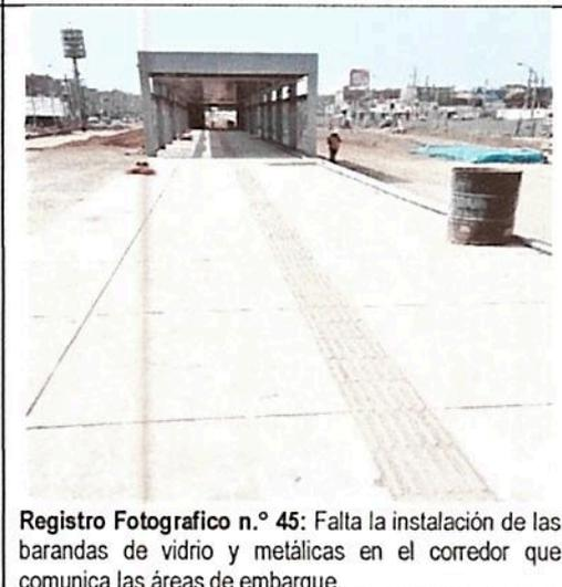
Registro Fotográfico n.º 45: Falta la instalación de las barandas de vidrio y metálicas en el corredor que comunica las áreas de embarque..
