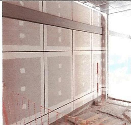
Registro Fotográfico n.º 12: Falta acabado final en los muros de drywall construidos.
