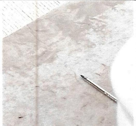
Registro Fotografico n.º 19: Fisuras en losa de concreto.
