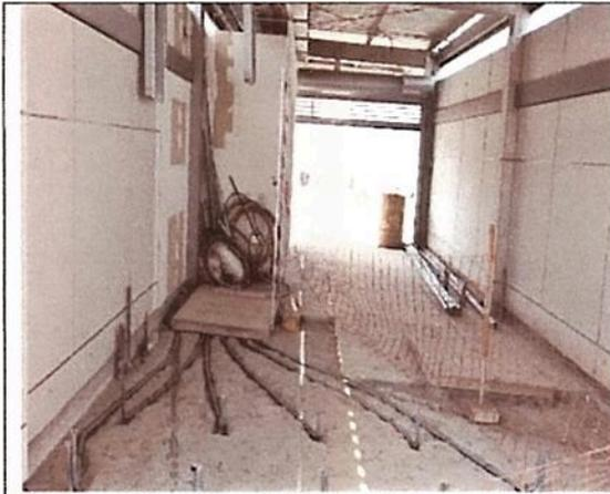
**Registro Fotografico n.º 46:** Acondicionamiento de Cuarto de Comunicaciones no iniciado, reinstalación de tuberías para fibra óptica y eléctricas para el funcionamiento de los torniquetes.
