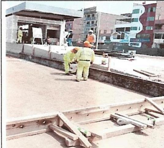
Registro Fotográfico n.º 30: Falta la instalación de barandas metálicas en el ingreso a la estación, así como vaceado de concreto en algunos paños del pavimento.
