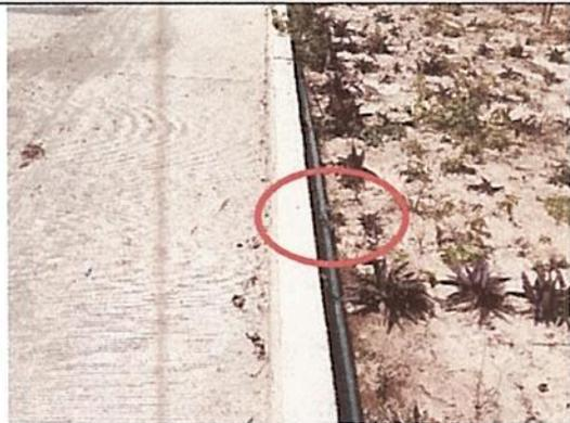
**Registro Fotografico n.º 65:** Se visualiza en la zona de riego aledaño a la Estación Los Incas, que no se ha realizado el taponeo provisional en la salida de distribución del agua de riego.
