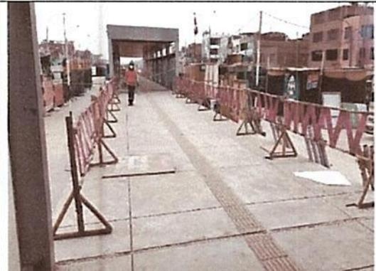
Registro Fotográfico n.º 8: Falta la instalación de las barandas de vidrio y metálicas en el corredor que comunica las áreas de embarque.
