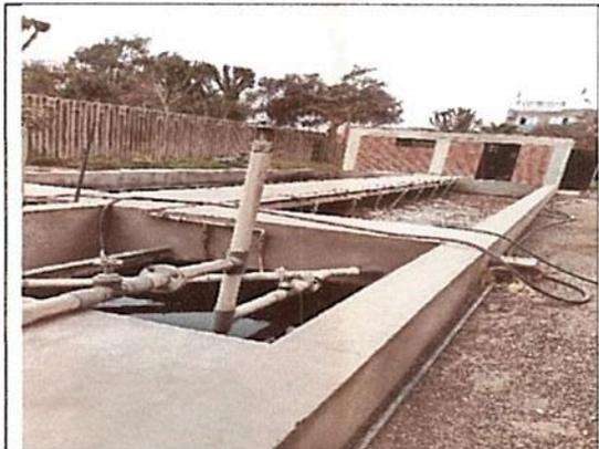
**Registro Fotográfico n.º 56:** PTAR existente en funcionamiento, identificándose unidades de tratamiento por aireación y sedimentador.
