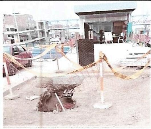
Registro Fotográfico n.º 11: Tuberías de plástico expuestas para posterior instalación de la fibra óptica e instalaciones eléctricas.
