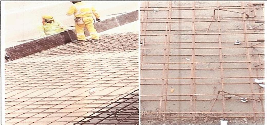
Registro Fotográfico n.º 40 y 41: Colocación de acero de refuerzo para losa de concreto ubicada al costado de la estación Andrés Belaunde, presentando óxido superficial.
