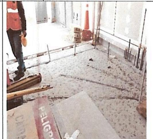
Registro Fotográfico n.º 33: Remoción de tuberías de fibra óptica, comunicaciones e instalaciones eléctricas en el área destinada a los torniquetes.
