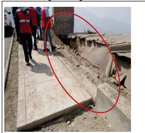
Se muestra paño de muro de contención con altura a nivel de vereda terminada.
