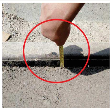
Se muestra el margen de 3.5 cm dejado para completar la segunda capa de pavimento asfáltico.
