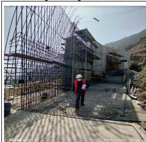
Muro de contención en proceso de ejecución ubicado en la progresiva Km 3+300
