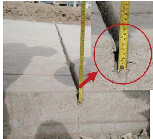
Se muestra la junta de dilatación en veredas inferior a 10cm.
