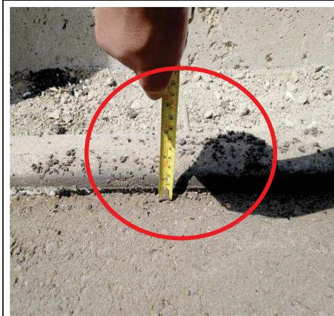
Se muestra el margen de 2 cm dejado para completar la segunda capa de pavimento asfáltico.
