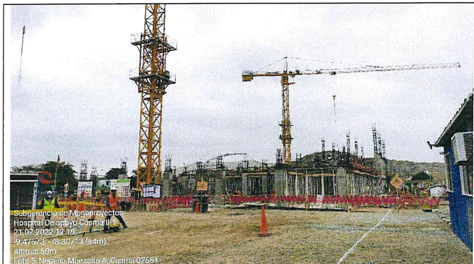
Vista general de obra Hospital de Apoyo Casma II-1
