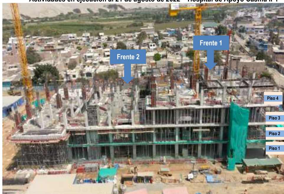
Fotografía N° 9 Actividades en ejecución al 21 de agosto de 2022 – Hospital de Apoyo Casma II-1
