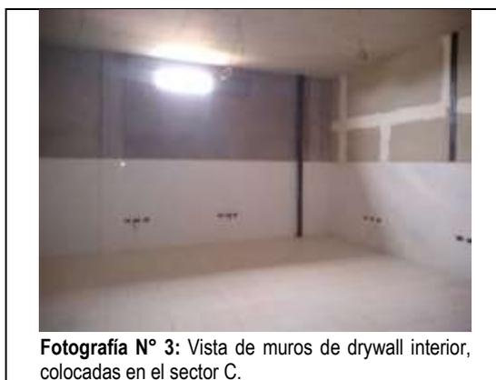
**Fotografía N° 3:** Vista de muros de drywall interior, colocadas en el sector C.
