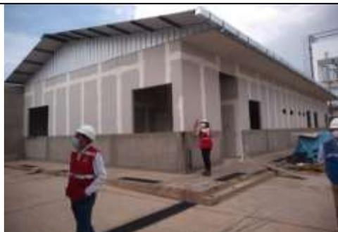
**Fotografía N° 1:** Vista de muros de drywall exterior sobre zócalo de ladrillo, colocadas en el sector A.
