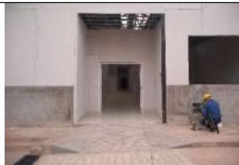
**Fotografía N° 2:** Vista de fachada principal del sector B, muros de drywall sobre zócalo de ladrillo.
