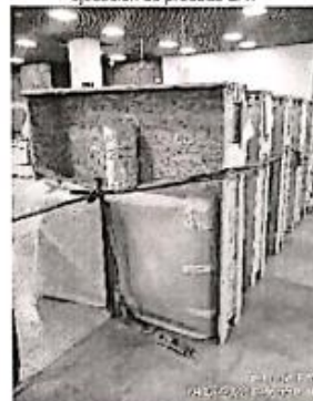
Fotografía 14: Puertas de acceso instaladas, pendiente ejecución de pruebas SAT
