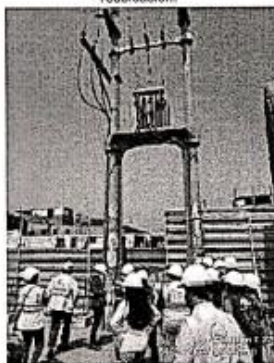
Fotografía 21: Inspección de la Subestación Eléctrica existente, OSITRAN señaló que OSINERGMIN deberá definir su reubicación.
