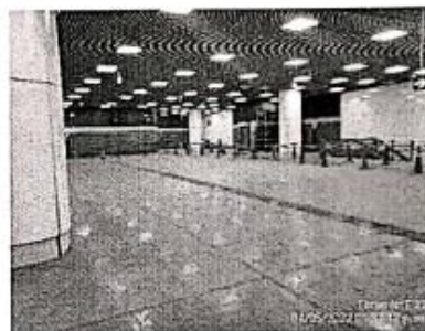
Fotografía 22: Obras civiles y de arquitectura terminadas
