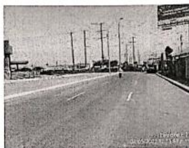
Fotografía 20: Obras de superficie de inserción urbana, terminadas por el Concesionario
