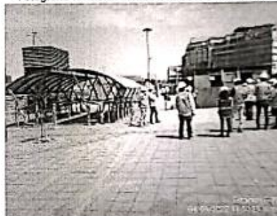
Fotografía 16: Obras de inserción urbana terminadas.
