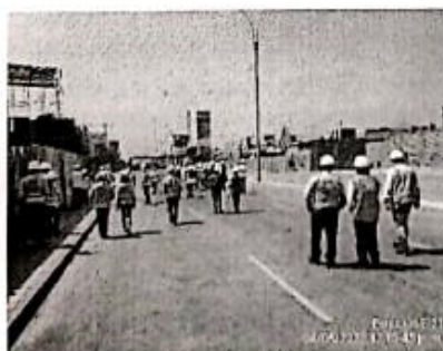
Fotografía 17: Inspección a bases del puente peatonal ubicado en la Estación E21.
