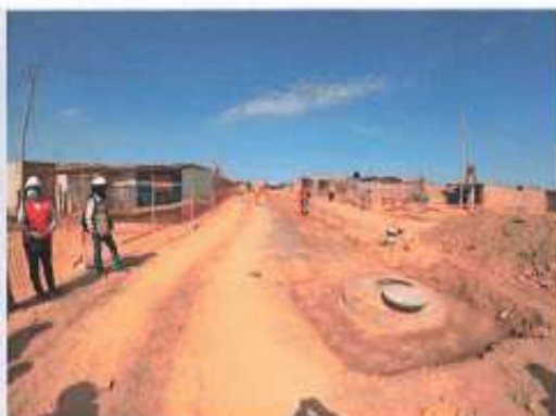
Foto 6: Trabajos de compactación posterior a prueba hidráulica con zanja abierta.
