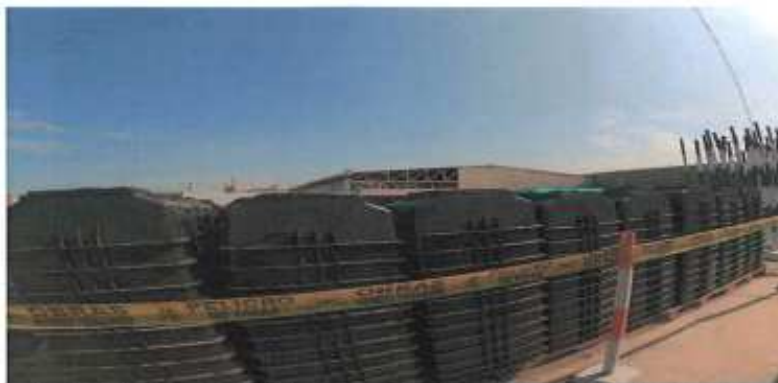
Foto 3: Cajas termoplásticas para conexiones domiciliarias de agua sin protección
