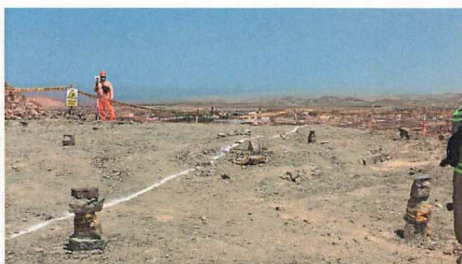
Foto 9: Pendiente de ejecutar los trabajos de colocación de solado en el reservorio.
