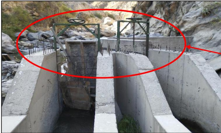
Se aprecia que las compuertas se encuentran en mal estado (inservibles); además, el acero de refuerzo se encuentra a la intemperie sin ningún tipo de protección.
