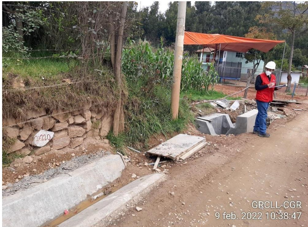
23. Se identificó 1 alcantarilla en el km 2+226 sin culminar rellenos de estructuras y emboquillados de salida.
