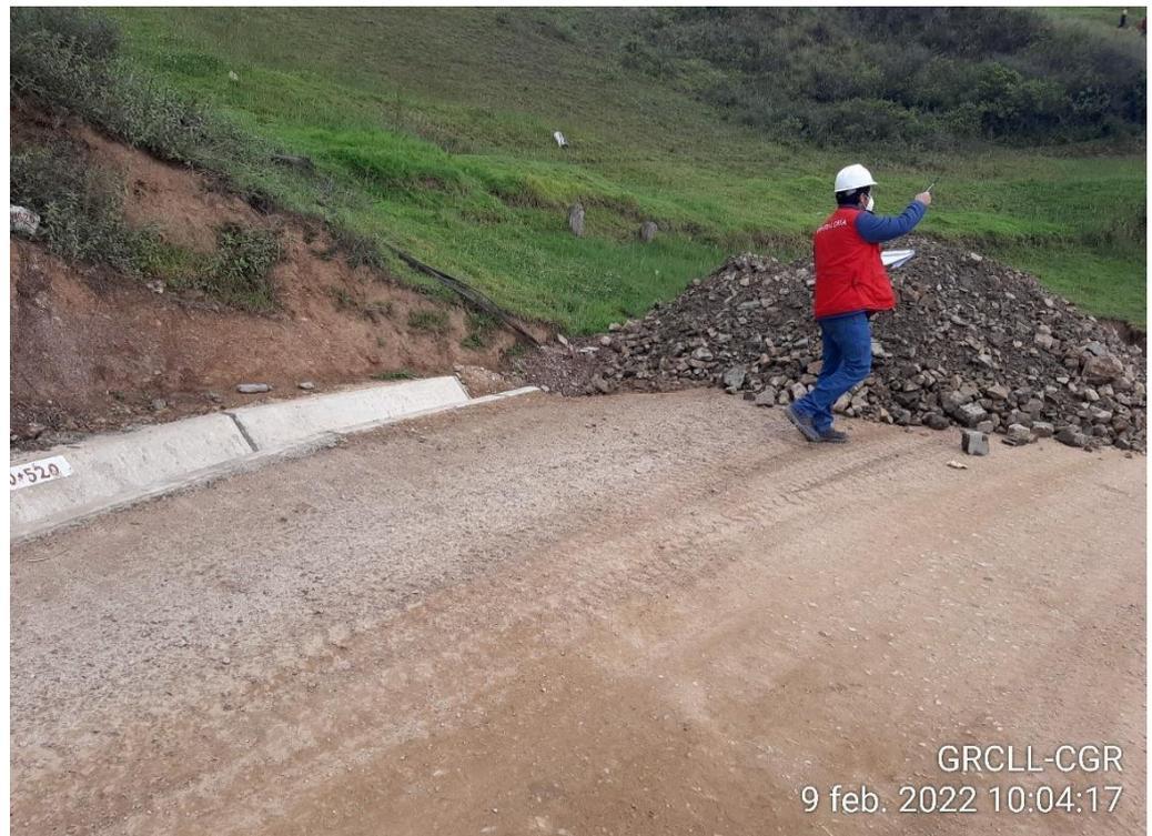
12. Se identificó una (1) alcantarilla en el km 0+570, con falta de relleno de estructuras, asimismo emboquillado de entrada y salida. (...) se identificó bolsas de cemento utilizadas.
