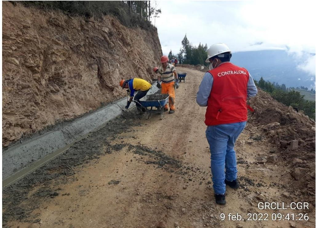
5. Se identificó la ejecución de perfilado de cunetas y colocación de cerchas del Km 0+160 al km 0+180.
