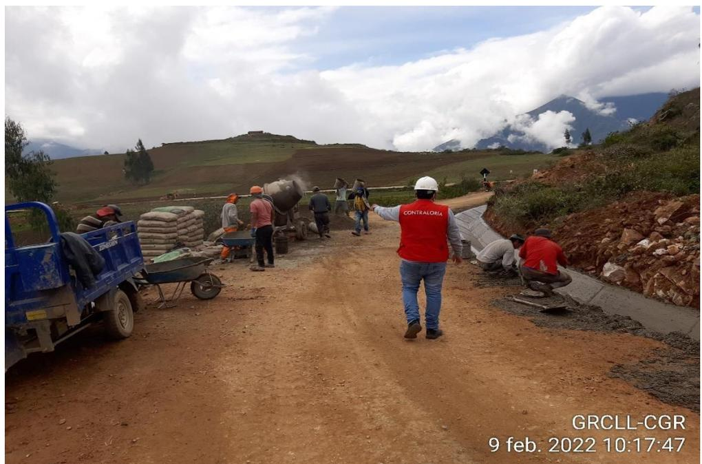
17. Se identificó concreto para cunetas recién vaciado del km 1+030 al km 1+110 que se encuentran sin sellados de juntas.
