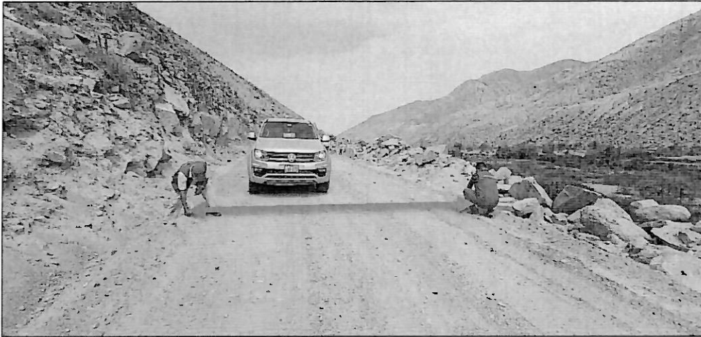
IMAGEN N° 1 TRAMO CON AFIRMADO (BASE ESTABILIZADA) EN PROGRESIVA 28+950
