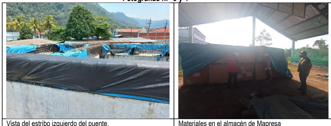
Vista del estribo izquierdo del puente.
