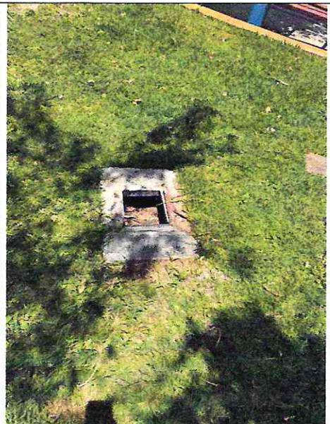
**Imagen n° 175:** Caja de concreto de agua sin tapa.
