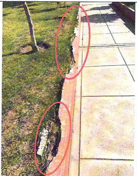
**Imagen n° 68:** Jardineras de concreto rotas y despintadas.
