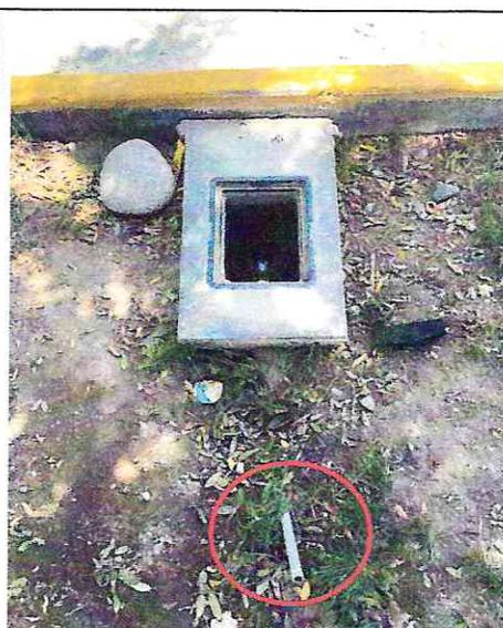
Imagen n° 30: Caja de concreto de agua sin tapa y con tubería expuesta.
