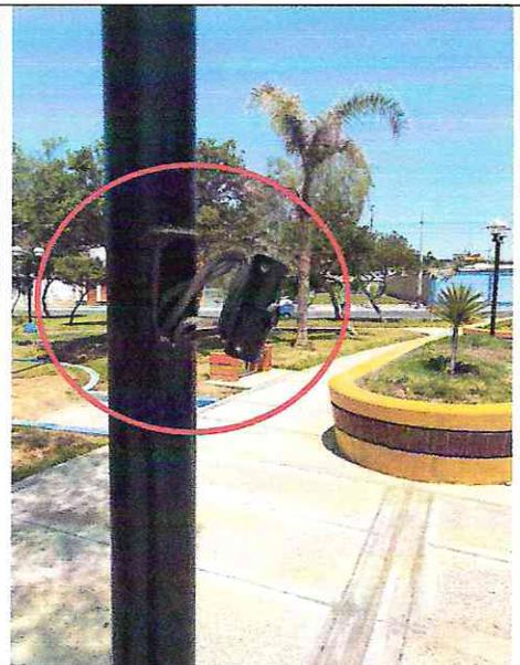
**Imagen n° 146:** Poste de luz sin tapa de caja de registro, con cables expuestos.
