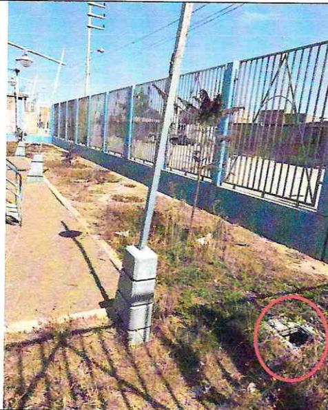
Imagen n° 11: Caja de concreto de agua sin tapa.
