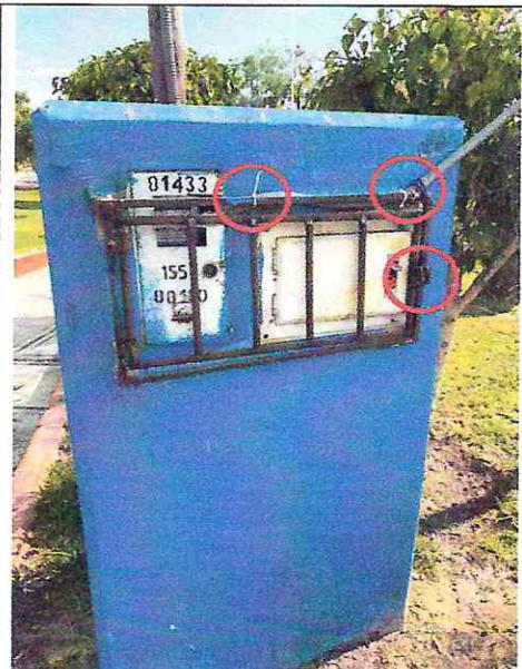
**Imagen n° 66:** Cable de ingreso al medidor de luz está sujetado por medio de cables y cintillos, la rejilla metálica del muro que contiene el medidor de luz no tiene candado.
