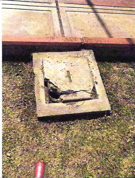
Imagen n° 124: Caja de concreto de agua con la tapa rota.
