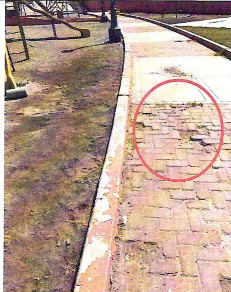
Imagen n° 123: Adoquines de concreto coloreados de caminarias rotos y desgastados.
