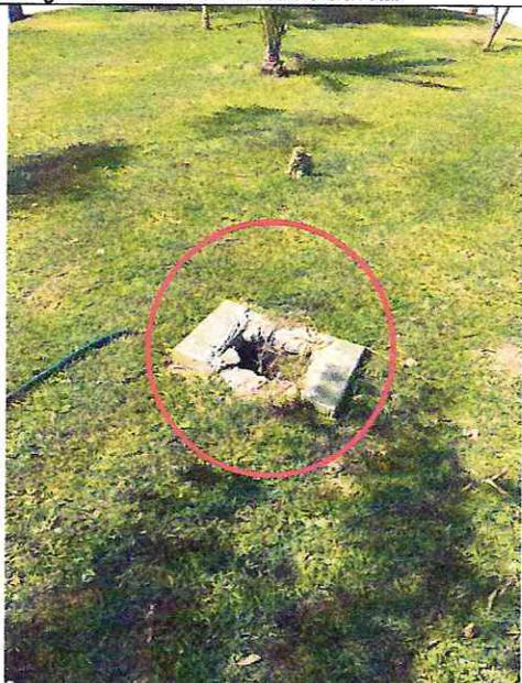
Imagen n° 50: Caja de concreto de agua en mal estado y sin tapa.
