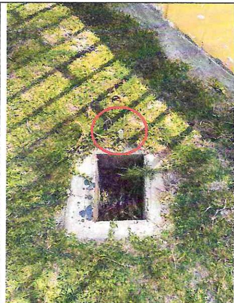
Imagen n° 109: Caja de concreto de agua sin tapa y con tubería expuesta.
