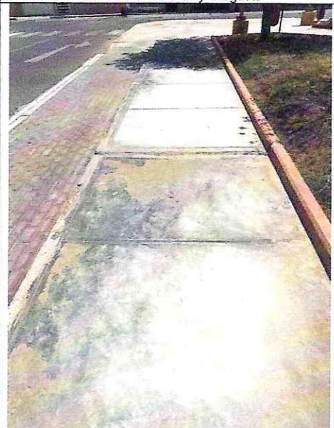
**Imagen n° 115:** Veredas de concreto con fisuras y desgaste.
