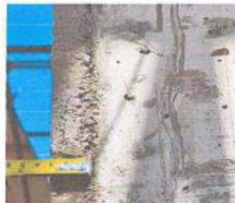
Vista fotográfica: Espesor de tarrajeo de columna en la cisterna 1.
