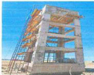
Vista fotográfica: Rolizos y soportes metálicos en la cisterna 1.
