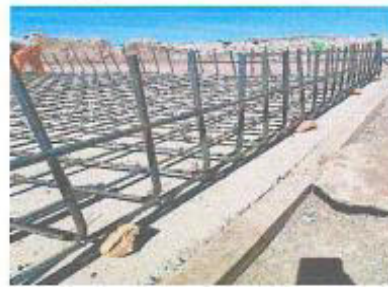
Vista fotográfica: Piedras irregulares usadas como dados de concreto para separación de malla de acero – base lado izquierdo.
