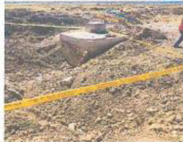
Vista fotográfica: Estructura CP 1 sin relleno en uno de sus costados.
