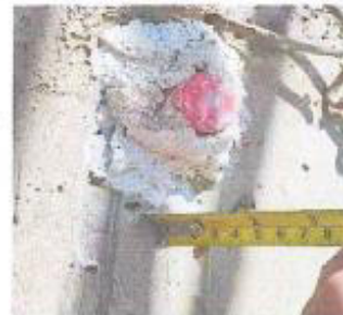
Vista fotográfica: Espesor de tarrajeo de columna en la cisterna 1.
