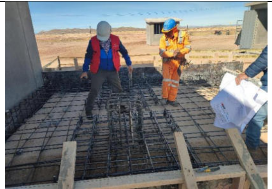
Vista fotográfica N° 6.- Constatación de dimensiones en armado de mallas de refuerzo en cimentación para planta compacta de agua potable - 20.05.22.
