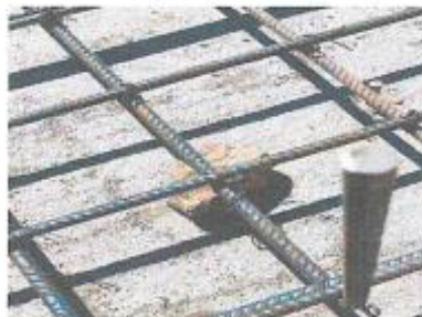
Vista fotográfica: Piedra irregular usada como dado de concreto para separación de malla de acero – base lado derecho.
