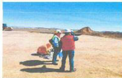
Vista fotográfica: Plataforma de la PTAR; nótese que no se cuenta con cerco perimétrico.
