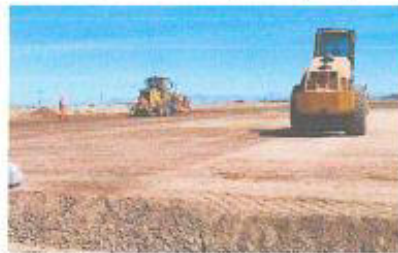
Vista fotográfica: Conformación de capa de transferencia en la PTAR.
