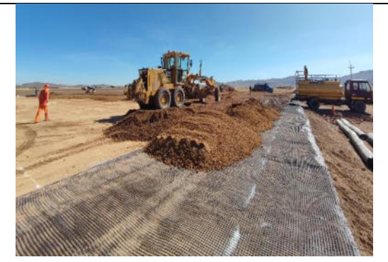
Vista fotográfica N° 8.- Tendido de material sobre la geomalla uniaxial - 17.05.22.
