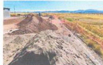
Vista fotográfica: Trazo de alineamiento donde se ejecutará el cerco perimétrico.
