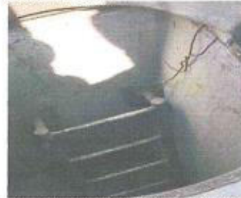
Vista fotográfica: Escalera de gato pendiente de instalación en la estructura.
