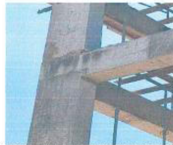
Vista fotográfica: Detalle de resane de columna en la cisterna 2.
