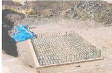
Vista fotográfica: Barras verticales de la malla de acero sin capuchones – lado derecho; nótese que este frente está sin personal obrero.
