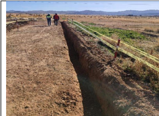
Vista fotográfica N° 5.- Excavación de zanja en terreno natural en lado derecho del cerco perimétrico; sin ejecución de actividades sucesoras al término de la visita de constatación- 20.05.22.
