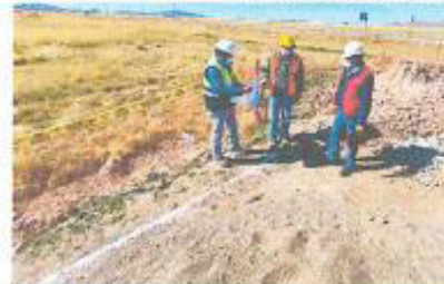
Vista fotográfica: Contorno donde se ejecutará el cerco perimétrico.
