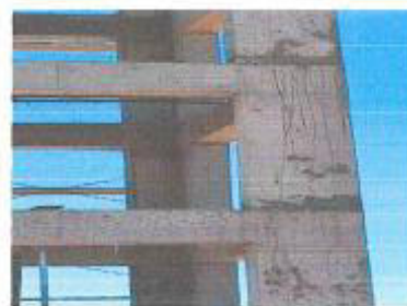
Vista fotográfica: Resane en base de columnas del reservorio 1.
