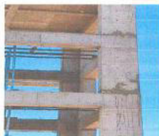
Vista fotográfica: Resane en base de columnas del reservorio 1.
