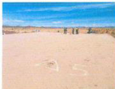
Vista fotográfica: Plataforma donde se ubicará la cámara de bombeo; nótese punto de control topográfico.
