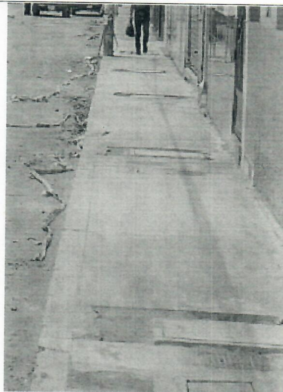
Vista de zanjas en vereda, con relleno de arena fina, hasta el nivel -0,10m de vereda terminada (existente) en tramo entre buzones n.ºs 1 y 2, del sector Avenida Oriente.
