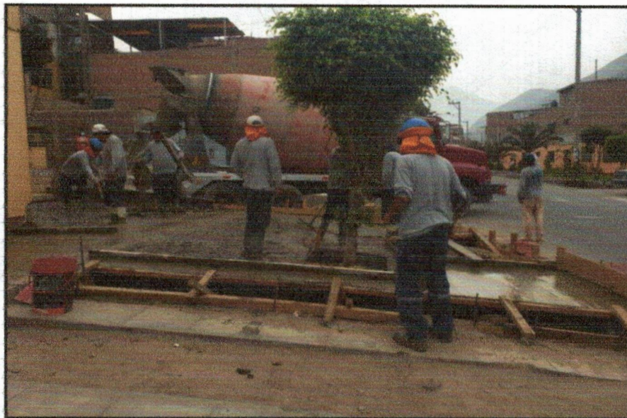
Foto n.º01 Trabajos de colocación de concreto en Martillos Calle Dacitas
