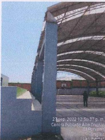
Imagen n.º 30: Armadura que descansa sobre columnas de concreto.
