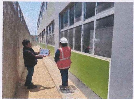
**Imagen n.º 1:** No se aprecia junta sismica con espuma plástica entre tabiques.
