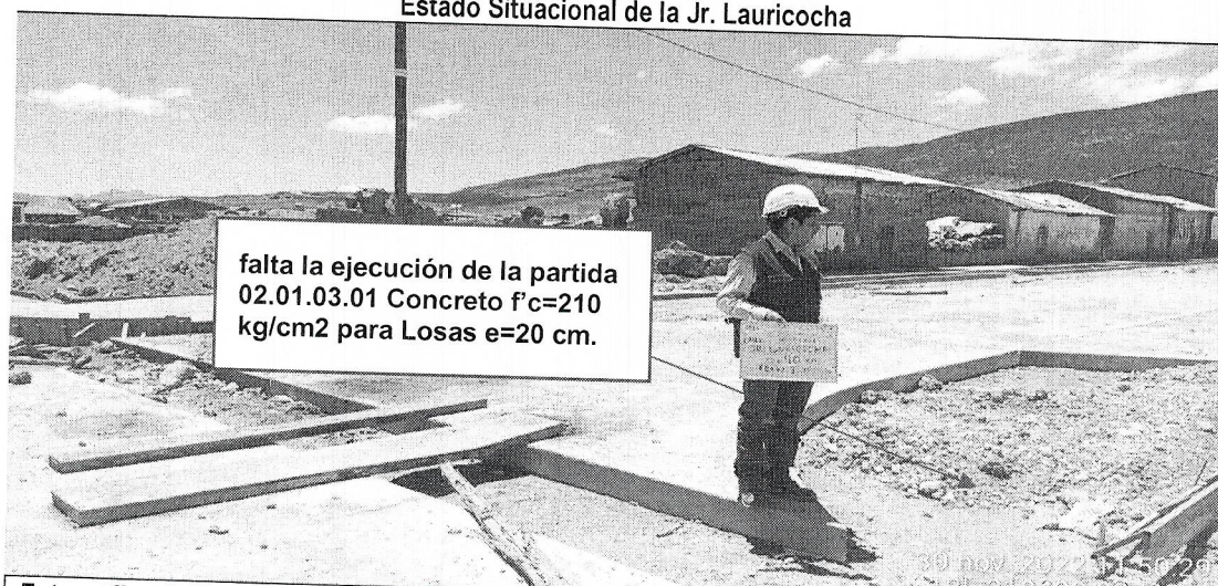
Fotografía n.º 10: Falta de ejecución de la partida de concreto para losas, en la progresiva 0+110 k.m. del Jr. Lauricocha.
