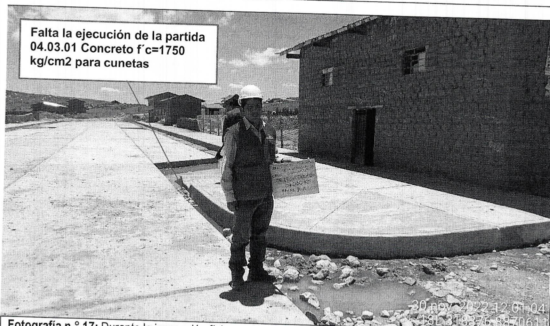
Fotografía n.º 17: Durante la inspección física se identificó que no ejecutó la partida de concreto en cunetas y losa en la progresiva 0+080 k.m. del Jr. León Dormido.
