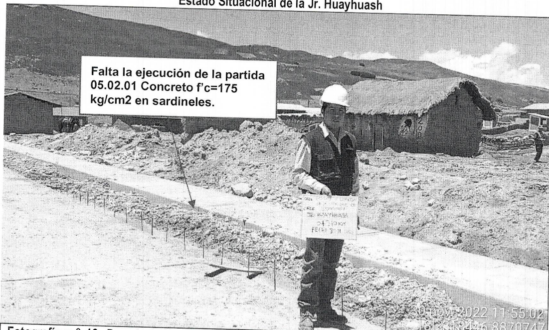
Fotografía n.º 13: Durante la inspección física se identificó que no se ejecutó la partida de concreto en sardineles en la progresiva 0+310 k.m. del Jr. Huayhuash.
