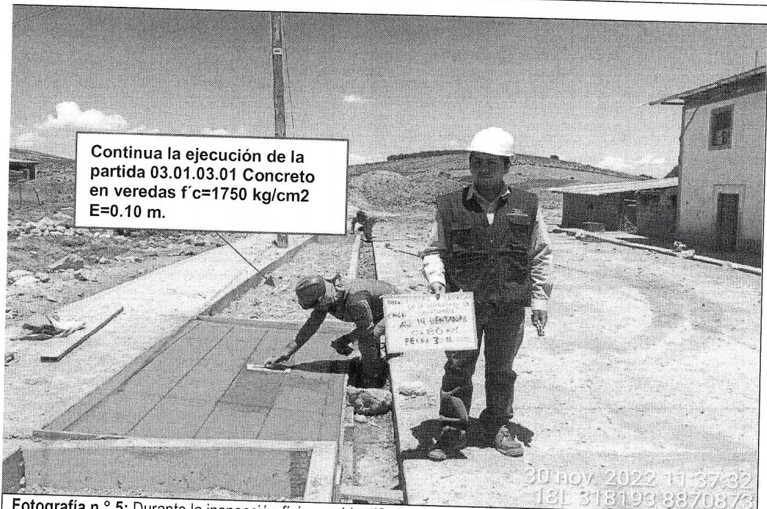
Fotografía n.º 5: Durante la inspección física se identificó personal obrero, continuando con la ejecución de la partida concreto para rampas.
