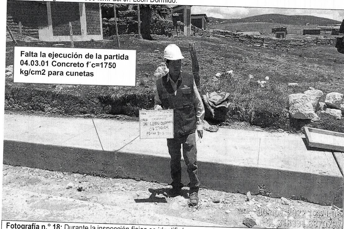
Fotografía n.º 17: Durante la inspección física se identificó que no ejecutó la partida de concreto en cunetas y losa en la progresiva 0+080 k.m. del Jr. León Dormido.
