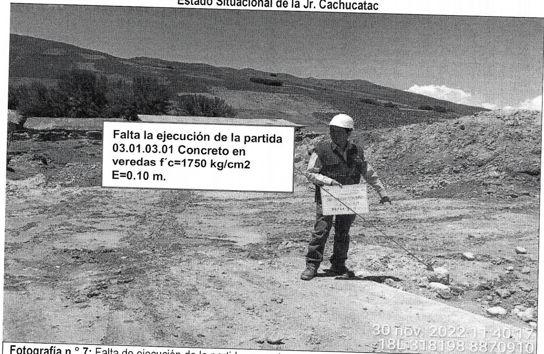
Fotografía n.º 7: Falta de ejecución de la partida concreto en veredas en la progresiva 0+000 k.m. en la Calle Cachucatac.
