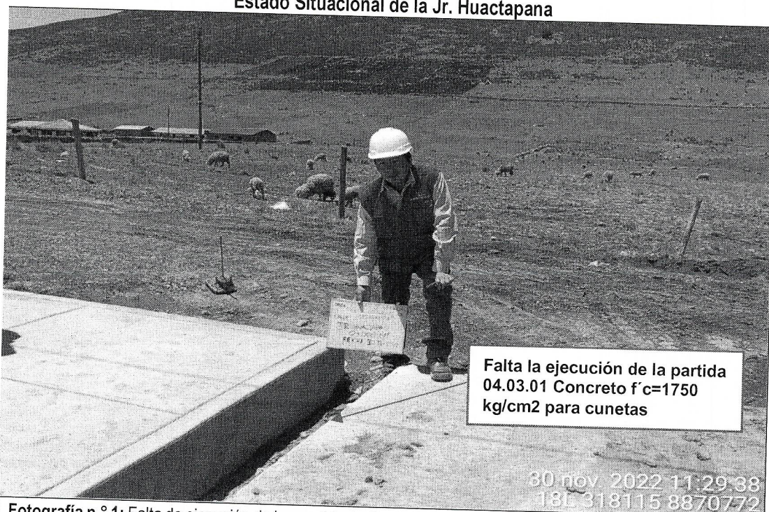
Fotografía n.º 1: Falta de ejecución de las partida de Concreto en la Progresiva 0+000 k.m. del Jr. Huactapana.
